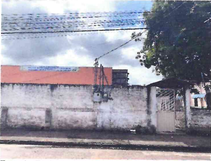
Foto 1 - Fachada da Creche R.M.M.
