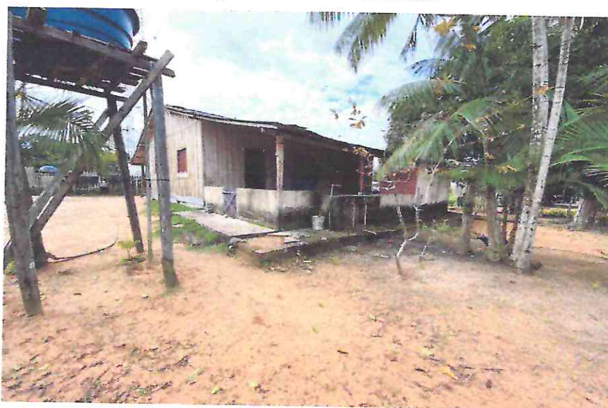
Imagem 4 – Fachada Dos Fundos.
