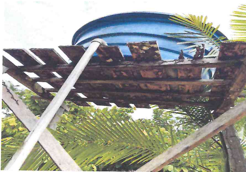
Imagem 13 – Estrutura Da Caixa D'água.
