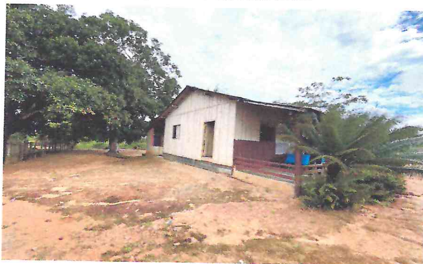
Imagem 3 – Fachada Lateral Direita.
