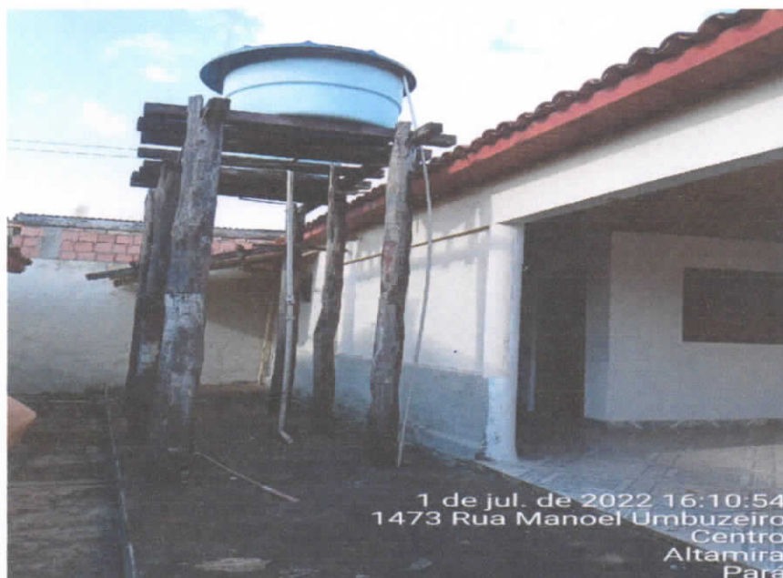
Imagem 17 – Estrutura de caixa d'água.
