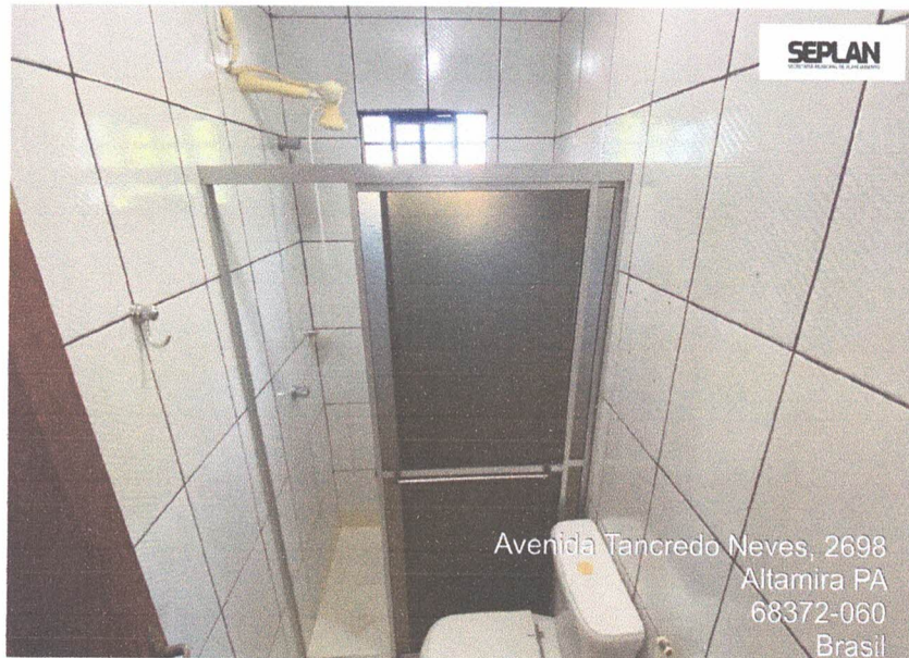
Imagem 21 – Banheiro 1º Pav.
