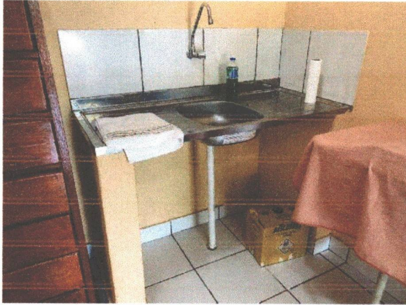
Figura 21: Troca da torneira e manutenção na tubulação.
