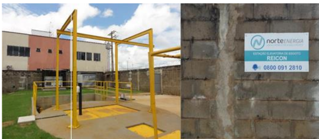
Figura 55: Vista da Elevatória Reicon
