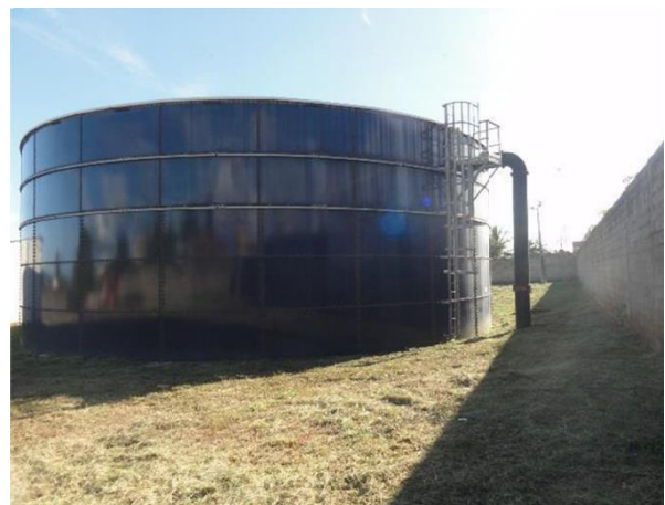
Figura 47: Vista do RAP 06 Santa Ana com capacidade para 1.000 m 3
