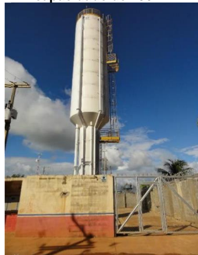
Figura 43: Vista do REL Bela Vista, capacidade de 150 m 3
