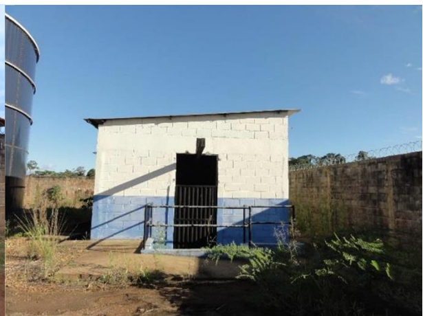
Figura 49: Vista da Casa de Bombas
