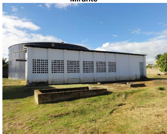
Figura 40: Elevatória que abriga os conjuntos motor bombas que interliga o RAP 03 aos Setores Mutirão, Sant Ana e Mirante
