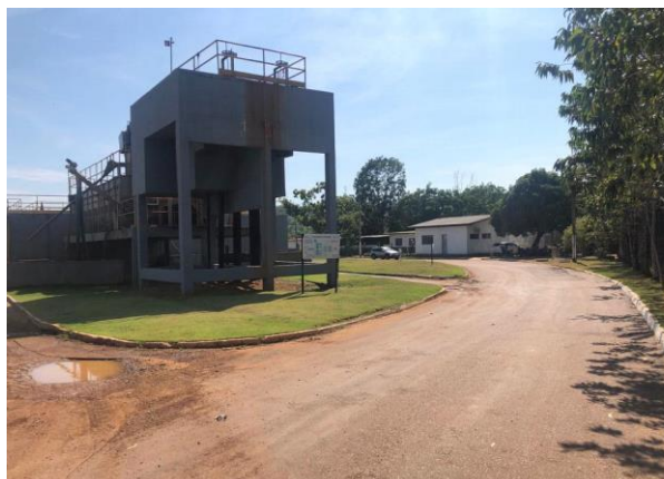
Figura 60: Vista da caixa de entrada e do Tratamento Preliminar
