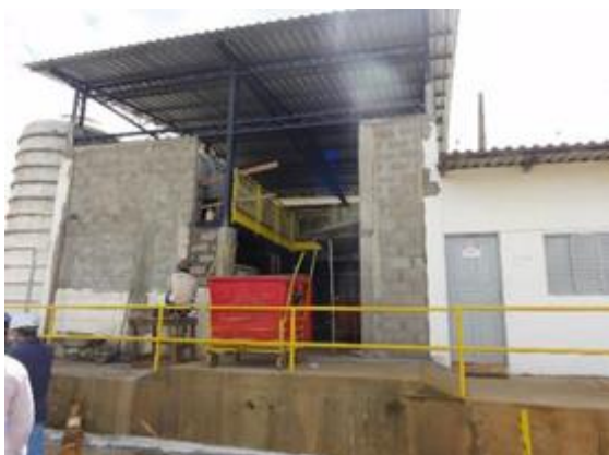
Figura 69: Tanque de Lodo e casa de lodo
