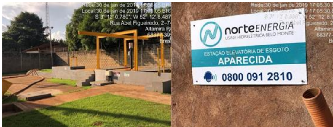
Figura 56: Vista da Elevatória Aparecida
