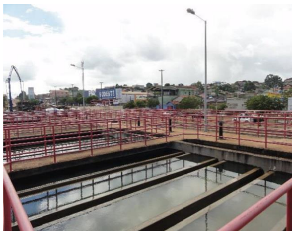
Figura 29: Vista dos Decantadores
