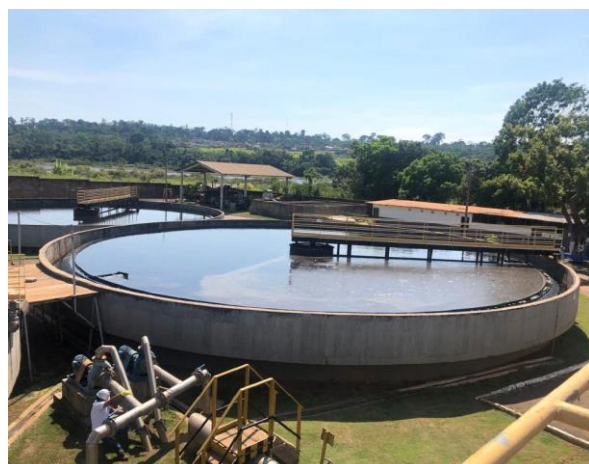
Figura 65: Vista dos Decantadores
