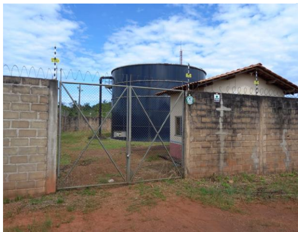
Figura 48: Entrada do RAP 07 – Colinas
