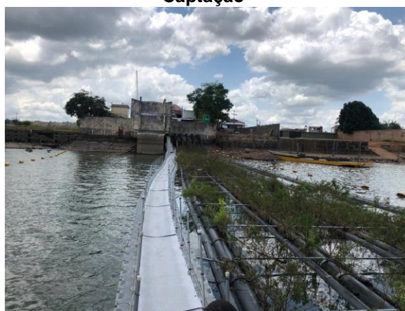
Figura 23: Linhas de recalque da Nova Captação que se interligam à Antiga Captação
