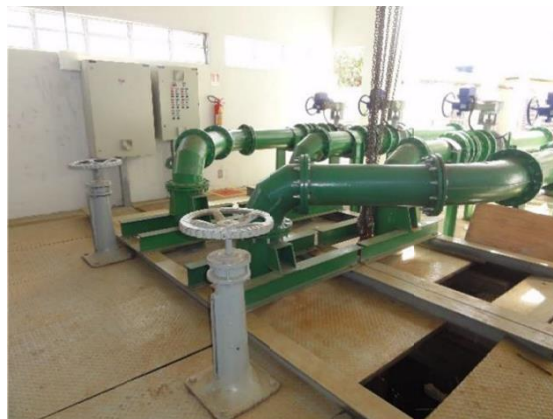
Figura 21: Barrilete de saída – Antiga Captação
