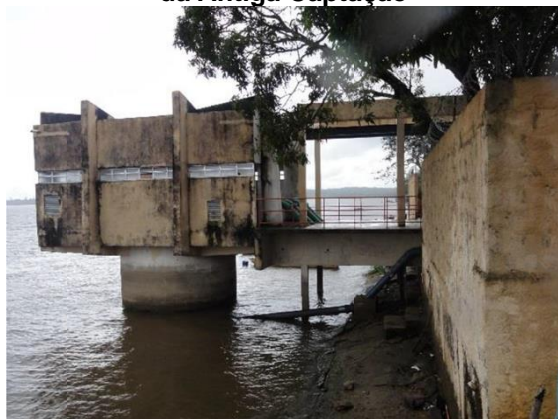
Figura 20: Vista da estrutura tubular, em concreto, onde estão instaladas as bombas da Antiga Captação
