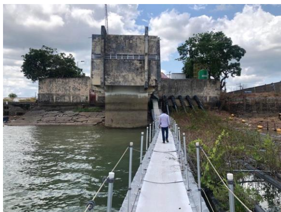
Figura 18: Vista geral da estrutura da Antiga Captação
