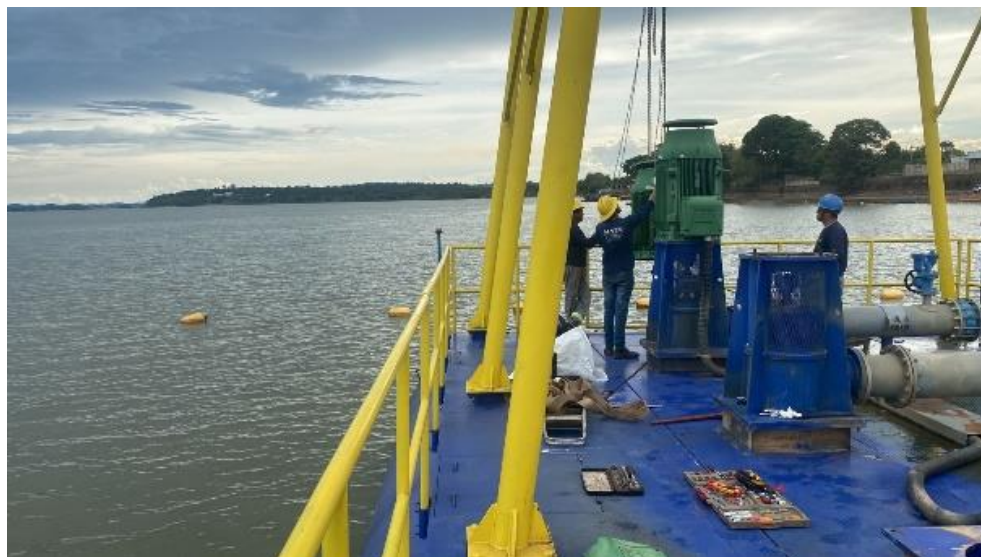
Reinstalação da Bomba 01 da captação flutuante de água bruta
