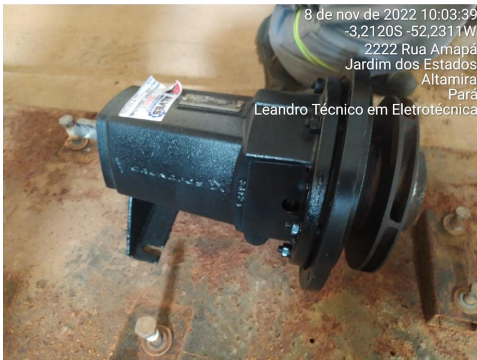
Reinstalação da Bomba 01 da captação flutuante de água bruta
