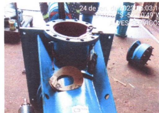
Troca de Rolamento e Retentor Bomba 1
