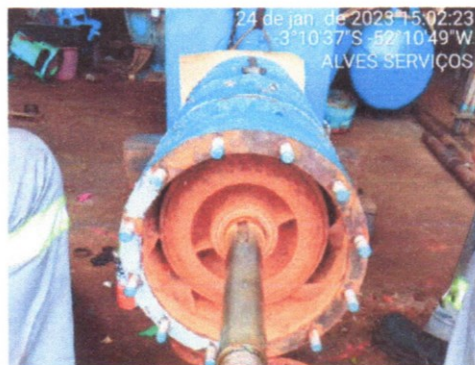
Troca de Rolamento e Retentor Bomba 5
