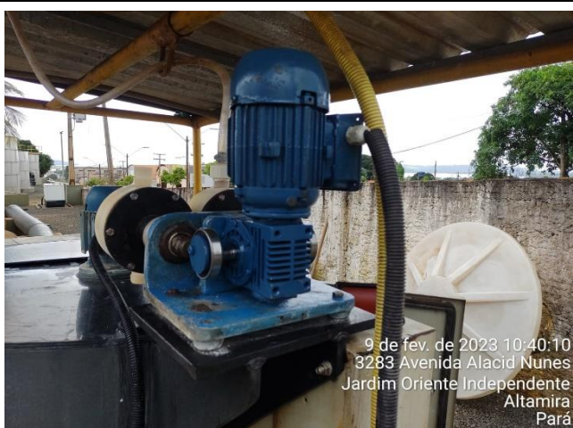
MANUTENÇÃO DO MOTOR DE DOSAGEM DE BARRILHA
