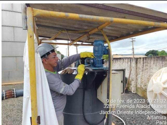
MANUTENÇÃO DO MOTOR DE DOSAGEM DE BARRILHA
