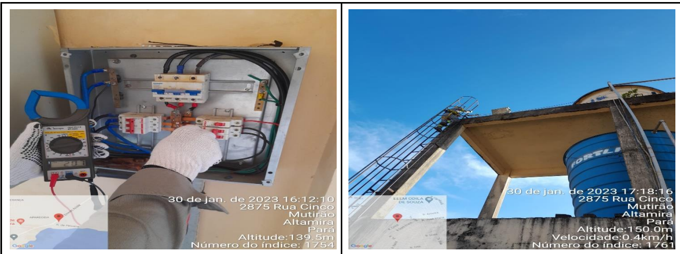
SUBSTITUÍDO UM DISJUNTOR QUE ESTAVA DANIFICADO NO REL PAIXÃO DE CRISTO
