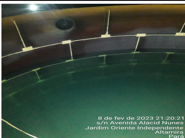
ATIVIDADE DE SECAGEM DO FLOCULADOR 01, PARA MANUTENÇÃO DE LIMPEZA DO DECANTADOR 01
