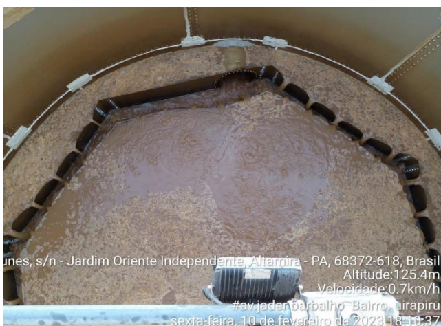
LAVAGEM EM FILTROS DA ESTAÇÃO MODULAR
