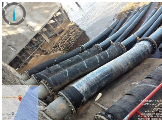
TROCA DOS MANGOTES DA CAPTAÇÃO
