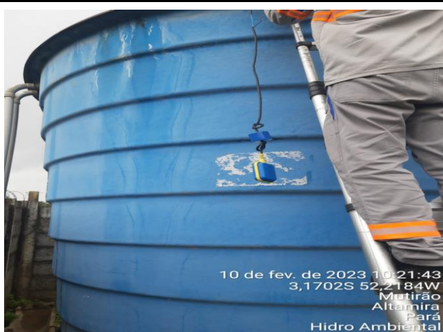
SUBSTITUIÇÃO DA CHAVE BOIA DO POÇO DO RUC ÁGUA AZUL
