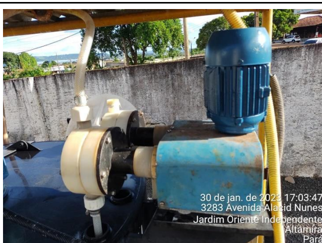
INSTALAÇÃO DO MOTO REDUTOR DA BOMBA DOSADORA DE BARRIGA DA ETA
