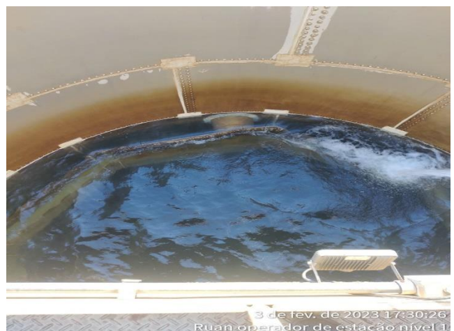
LAVAGEM EM FILTROS DA ESTAÇÃO ETA MODULAR
