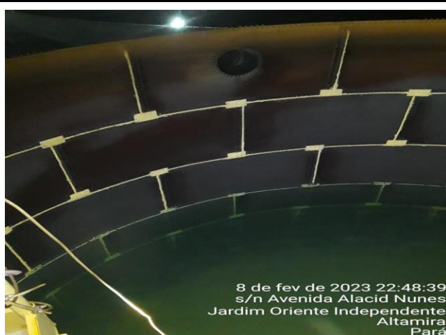
ATIVIDADE DE SECAGEM DO FLOCULADOR 01, PARA MANUTENÇÃO DE LIMPEZA DO DECANTADOR 01
