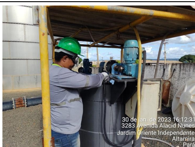
INSTALAÇÃO DO MOTO REDUTOR DA BOMBA DOSADORA DE BARRIGA DA ETA
