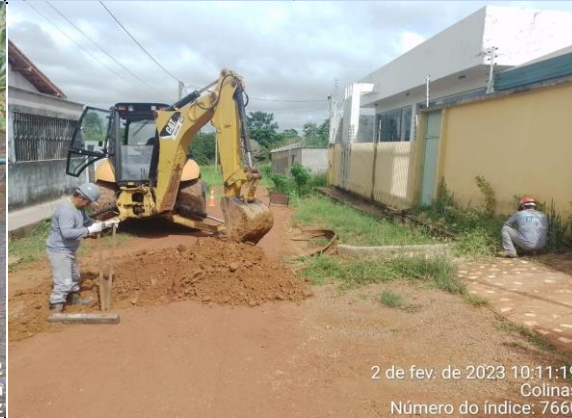
Figura 4: Rua Varginha Reparo em RDA
