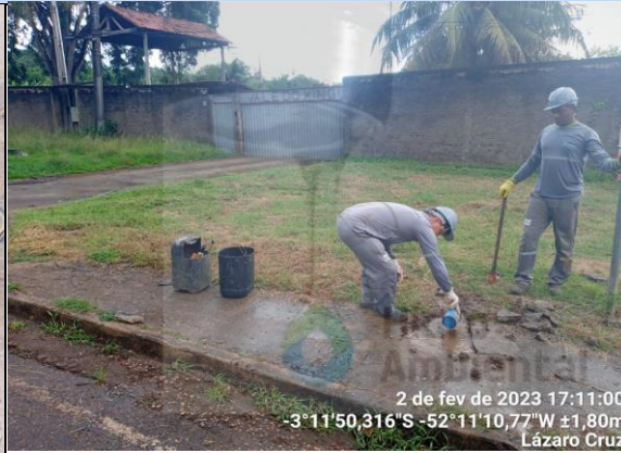
Figura 2: Avenida Presidente Mendes Reparo em RPA
