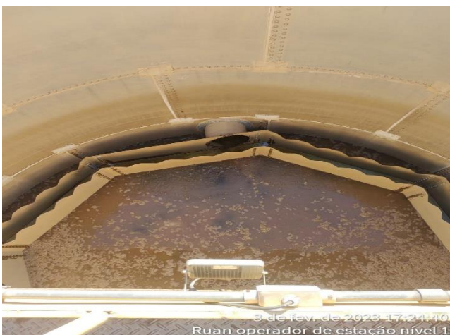
LAVAGEM EM FILTROS DA ESTAÇÃO ETA MODULAR
