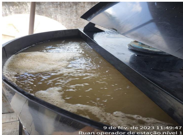
ABASTECIMENTO DE SAL NO RESERVATÓRIO BARRILHA
