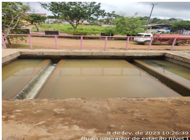
LAVAGEM EM FILTROS DA ESTAÇÃO CONVENCIONAL (COSALT)
