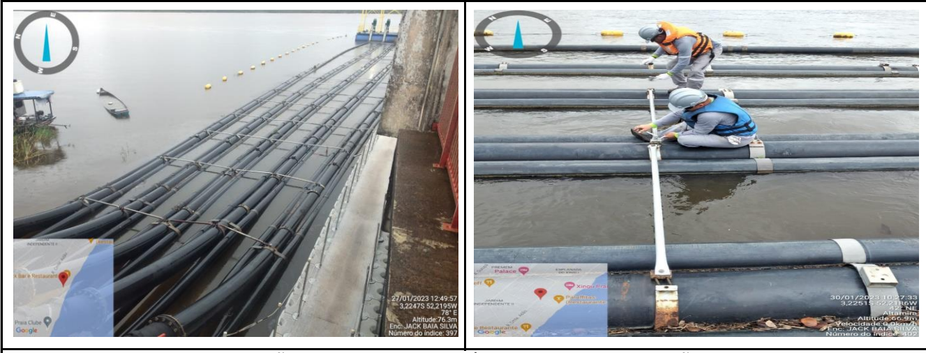
FIXAÇÃO DAS ADUTORAS DE ÁGUA BRUTA NA CAPTAÇÃO
