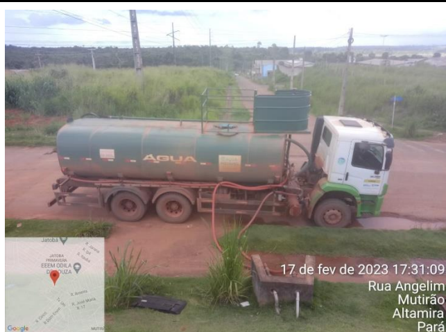
ABASTECIMENTO RUC JATOBÁ (RUA ANGELIM)
