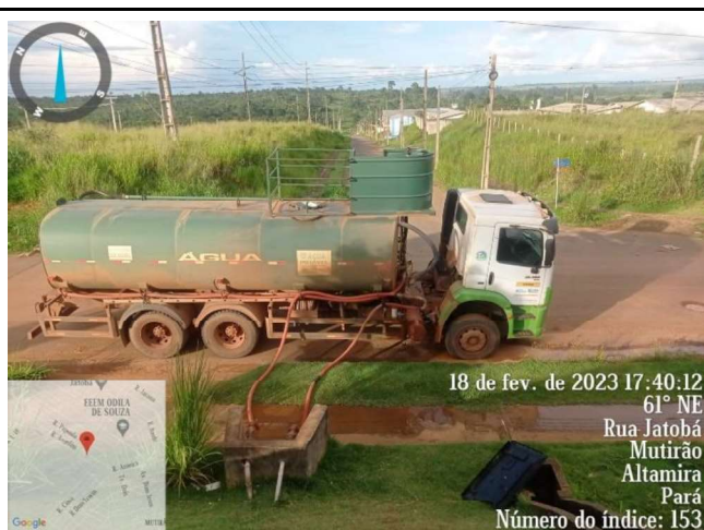
ABASTECIMENTO RUC JATOBÁ (RUA ANGELIM)
