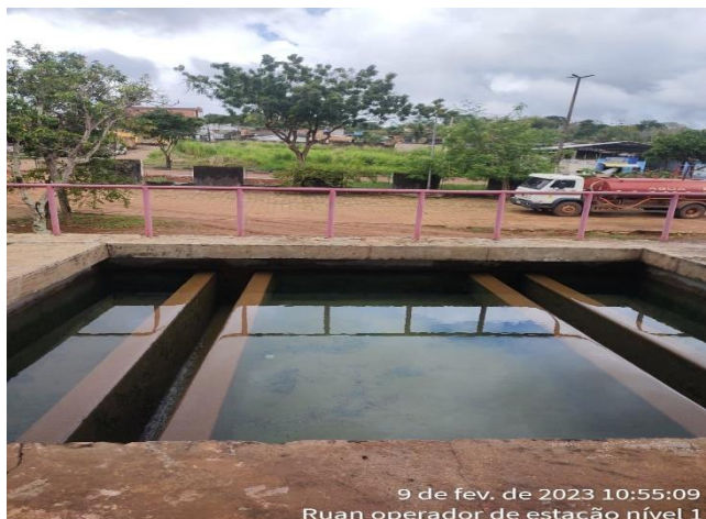
LAVAGEM EM FILTROS DA ESTAÇÃO CONVENCIONAL (COSALT)
