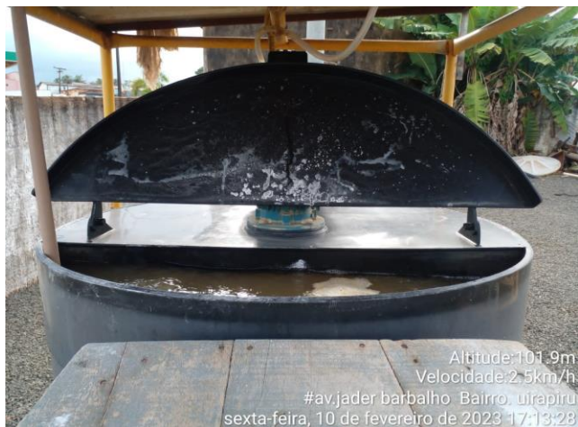
ABASTECIMENTO DE SAL NO RESERVATÓRIO BARRILHA
