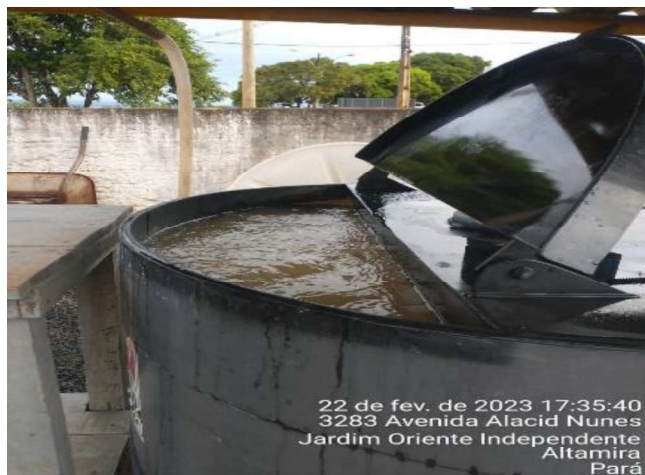
ABASTECIMENTO DE SAL NO RESERVATÓRIO BARRILHA
