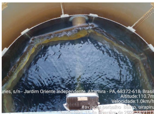
LAVAGEM EM FILTROS DA ESTAÇÃO MODULAR
