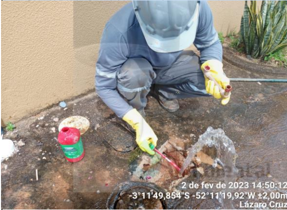
Figura 3: Rua Anápolis Reparo em RPA
