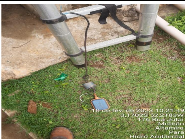
SUBSTITUIÇÃO DA CHAVE BOIA DO POÇO DO RUC ÁGUA AZUL
