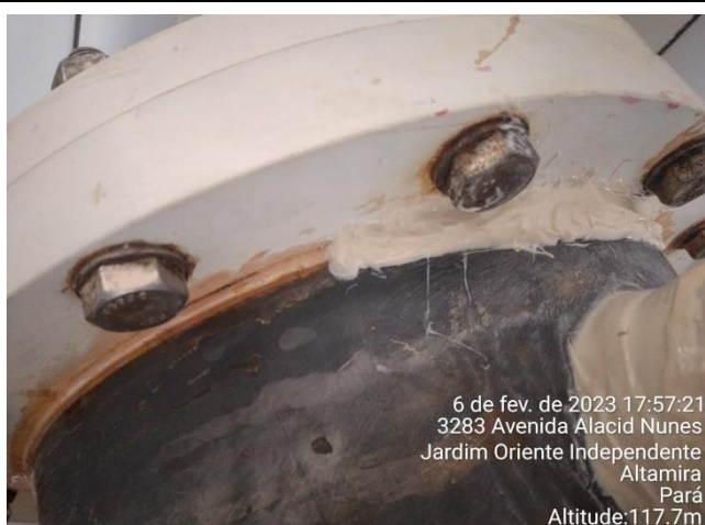
MANUTENÇÃO EM REATOR DE CLORO HG PLUS (02)
