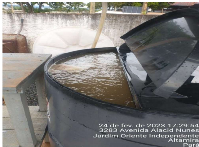
ABASTECIMENTO DE SAL NO RESERVATÓRIO BARRILHA
