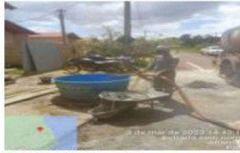
FOTO 01: RUA JURUNA CASA Nº 17
