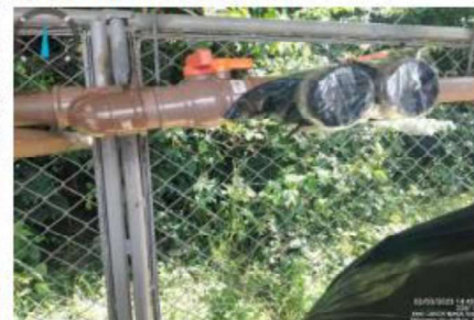
FOTO 04: RUA IRACEMA CASA Nº 54
