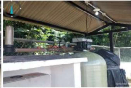
FOTO 02: RUA XIPAIA CASA Nº 30
