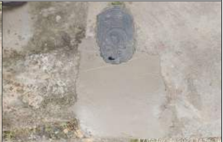
FOTO 02 – Durante a execução do serviço houve escavação, reaterro, compactação manual e mecanizada. Para isso, utilizaram-se 0,2m 3 de areia e meio saco de cimento;
