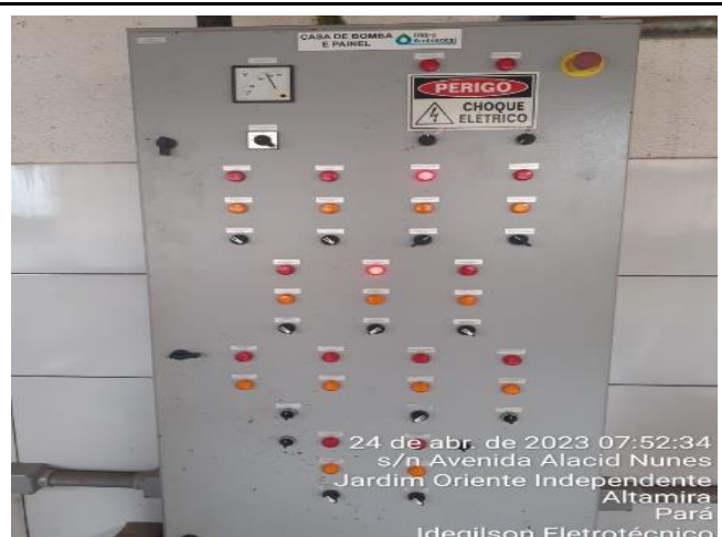
REVEZAMENTO EM BOMBAS DE PRESSURIZAÇÃO DA BOMBA 02 PARA BOMBA 03
