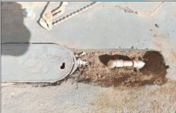
FOTO 03 – Salientamos que para realizar a conexão entre a espera e o hidrômetro também foi preciso utilizar dois joelhos de 20mm de diâmetro. Demanda atendida.
