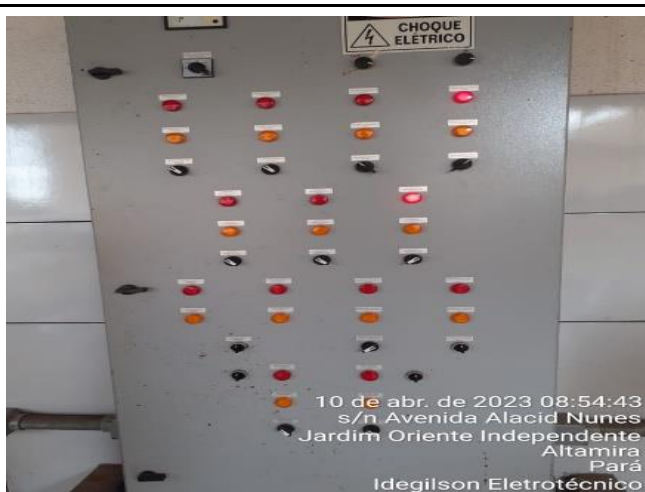
REVEZAMENTO EM BOMBAS DE PRESSURIZAÇÃO DA BOMBA 02 PARA BOMBA 03
