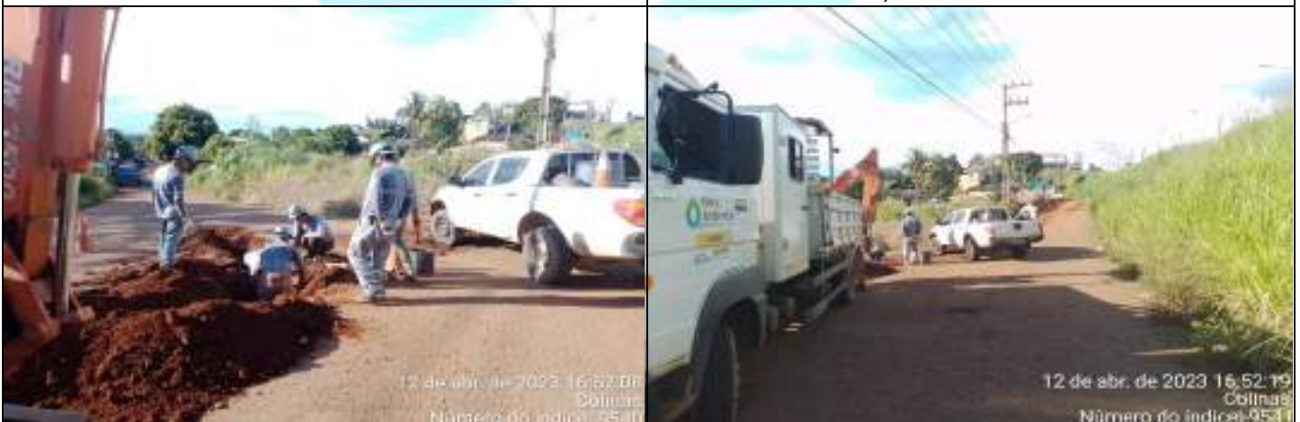
FOTO 03 - na inspeção foi realizado a ligação do ramal de água até a caixa de água da residência.
