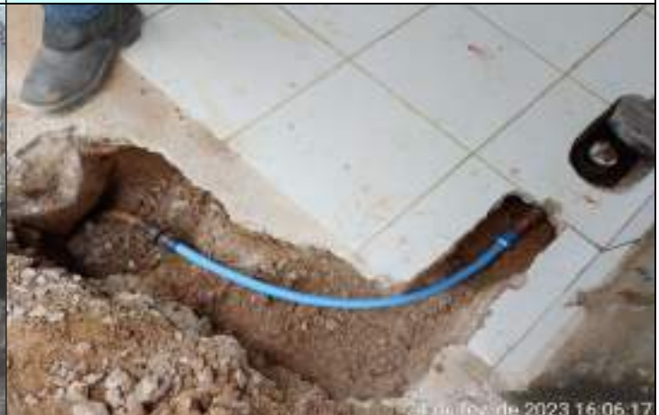
FOTO 04 – Salientamos que para realizar a conexão entre a espera e o hidrômetro também foi preciso utilizar duas luvas LR e um metro de tubo PEAD, ambos com 20mm de diâmetro. Demanda atendida.
