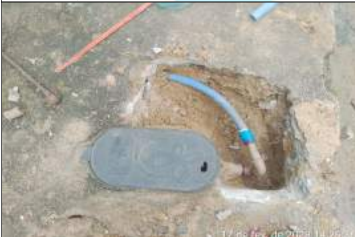
FOTO 03 – Salientamos que para realizar a conexão entre a espera e o hidrômetro foram utilizados uma luva LR e 0,4 metro de tubo PEAD, ambos com 20mm de diâmetro. Demanda atendida.
