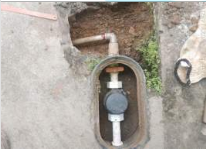
FOTO 03 – Salientamos que para realizar a conexão da espera ao hidrômetro, também foi preciso utilizar um joelho de 20mm de diâmetro. Demanda atendida.
