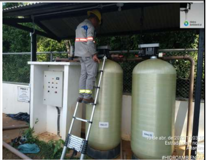
FOTO 4- Identificamos que além das engrenagens a placar do filtro esta com problema.
