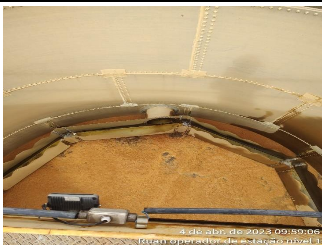
LAVAGEM EM FILTROS DA ESTAÇÃO MODULAR
