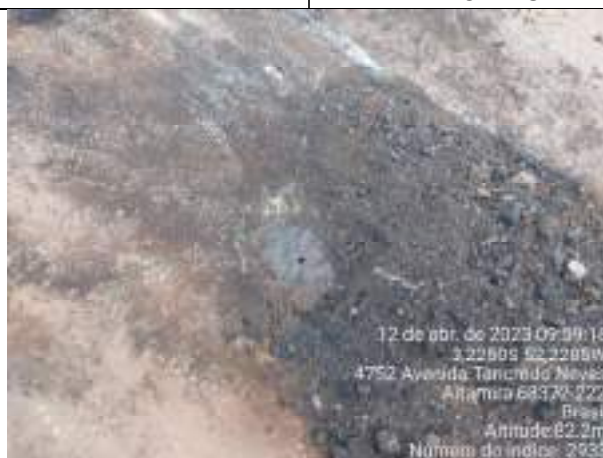
AV TANCREDO NEVES COM A RUA ELIAS LEITÃO
