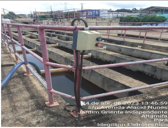
INSTALAÇÃO DE UM PONTO DE ENERGIA, PRA LIGAR BOMBA QUANDO FOR FAZER A LAVAGEM DOS DECANTADORES
