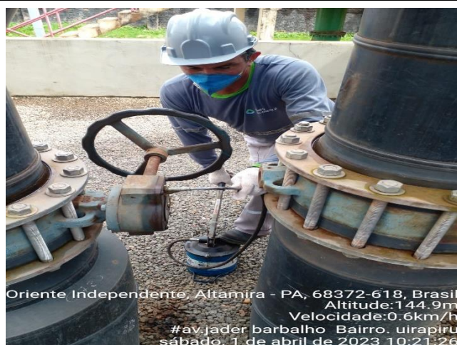
LUBRIFICAÇÃO DO ROLAMENTO DO MISTURADOR DE POLÍMERO
