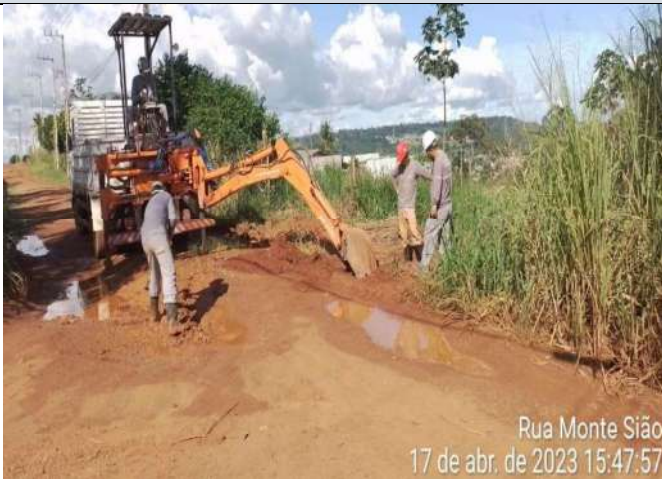
RUA HORÁCIO BOANERGES- BAIRRO BRASÍLIA
