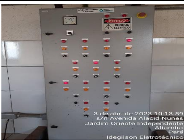
REVEZAMENTO EM BOMBAS DE PRESSURIZAÇÃO, DE BOMBA 01 PARA BOMBA 02
