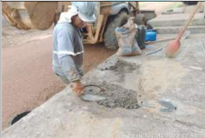
FOTO 03 – Para isso, utilizaram-se 0,2m 3 de areia e meio saco de cimento;
