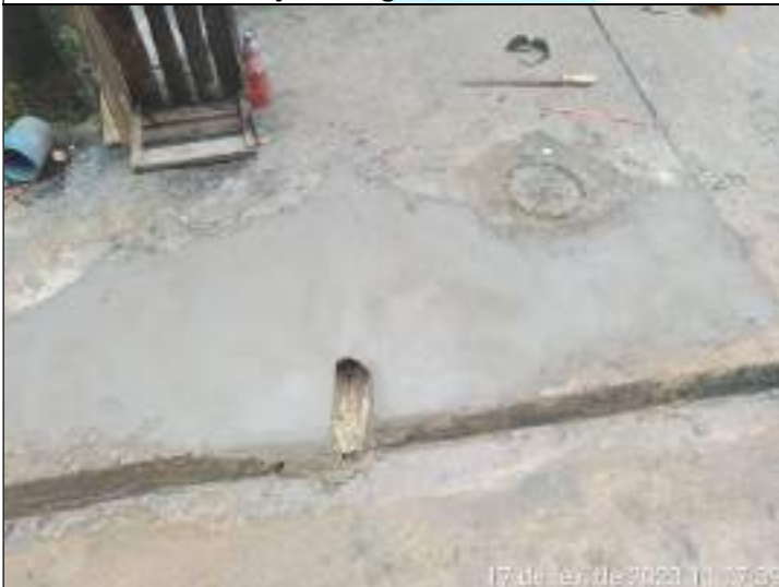
FOTO 03 – Salientamos que para a execução do serviço houve escavação, reaterro, compactação manual e mecanizada;
