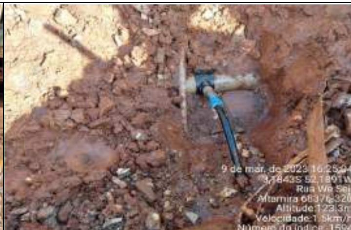
FOTO 02 – Foi realizado o reparo em RDA. O vazamento foi controlado e o fluxo voltou ao normal. Demanda atendida
