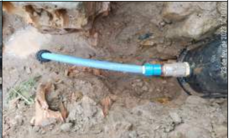
FOTO 04 – Salientamos que para realizar a conexão entre a espera e o hidrômetro também foi preciso utilizar duas luvas LR e 0,3 metro de tubo PEAD, ambos com 20mm de diâmetro. Demanda atendida.
