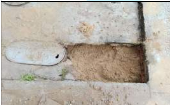
FOTO 03 – Para isso, utilizaram-se 0,2m 3 de areia e meio saco de cimento;
