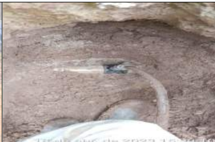
FOTO 02 – na inspeção foi identificado vazamento no ramal de distribuição, foi realizado o reparo retirando o vazamento. Demanda atendida.
