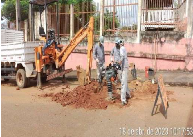
TRAVESSA CAPTÃO PEREIRA- BAIRRO BRASÍLIA
