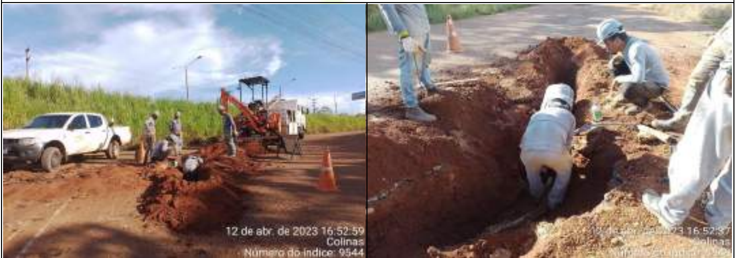
FOTO 01 - Rod. Ernesto Acioli, Nº80-81-82-84-85-86-107, Bairro Colinas
