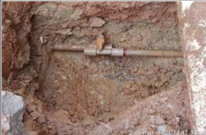
FOTO 01 – JUCA BORGES DE OLIVEIRA, 40, ALBERTO SOARES No monitoramento a nossa equipe identificou o vazamento de água no ramal de distribuição.
