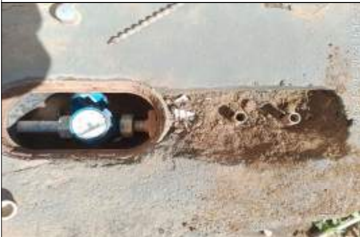
FOTO 01 – A empresa Hidro Ambiental efetuou uma interligação da espera localizada na calçada ao hidrômetro;
