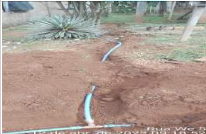
FOTO 03 - na inspeção foi realizado a ligação do ramal de água até a caixa de água da residência.
