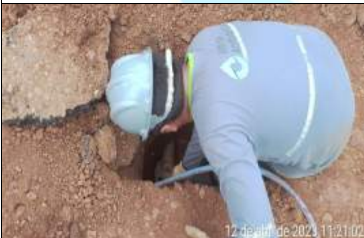
FOTO 03 - na inspeção foi realizado a ligação do ramal de água até a caixa de água da residência.
