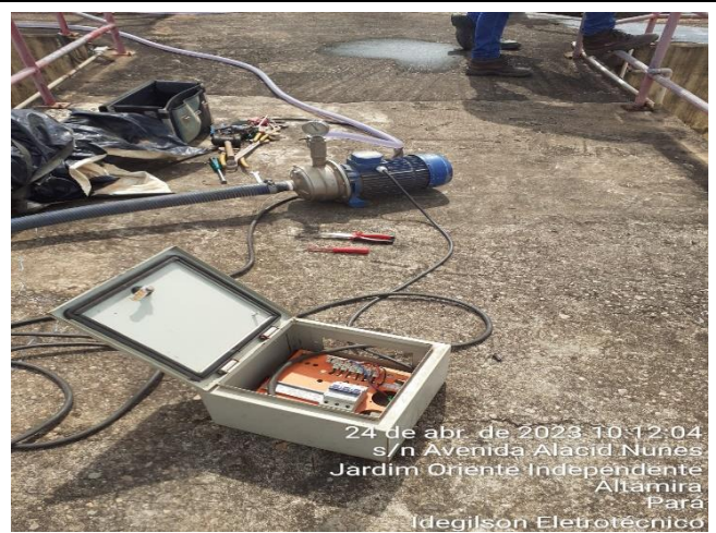
INSTALAÇÃO DA BOMBA PRA FAZER A LAVAGEM DOS DECANTADORES 01 E 02 DA ESTAÇÃO CONVENCIONAL
