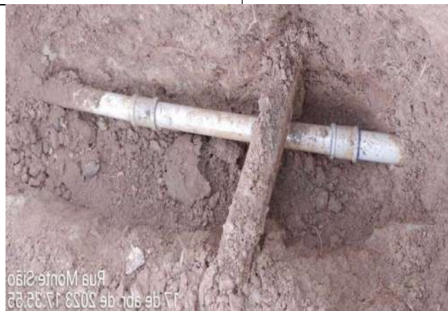
RUA HORÁCIO BOANERGES- BAIRRO BRASÍLIA
