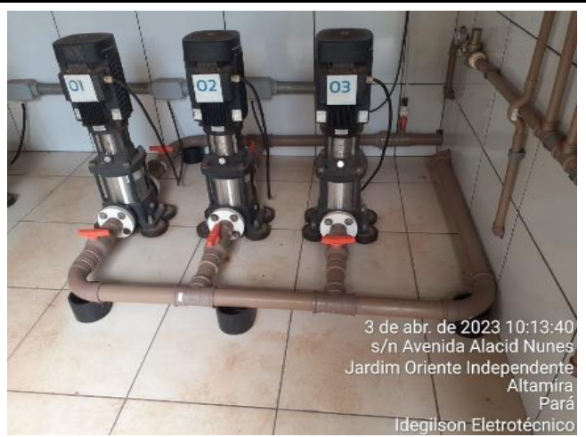
REVEZAMENTO EM BOMBAS DE PRESSURIZAÇÃO, DE BOMBA 01 PARA BOMBA 02
