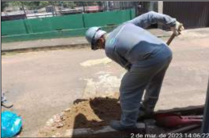
FOTO 01 – JUCA BORGES DE OLIVEIRA, 28, ALBERTO SOARES No monitoramento a nossa equipe identificou o vazamento de água no ramal de distribuição.
