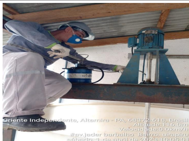
LUBRIFICAÇÃO DO ROLAMENTO DO MISTURADOR DE POLÍMERO
