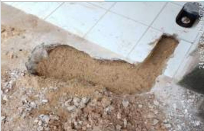
FOTO 03 – Para isso, utilizaram-se 0,2m 3 de areia e meio saco de cimento;
