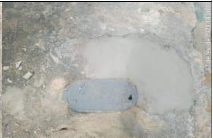
FOTO 02 – Durante a execução do serviço houve escavação, reaterro, compactação manual e mecanizada. Para isso, utilizou-se meio saco de cimento;
