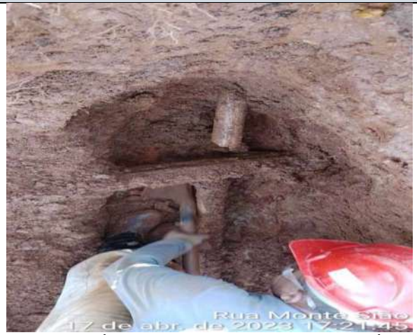
RUA HORÁCIO BOANERGES- BAIRRO BRASÍLIA
