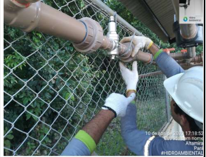
FOTO 2 - Instalação da Valvula de alivio de pressão.
