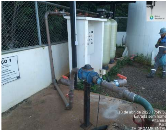
FOTO 1 - Inspensão na rede de sucção do poço.
