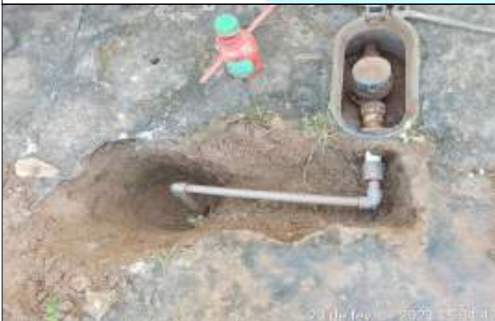
FOTO 03 – Salientamos que para realizar a conexão entre a espera e o hidrômetro também foi preciso utilizar dois joelhos, uma luva LR, e 0,5 metro de tubo, todos com 20mm de diâmetro. Demanda atendida.
