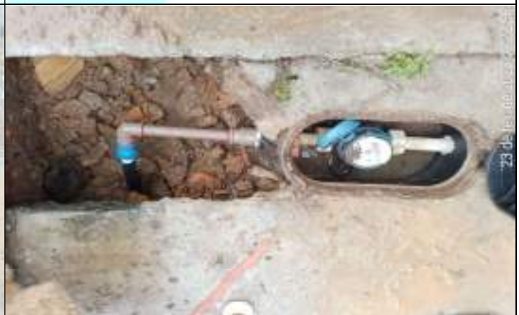
FOTO 04 – Salientamos que para realizar a conexão entre a espera e o hidrômetro, também foi preciso utilizar um joelho, duas luvas LR e 0,3 metro de tubo, todos com 20mm de diâmetro. Demanda atendida.
