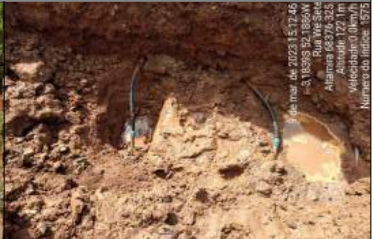
FOTO 02 – Foi realizado o reparo em RDA. O vazamento foi controlado e o fluxo voltou ao normal. Demanda atendida
