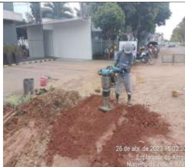
AV RIGADEIRO EDUARDO GOMES-BAIRRO CENTRO
