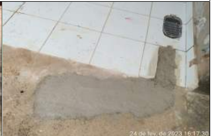
FOTO 02 – Durante a execução do serviço houve escavação, reaterro, compactação manual e mecanizada;
