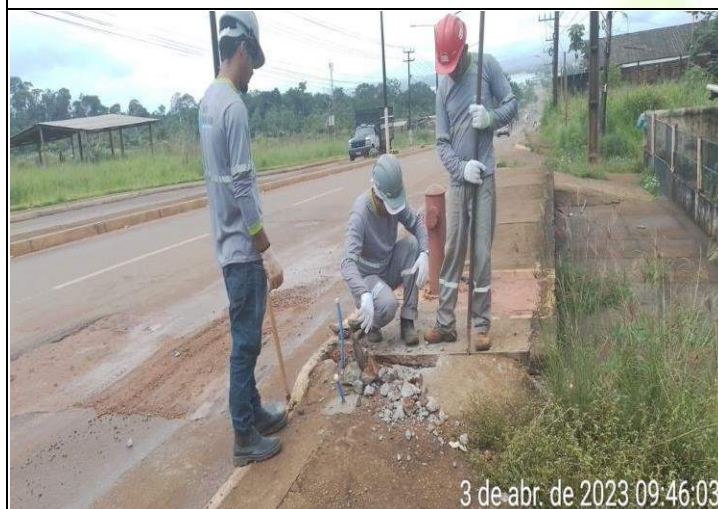
FOTO 01 - Rodovia Ernesto Acioli, Nº260, Bairro Colinas
