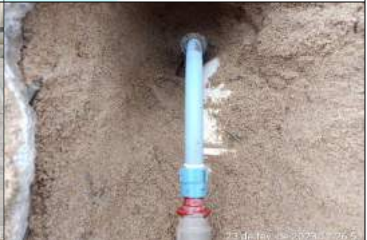
FOTO 04 – Salientamos que para realizar a conexão entre a espera e o hidrômetro também foi preciso utilizar duas luvas LR e 0,7 metro de tubo PEAD, ambos com 20mm de diâmetro. Demanda atendida.
