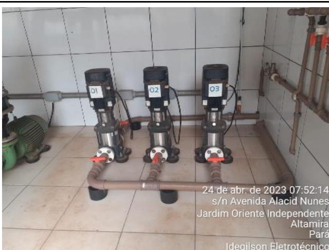
REVEZAMENTO EM BOMBAS DE PRESSURIZAÇÃO DA BOMBA 02 PARA BOMBA 03
