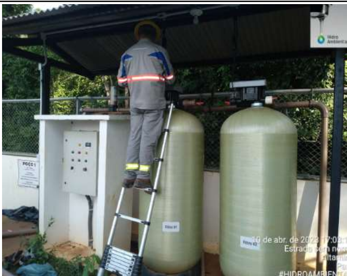
FOTO 3 - Instalação da engrenagens danificadas dos filtros.
