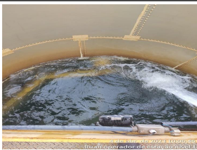
LAVAGEM EM FILTROS DA ESTAÇÃO MODULAR
