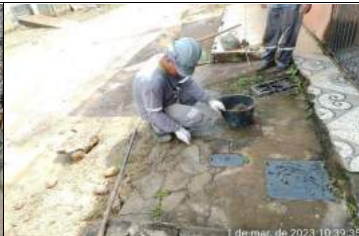
FOTO 02 – Foi feito os reparos e o tapeamento do mesmo com cimento. Após o trabalho concluído o vazamento foi consertado e o fluxo voltou ao normal. DEMANDA ATENDIDA
