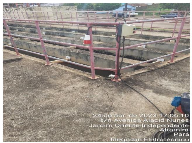
INSTALAÇÃO DE UM PONTO DE ENERGIA, PRA LIGAR BOMBA QUANDO FOR FAZER A LAVAGEM DOS DECANTADORES
