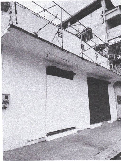
Item 01 – Entrada do Prédio – Rua Intendente Floriano
