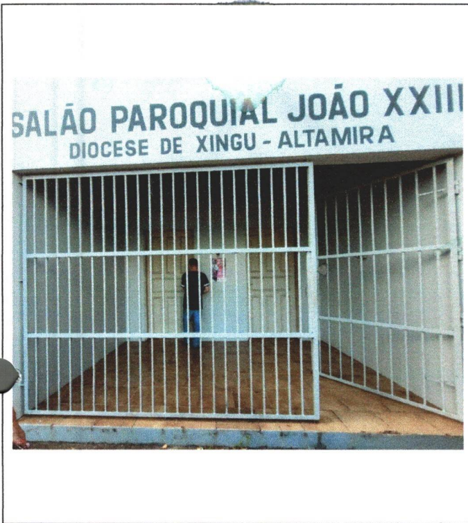
Item 01 – Área Externa - Entrada
