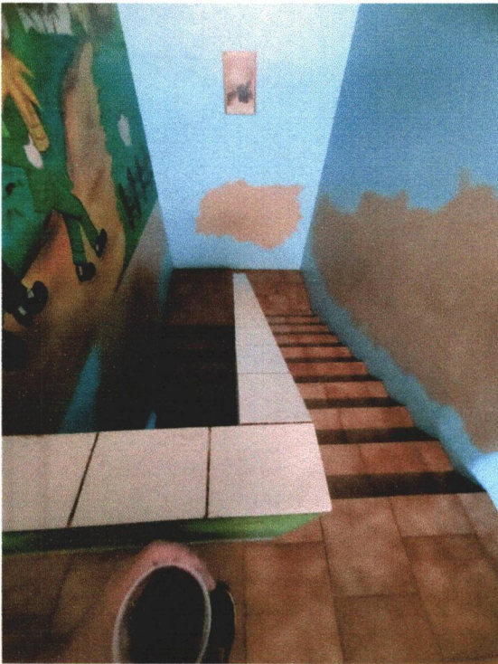
Item 07 – Circulação vertical (Escada)
