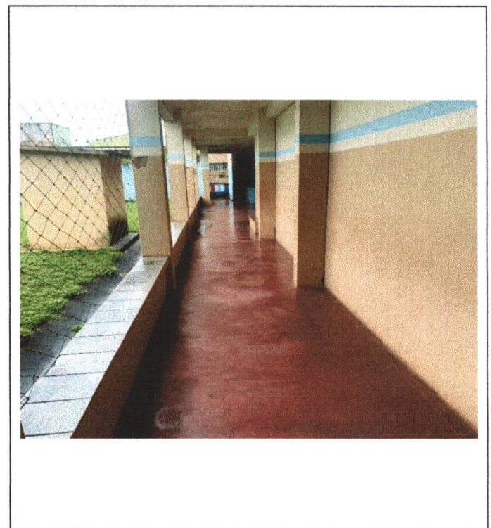
Item 04 – Corredor Interno
