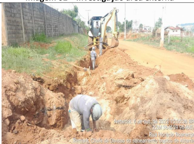
Imagem 04 – Investigação área externa
