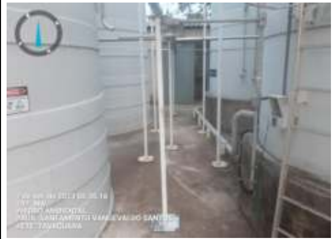
LIMPEZA DA ESTAÇÃO
