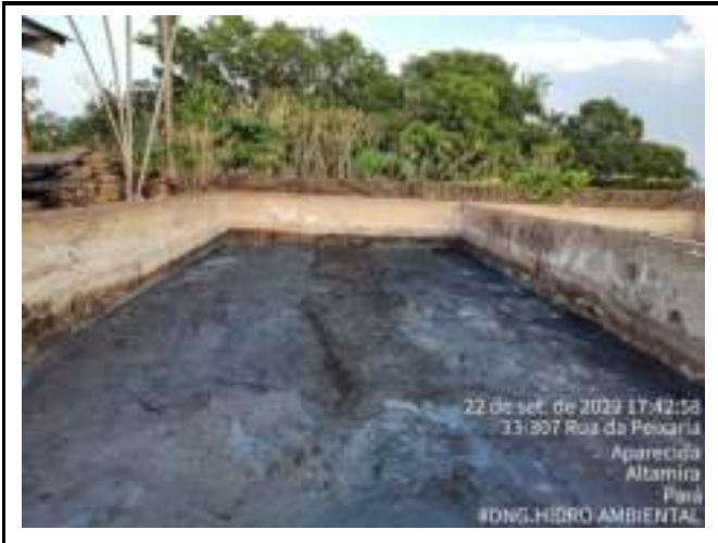
FINALIZADA A LIMPEZA DO LEITO DE SECAGEM, O LODO ENCAMINHADO PRO ATERRO SANITÁRIO
