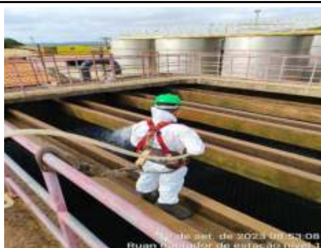
LAVAGEM DOS DECANTADORES – ETA CONVENCIONAL
