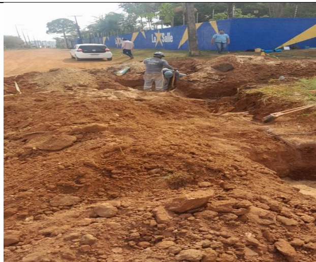
Imagem 02 – Investigação área externa
