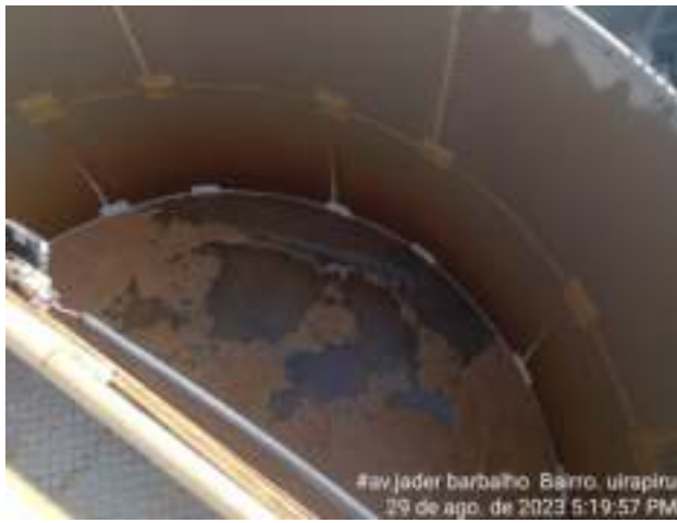
RETROLAVAGEM DOS FILTROS DA ETA MODULAR
