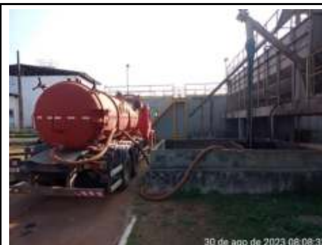
SUCÇÃO DA ÁGUA DA CAIXA DE AREIA DOS KOMBIS
