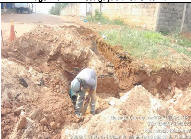
Imagem 03 – Investigação área externa
