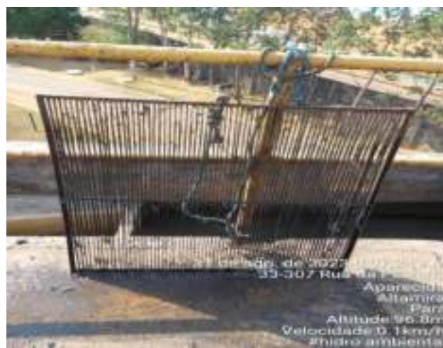
LIMPEZA DO GRADEAMENTO DA ENTRADA DO ESGOTO BRUTO
