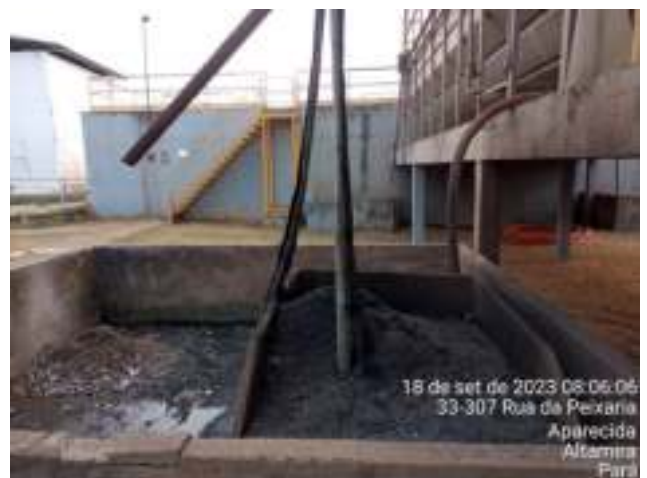
SUCÇÃO DA ÁGUA DAS CAIXAS DE AREIA DOS KOMBIS
