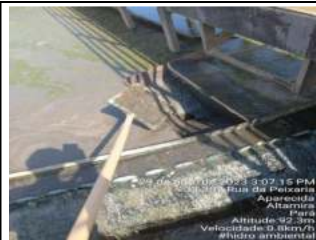
FOI TIRADO SOBRENADANTES (LODO) DOS SECUNDÁRIOS A E B
