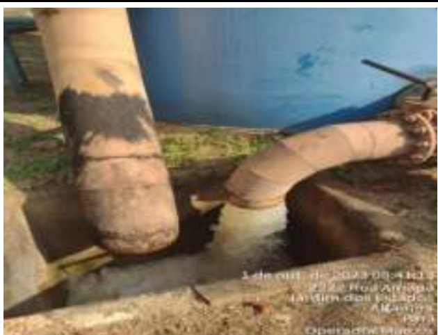
RETROLAVAGEM DOS FILTROS DE METAL DA ETA CONVENCIONAL
