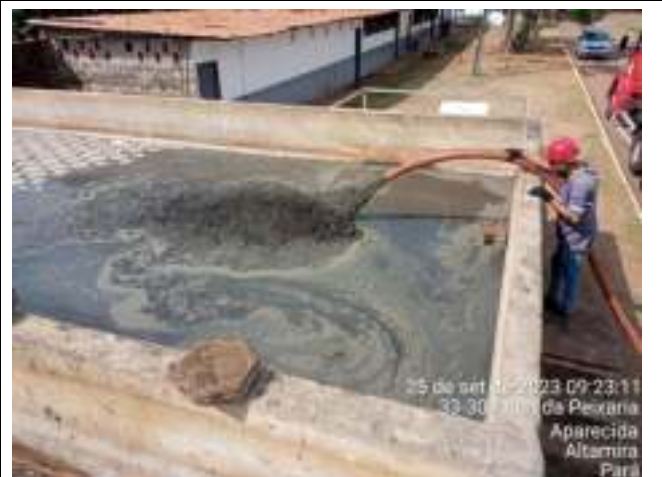
SUCÇÃO DA CAIXA DE ANTE ESPUMA
