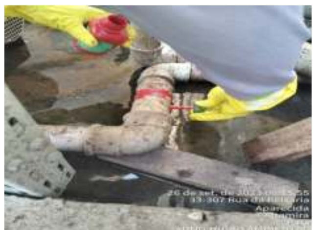
COLAGEM DO CANO DE ÁGUA DA CENTRÍFUGA QUE SE ROMPEU
