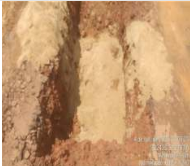
RUA CORONEL JOSÉ PORFÍRIO
