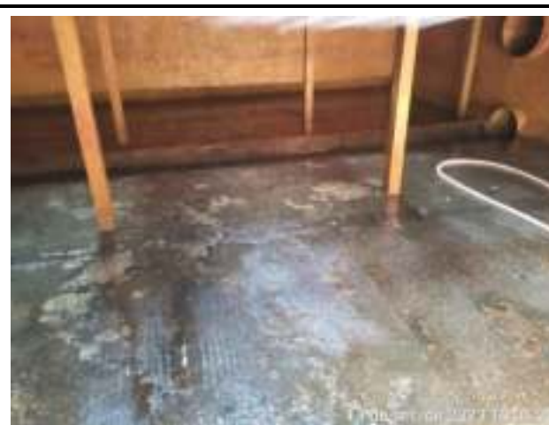
LAVAGEM DOS DECANTADORES DA ETA CONVENCIONAL – FUNDO POÇO
