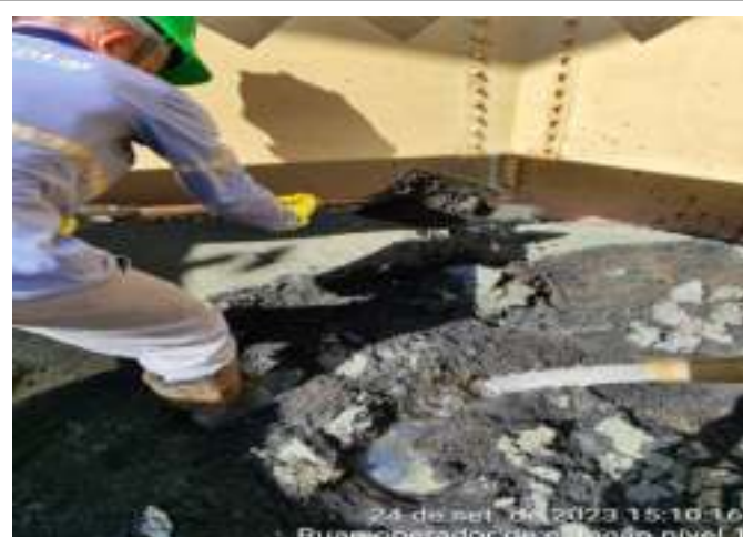
REALIZAÇÃO DE PROCESSO DE DESCOMPACTAÇÃO DE CARVÃO NOS FILTROS
