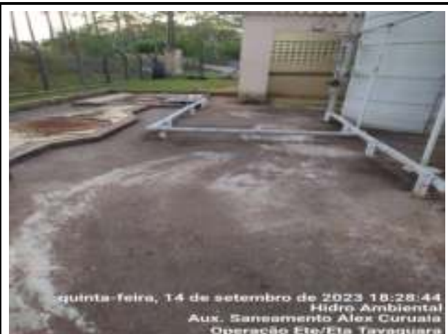
LIMPEZA DA ESTAÇÃO
