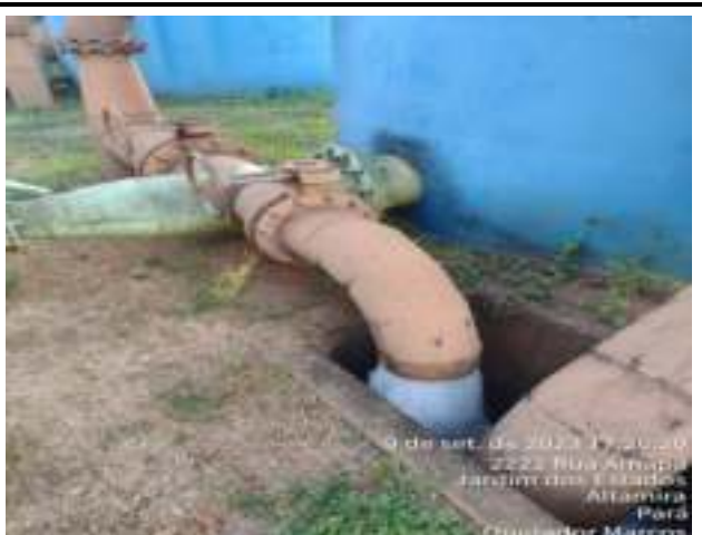
RETROLAVAGEM DOS FILTROS DE METAL - ETA CONVENCIONAL
