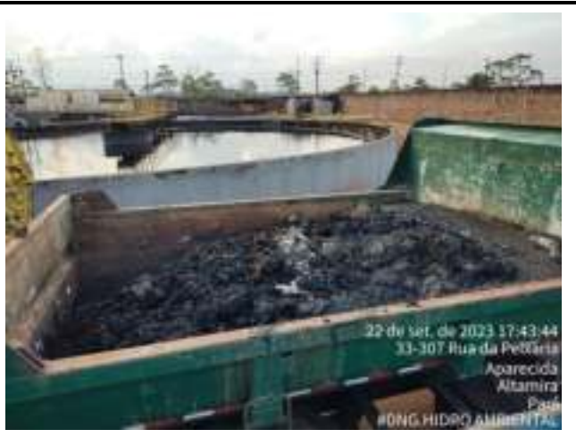
FINALIZADA A LIMPEZA DO LEITO DE SECAGEM, O LODO ENCAMINHADO PRO ATERRO SANITÁRIO
