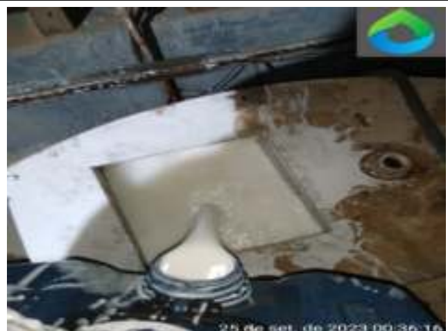
ADIÇÃO DE PASTILHA DE CLORO NO EMISSÁRIO FINAL E ADIÇÃO DE ANTE ESPUMA
