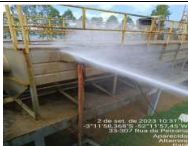
LIMPEZA DAS GRADES DO TANQUE DE AERAÇÃO DA LINHA A
