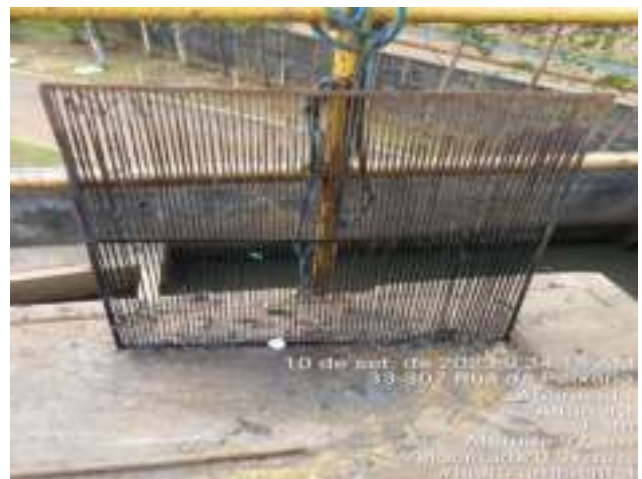
LIMPEZA DO GRADEAMENTO DA ENTRADA DO ESGOTO BRUTO.
