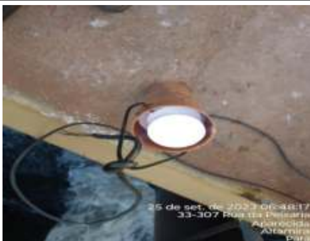
ADIÇÃO DE PASTILHA DE CLORO NO EMISSÁRIO FINAL E ADIÇÃO DE ANTE ESPUMA
