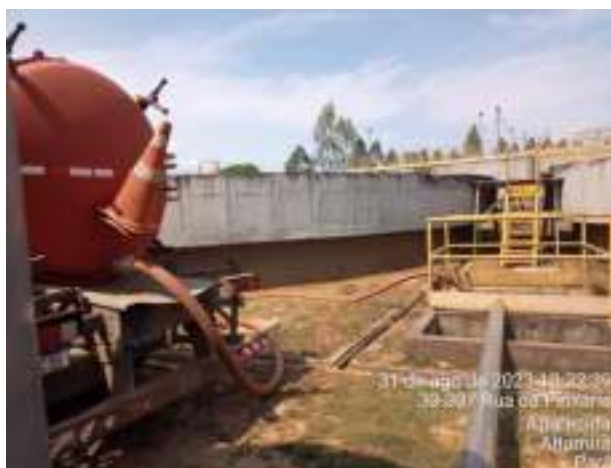
SUCÇÃO DA CAIXA DE ESPUMA
