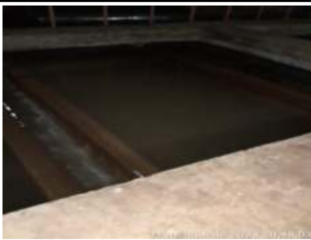
LAVAGEM DOS FILTROS DE CONCRETO – ETA CONVENCIONAL
