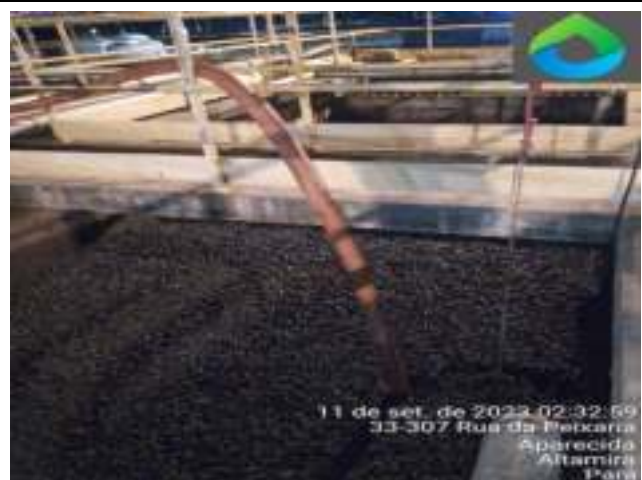
INSTALAÇÃO DA BOMBA NO TANQUE PRIMÁRIO PARA A SECAGEM DO MESMO PARA MANUTENÇÃO DO TUBO DE AIRAÇÃO
