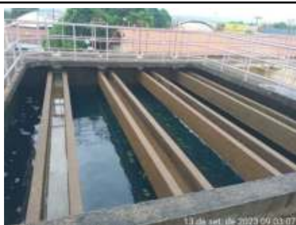
LAVAGEM DOS DECANTADORES DA ETA CONVENCIONAL - COLMÉIAS
