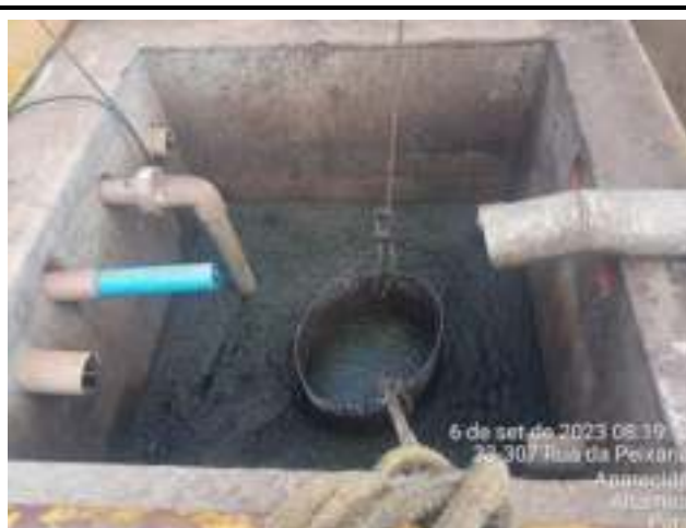
SUCÇÃO DA CAIXA DE ESPUMA
