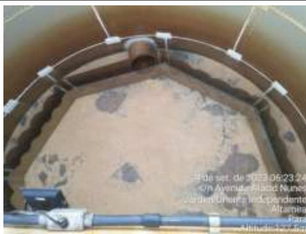
RETROLAVAGEM DOS FILTROS DA ETA MODULAR
