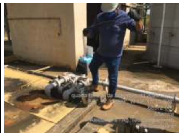
Foto 1: Ponto de coleta – entrada do efluente bruto
