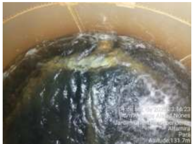
RETROLAVAGEM DOS FILTROS DA ETA MODULAR
