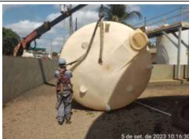
REPOSICIONAMENTO DO TANQUE DE HIPOCLORITO
