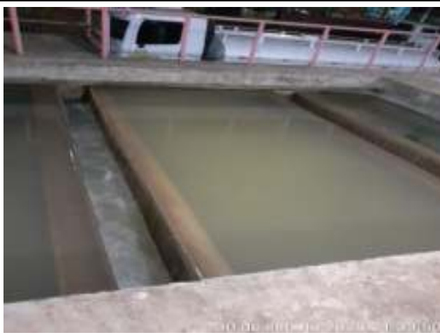
LAVAGEM DOS FILTROS DE CONCRETO ETA CONVENCIONAL
