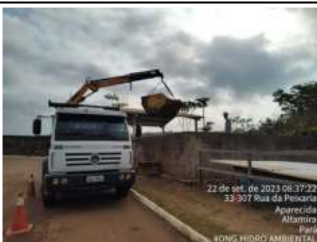
FOI DADO INICIO NA LIMPEZA DO LEITO DE SECAGEM
