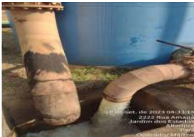
RETROLAVAGEM DOS FILTROS DE METAL - ETA CONVENCIONAL
