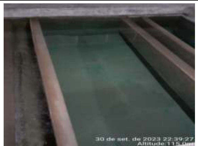
LAVAGEM DOS FILTROS DE CONCRETO ETA CONVENCIONAL
