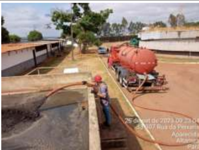
SUCÇÃO DA CAIXA DE ANTE ESPUMA
