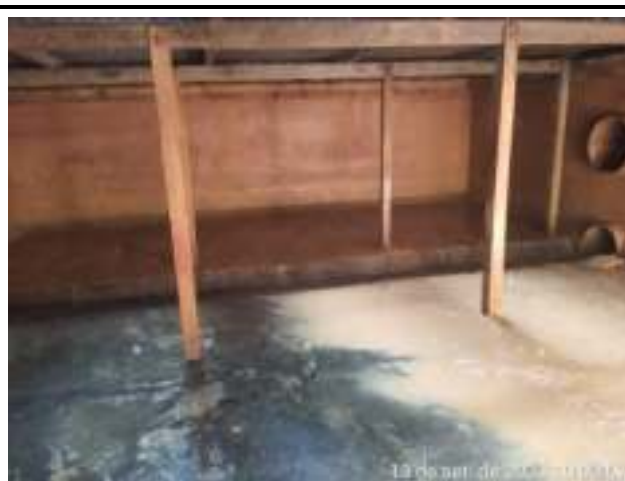
LAVAGEM DOS DECANTADORES DA ETA CONVENCIONAL – FUNDO POÇO
