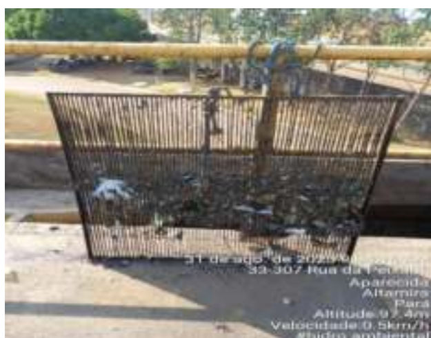
LIMPEZA DO GRADEAMENTO DA ENTRADA DO ESGOTO BRUTO
