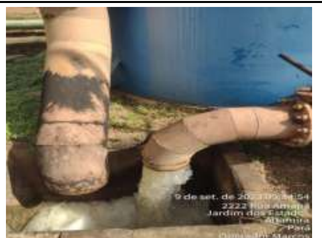
RETROLAVAGEM DOS FILTROS DE METAL - ETA CONVENCIONAL
