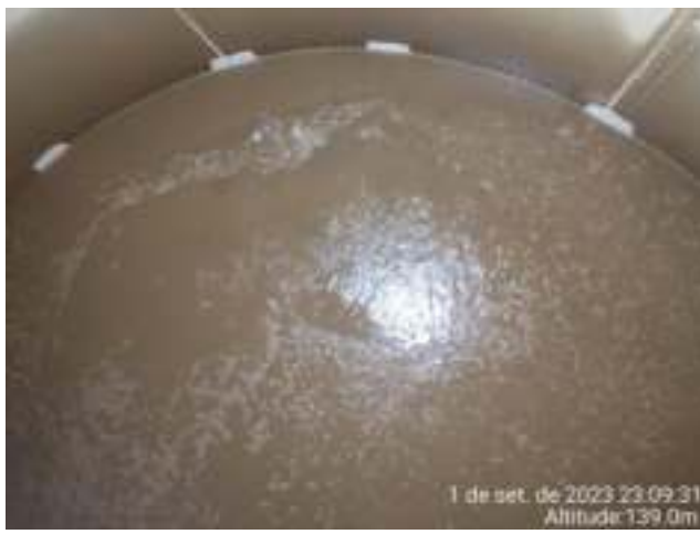
RETROLAVAGEM DOS FILTROS DA ETA MODULAR
