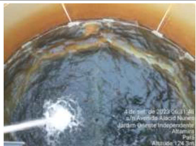
RETROLAVAGEM DOS FILTROS DA ETA MODULAR
