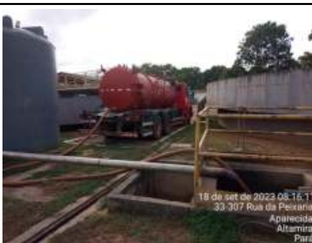
LIMPEZA DA CAIXA DE ESPUMA DOS DECANTADORES
