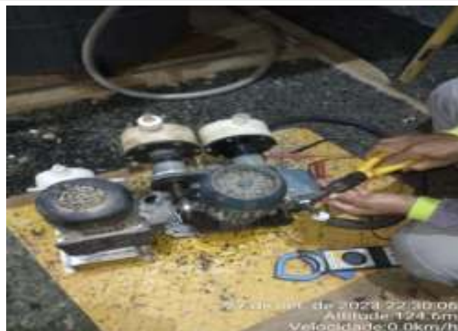
SUBSTITUIÇÃO DE BOMBA DOSADORA DE BARRILHA
