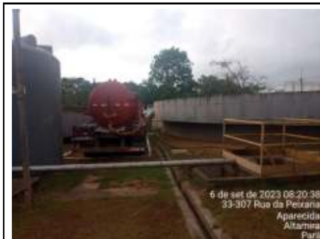
SUCÇÃO DA CAIXA DE ESPUMA
