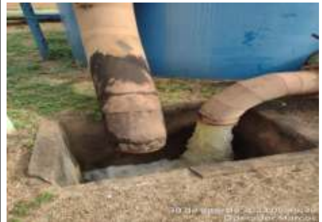
DESCARGA DOS FILTROS DE METAL ETA CONVENCIONAL
