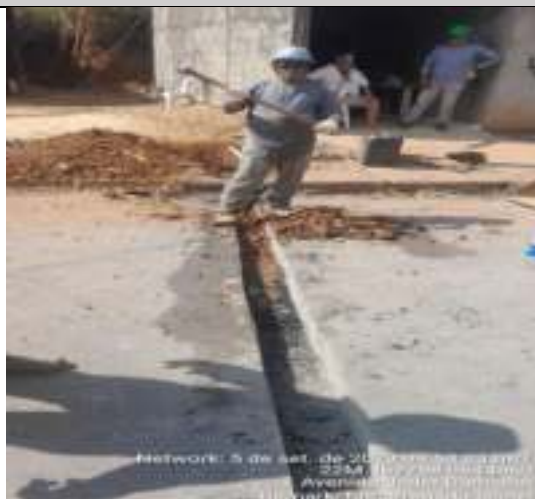
AVENIDA PERIMETRAL, 4444- INDEPENDENTE I
