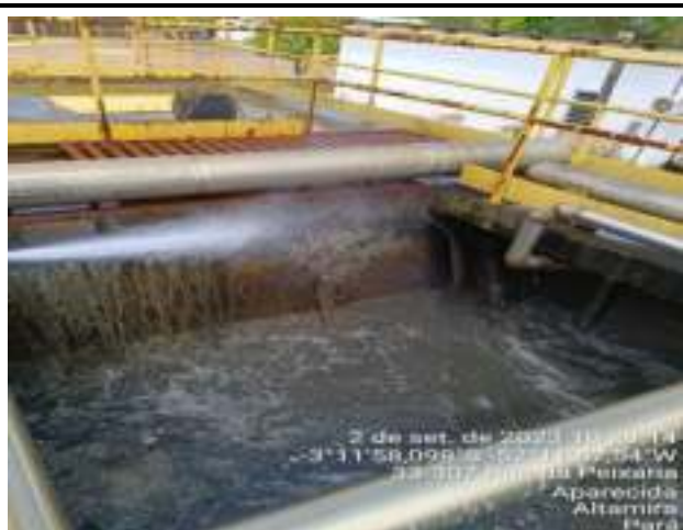
LIMPEZA DAS GRADES DO TANQUE DE AERAÇÃO DA LINHA A
