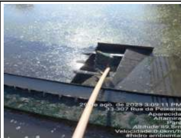
FOI TIRADO SOBRENADANTES (LODO) DOS SECUNDÁRIOS A E B
