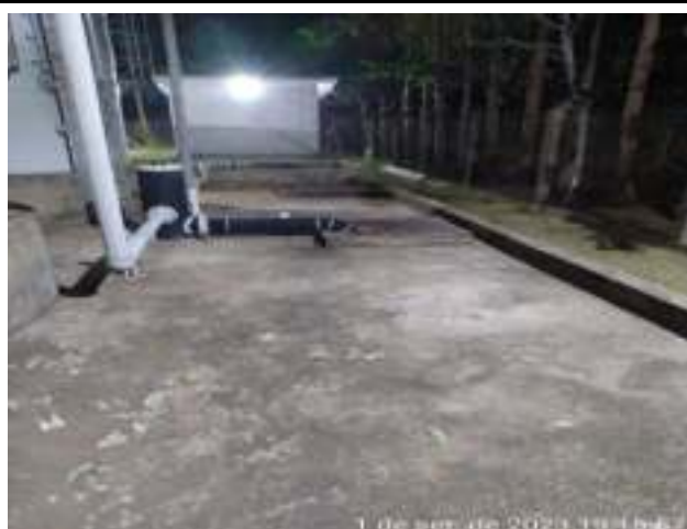
LIMPEZA DA ESTAÇÃO
