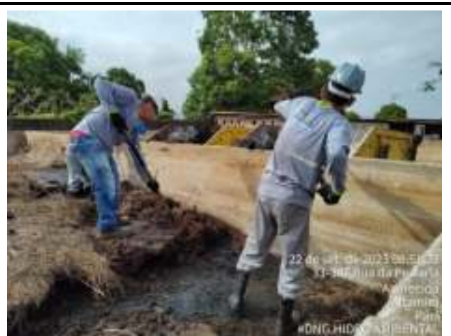
FOI DADO INICIO NA LIMPEZA DO LEITO DE SECAGEM
