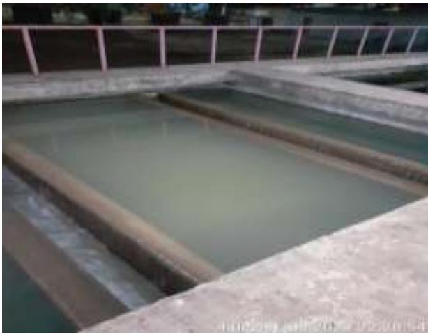
LAVAGEM DOS FILTROS DE CONCRETO – ETA CONVENCIONAL
