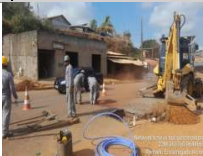
AVENIDA PERIMETRAL, 4444- INDEPENDENTE I
