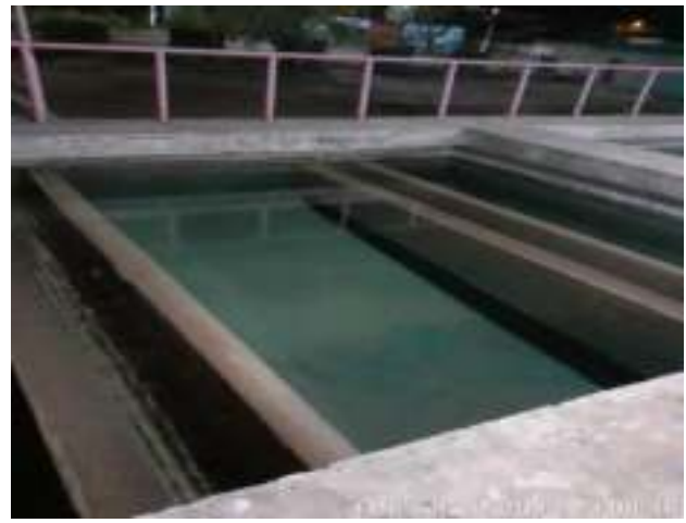
LAVAGEM DOS FILTROS DE CONCRETO – ETA CONVENCIONAL
