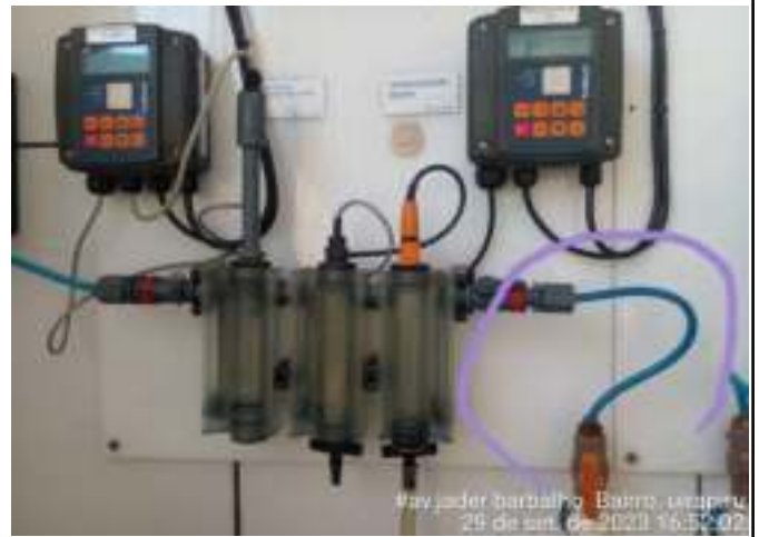
SUBSTITUIÇÃO DE MANGUEIRA DO SISTEMA DE ANÁLISE DE pH e CLORO DE ÁGUA COAGULADA
