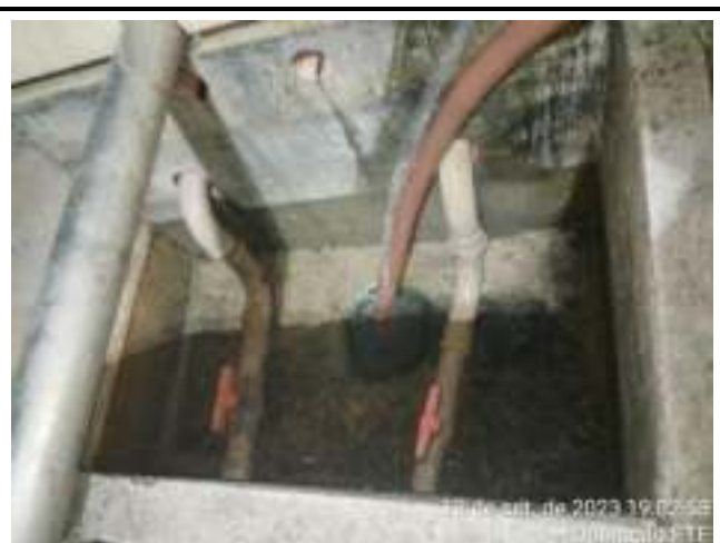
LIMPEZA DA CAIXA DE ESPUMA DOS DECANTADORES
