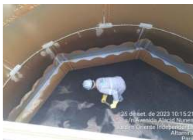
REALIZAÇÃO DE PROCESSO DE DESCOMPACTAÇÃO DE CARVÃO NOS FILTROS
