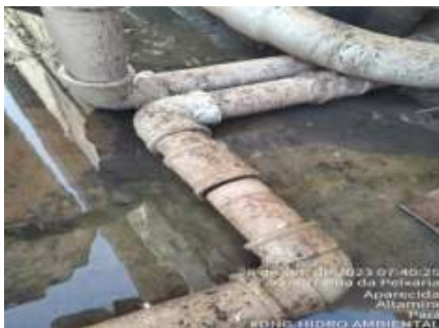
COLAGEM DO CANO DE ÁGUA DA CENTRÍFUGA QUE SE ROMPEU
