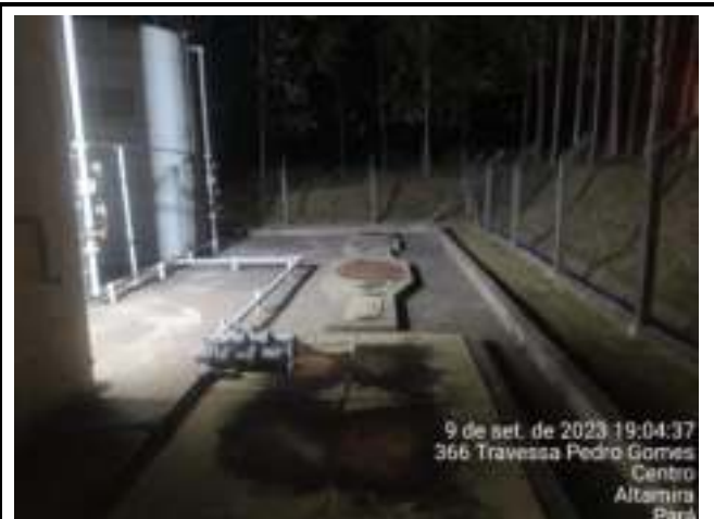
LIMPEZA DA ESTAÇÃO
