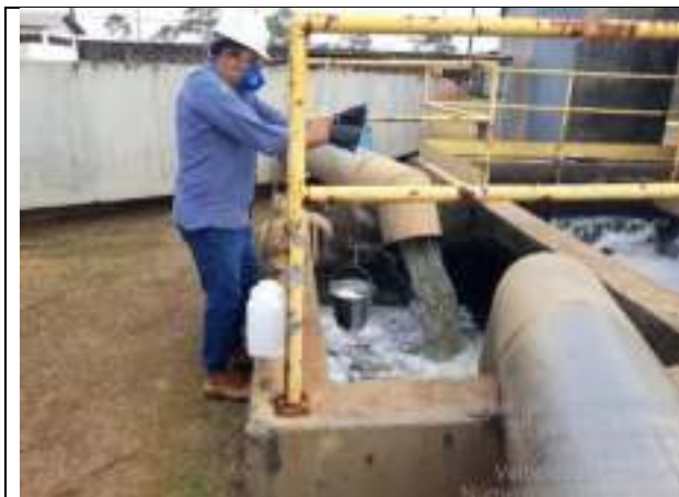
Foto 5: Ponto de coleta – saída do efluente tratado
