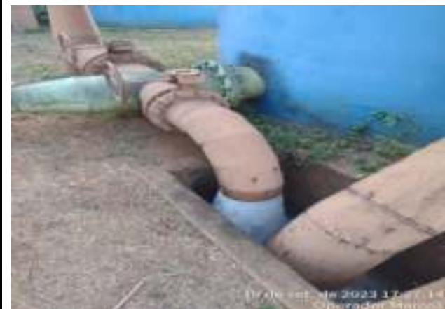
RETROLAVAGEM DOS FILTROS DE METAL - ETA CONVENCIONAL
