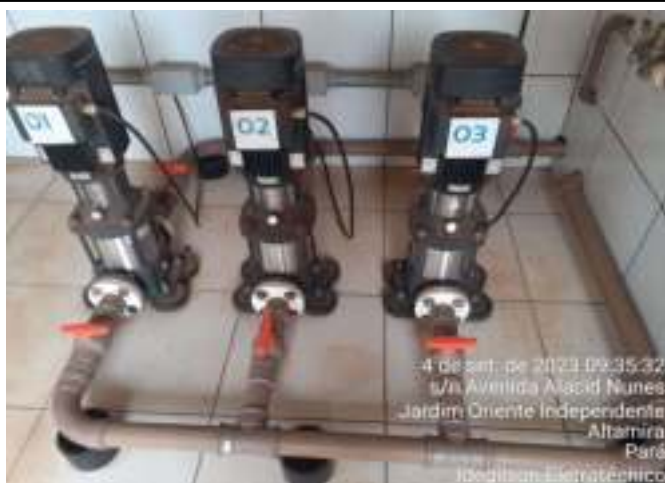
REVEZAMENTO EM BOMBAS DE PRESSURIZAÇÃO
