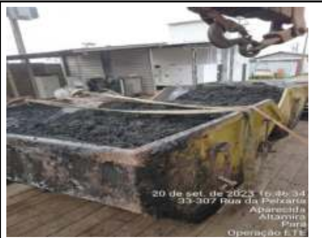
FORAM CENTRIFUGADOS 16 METROS CÚBICOS DE LODO RETIRADO DO TANQUE DECANTADOR SECUNDÁRIO
