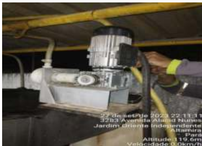
SUBSTITUIÇÃO DE BOMBA DOSADORA DE BARRILHA
