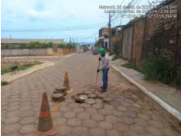
RUA ACESSO 01, 3971- BAIRRO SUDAN 02
