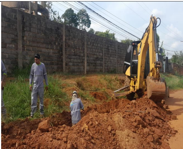
Imagem 01 – Investigação área externa
