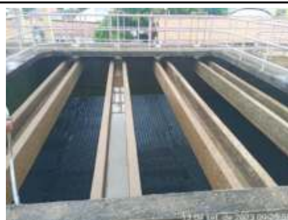
LAVAGEM DOS DECANTADORES DA ETA CONVENCIONAL - COLMÉIAS
