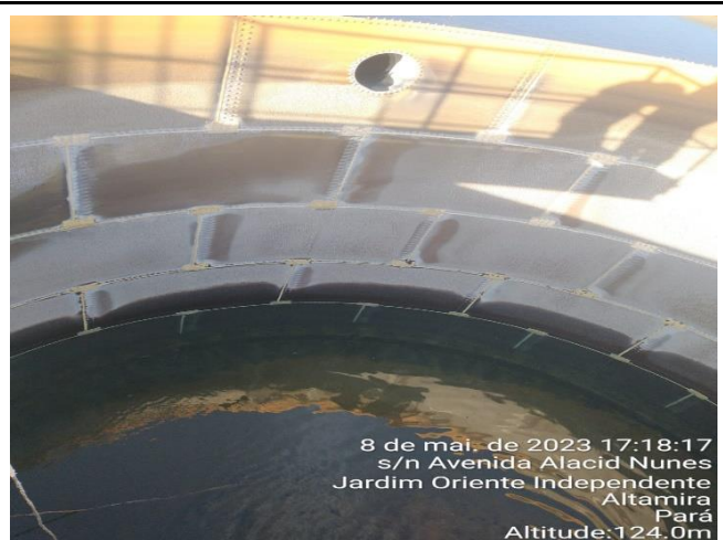
SECAGEM DO DECANTADOR PARA FAZER A LIMPEZA
