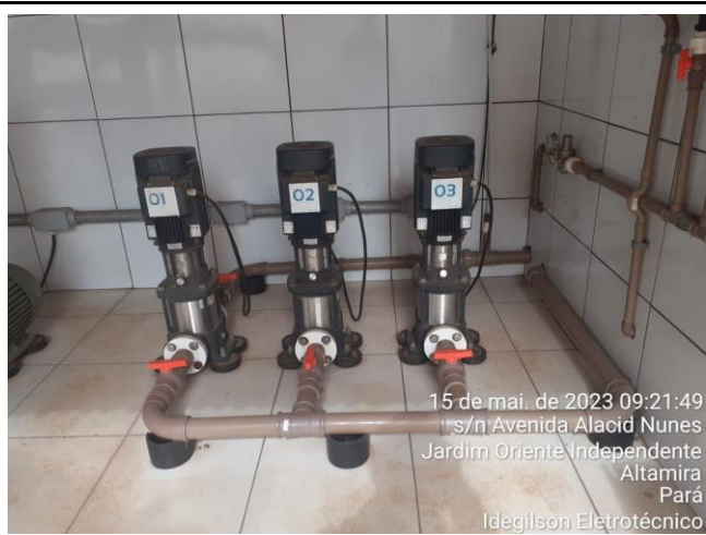
REVEZAMENTO EM BOMBAS DE PRESSURIZAÇÃO, DA BOMBA 01 PARA BOMBA 02
