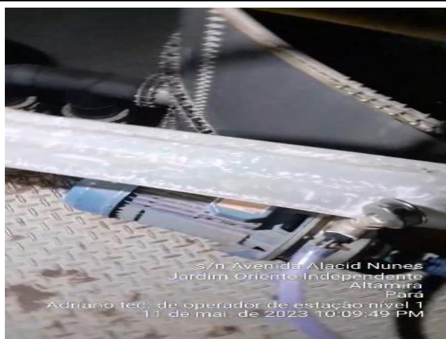
BOMBA DE FAZER A LIMPEZA DOS FILTROS
