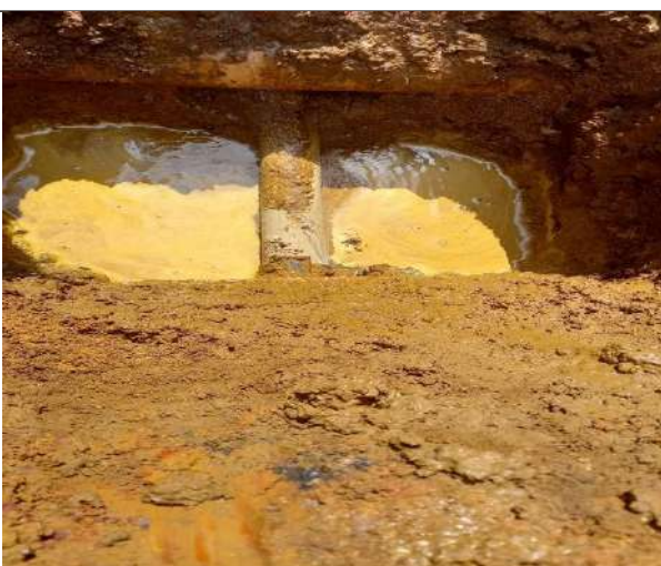
RUA ACESSO 04, 1086- BAIRRO IBIZA
