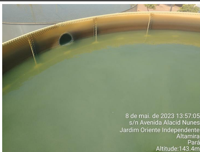
SECAGEM DO DECANTADOR PARA FAZER A LIMPEZA
