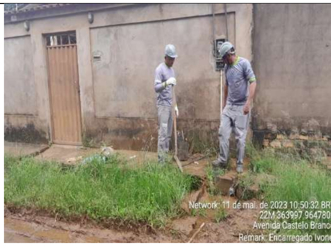
RUA 21 DE ABRIL- BAIRRO SANTA ANA
