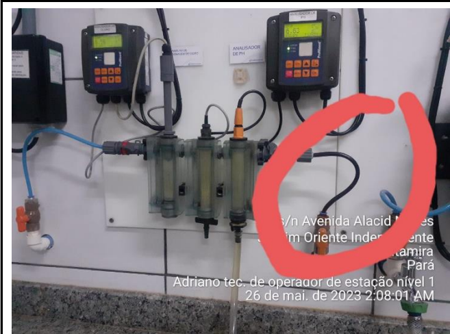
FOI FEITO A TROCA DA MANGUEIRA DOS ANALISADORES DE PH E CLORO
