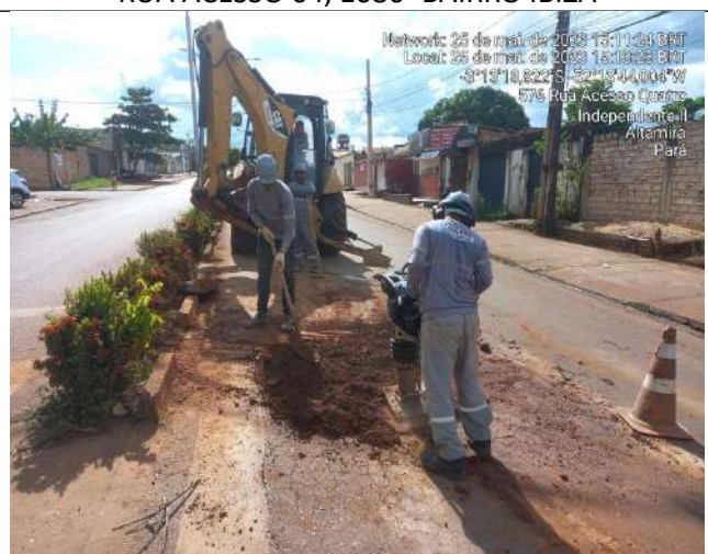
RUA ACESSO 04, 1086- BAIRRO IBIZA
