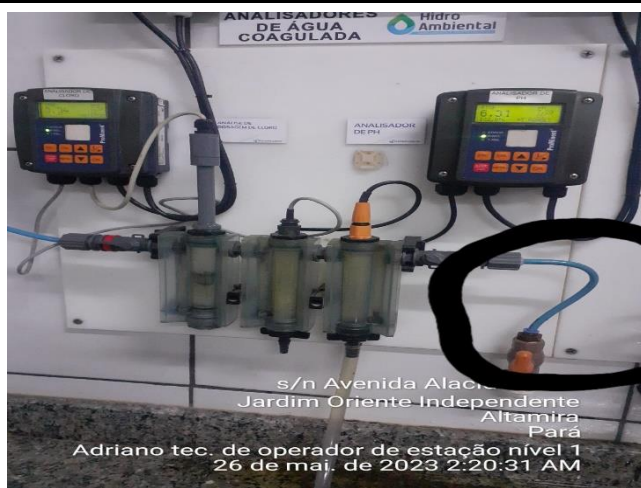
FOI FEITO A TROCA DA MANGUEIRA DOS ANALISADORES DE PH E CLORO
