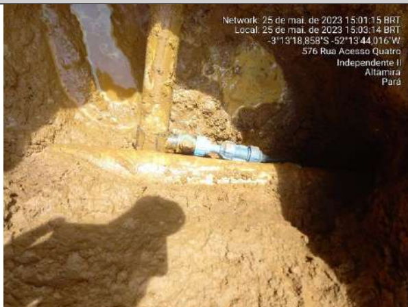
RUA ACESSO 04, 1086- BAIRRO IBIZA
