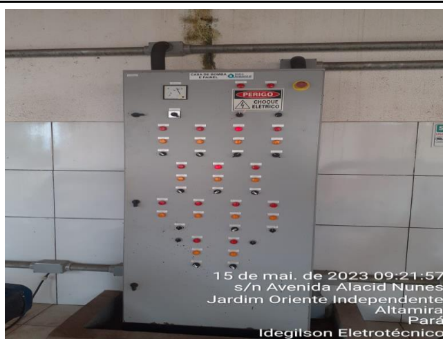
REVEZAMENTO EM BOMBAS DE PRESSURIZAÇÃO, DA BOMBA 01 PARA BOMBA 02
