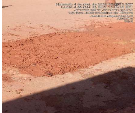
RUA ACESSO 03- INDEPENDENTE II
