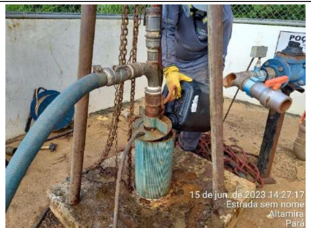
Foto 04: Adição de produto – cloro 40 lts
