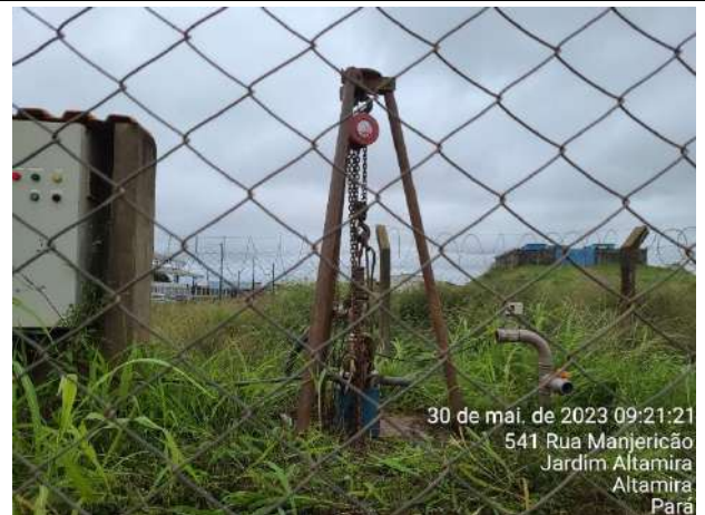
Foto 04: Montagem do equipamento
