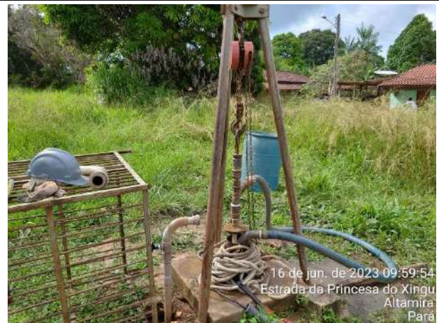
Foto 04: Montagem do equipamento
