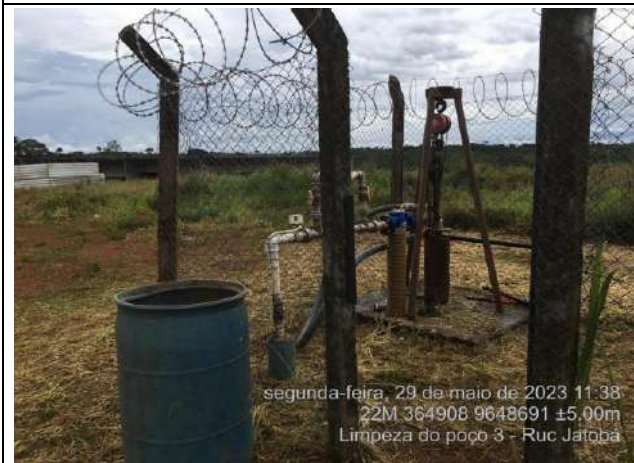
Foto 05: Montagem do equipamento
