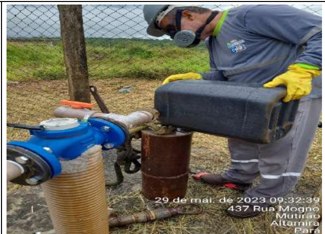
Foto 04: Adição de produto - cloro
