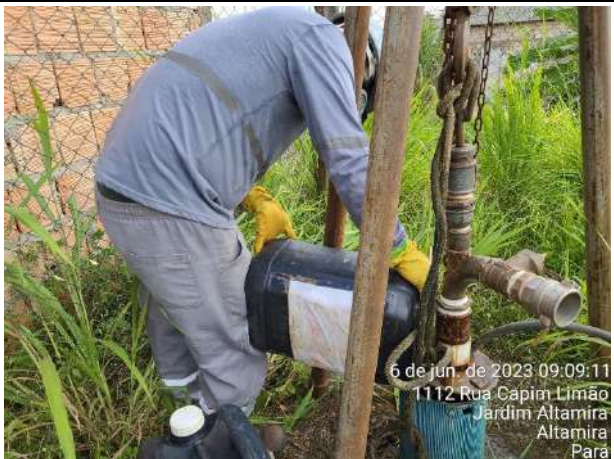
Foto 05: Adição de produto – cloro 40 lts
