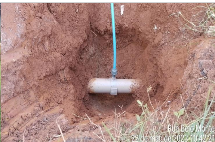
FOTO 02 – no monitoramento a nossa equipe realizou uma nova ligação de água na casa do morador. DEMANDA ATENDIDA
