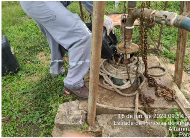
Foto 05: Adição de produto - cloro
