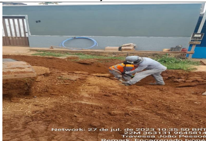
TRAVESSA RECIFE, 21- BAIRRO VISTA ALEGRE DIA 27.07.2023- CONSERTO DE VAZAMENTO NA REDE
