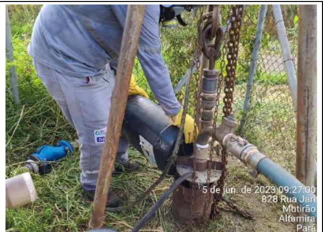
Foto 04: Adição de produto – cloro - 40lts
