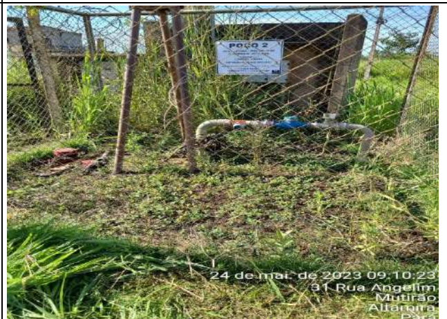
Foto 08: Conclusão do serviço
