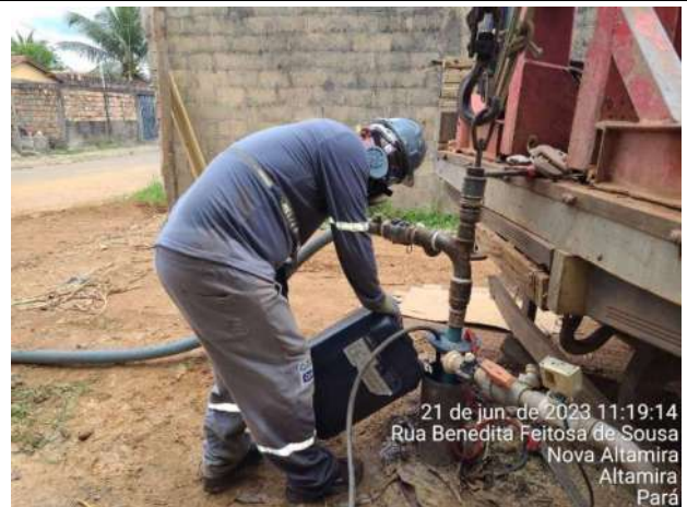
Foto 04: Adição do produto – 40 lts de cloro
