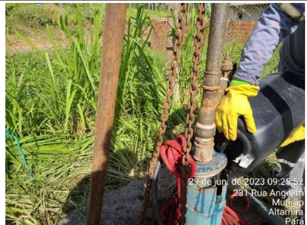
Foto 04: Adição de produto – cloro 40 lts
