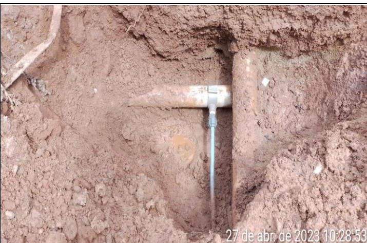
FOTO 02 – no monitoramento a nossa equipe identificou que o adaptador do colar estava danificado ocasionando o vazamento. Foi realizado a troca do mesmo é o fluxo voltou ao normal. DEMANDA ATENDIDA
