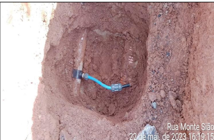
FOTO 02 – no monitoramento nossa equipe constatou que o vazamento ocorria devido o colar está estragado e a mangueira curta, foi realizado a troca dos mesmo para que o fluxo voltasse ao normal. DEMANDA ATENDIDA
