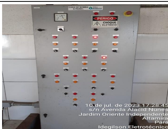
REVEZAMENTO EM BOMBAS DE PRESSURIZAÇÃO (MANOBRA REALIZADA DA BOMBA 02 PARA A BOMBA 03)
