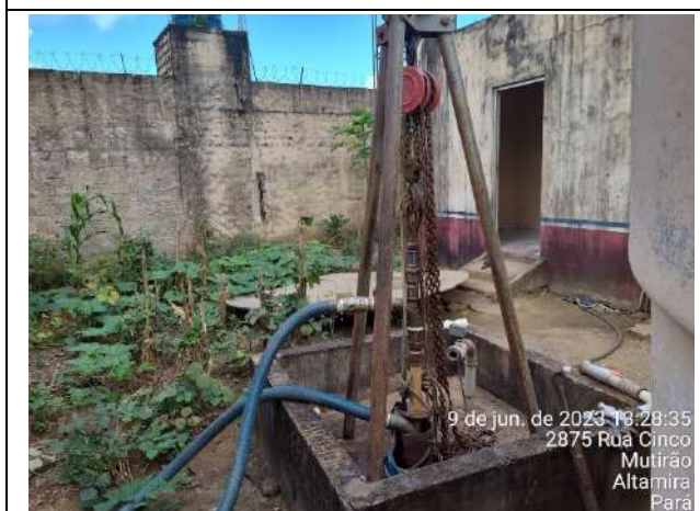
Foto 05: Montagem do equipamento
