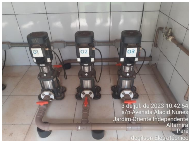
REVEZAMENTO EM BOMBAS DE PRESSURIZAÇÃO (MANOBRA REALIZADA DA BOMBA 01 PARA A BOMBA 02)
