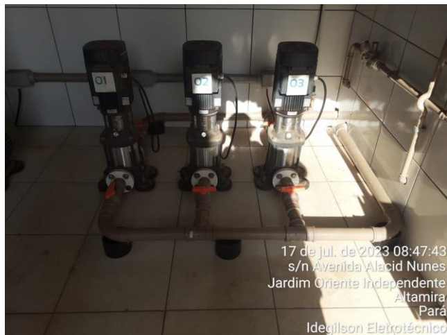
REVEZAMENTO EM BOMBAS DE PRESSURIZAÇÃO (MANOBRA REALIZADA DA BOMBA 03 PARA A BOMBA 01)
