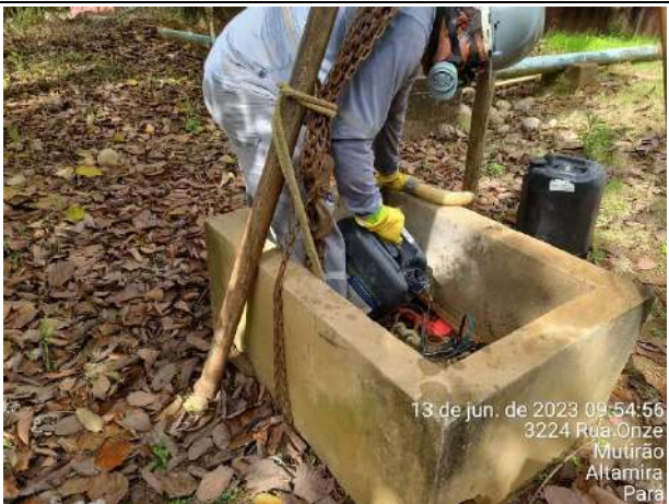
Foto 05: Adição de produto – cloro 40 lts
