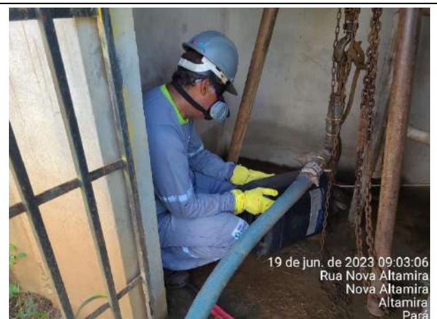
Foto 04: Adição de produto – cloro 40 lts
