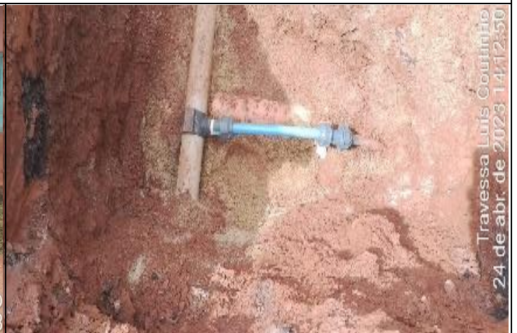
FOTO 02 – no monitoramento a nossa equipe identificou que a Mangueira Pead estava muito curta, foi realizado a troca do mesmo é o fluxo voltou ao normal. DEMANDA ATENDIDA
