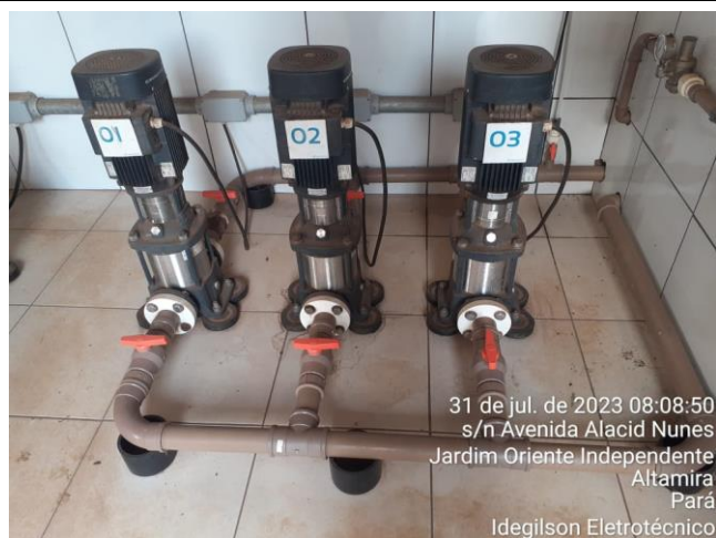
REVEZAMENTO EM BOMBAS DE PRESSURIZAÇÃO (MANOBRA REALIZADA DA BOMBA 02 PARA A BOMBA 03)
