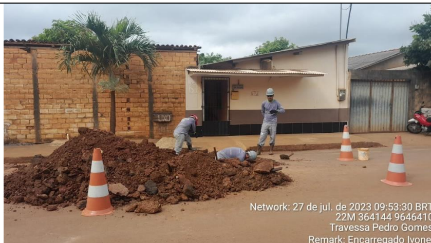
RUA JOÃO PINHO, 675- BAIRRO PANORAMA
