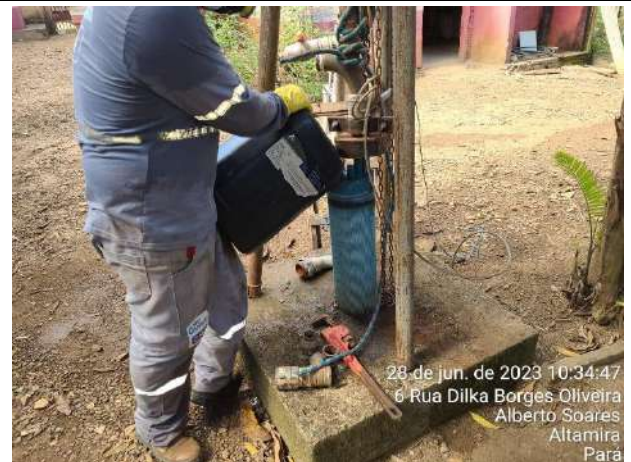
Foto 04: Adição do produto – 40 lts de cloro
