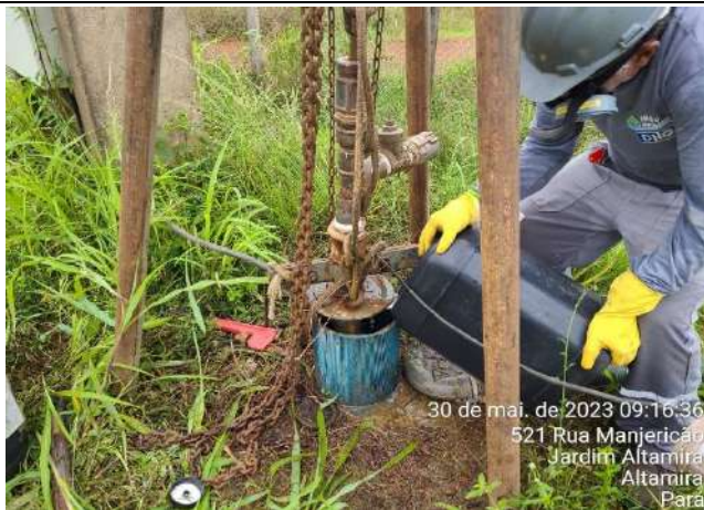
Foto 05: Adição de produto - cloro
