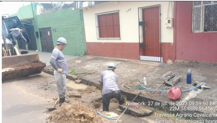
TRAVESSA AGRÁRIO CAVAALCANTE, 926- CENTRO DIA 27.07.2023- LIGAÇÃO DE ÁGUA E ESGOTO
