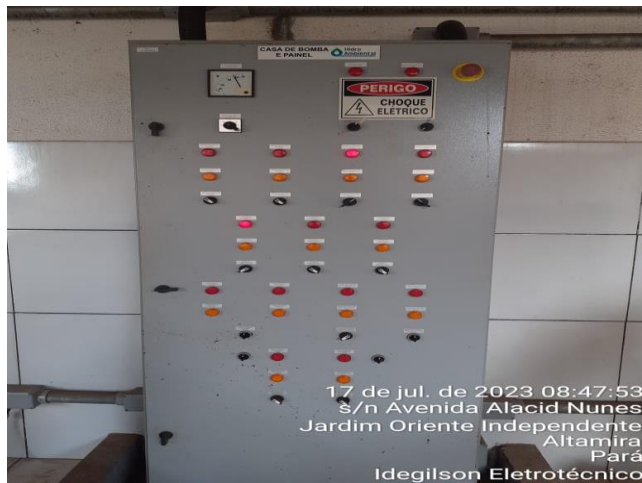
REVEZAMENTO EM BOMBAS DE PRESSURIZAÇÃO (MANOBRA REALIZADA DA BOMBA 03 PARA A BOMBA 01)
