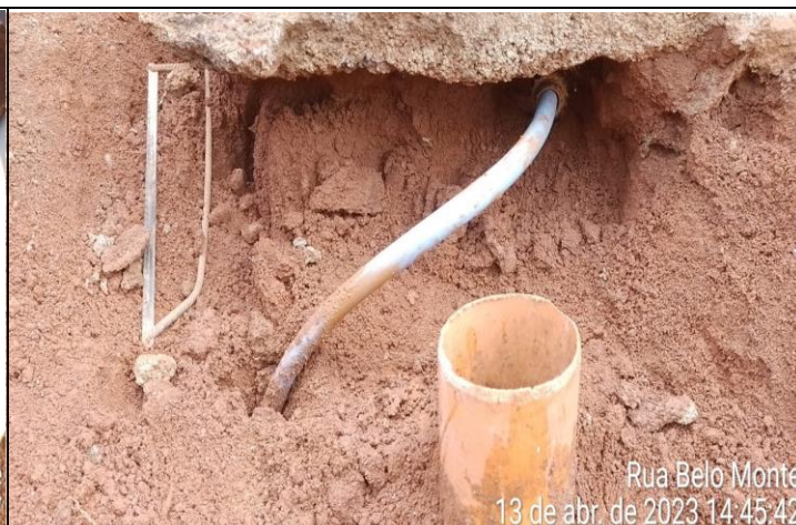
FOTO 02 – na inspeção foi identificado vazamento na rede de distribuição, foi feito o reparo retirando o vazamento. Demanda atendida.
