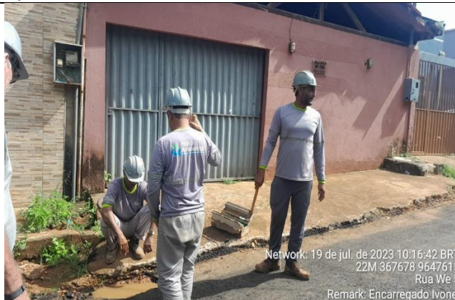
RUA WE 05, 1665- BAIRRO COLINAS
