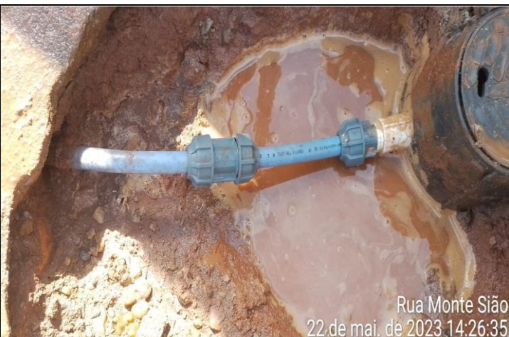
FOTO 02 – no monitoramento nossa equipe constatou que o vazamento ocorria devido o colar e o adaptador estarem estragado, foi realizado a troca dos mesmo para que o fluxo voltasse ao normal. DEMANDA ATENDIDA
