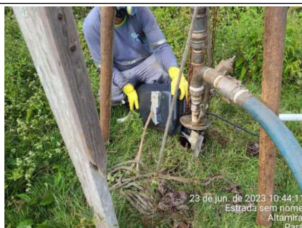
Foto 04: Adição de produto – cloro 40 lts
