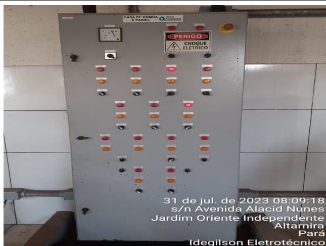
REVEZAMENTO EM BOMBAS DE PRESSURIZAÇÃO (MANOBRA REALIZADA DA BOMBA 02 PARA A BOMBA 03)
