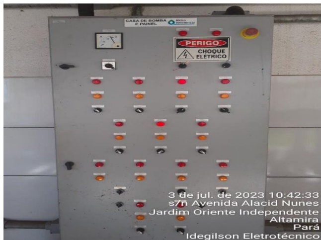
REVEZAMENTO EM BOMBAS DE PRESSURIZAÇÃO (MANOBRA REALIZADA DA BOMBA 01 PARA A BOMBA 02)
