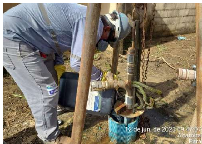
Foto 05: Adição de produto – cloro 40 lts
