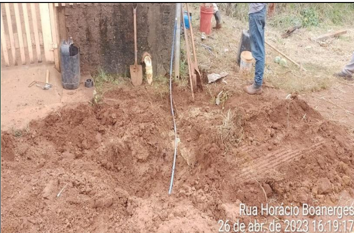
FOTO 02 – no monitoramento a nossa equipe realizou o conserto de vazamento de água que ocorria na frente da casa do morador. Após os reparos o fluxo voltou ao normal. Demanda atendida
