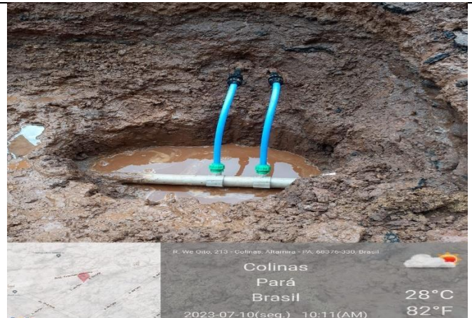
RUA WE 08, 206- BAIRRO COLINAS
