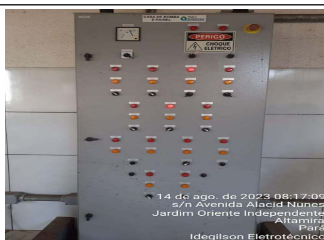
REVEZAMENTO EM BOMBAS DE PRESSURIZAÇÃO
