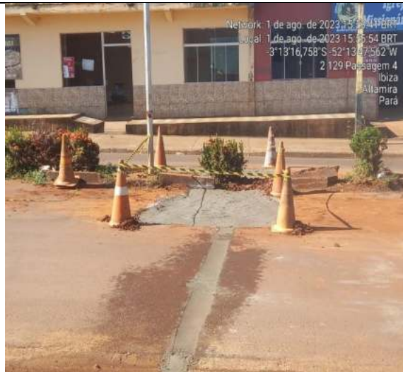
Rua acesso 03, 1243 - bairro Ibiza
