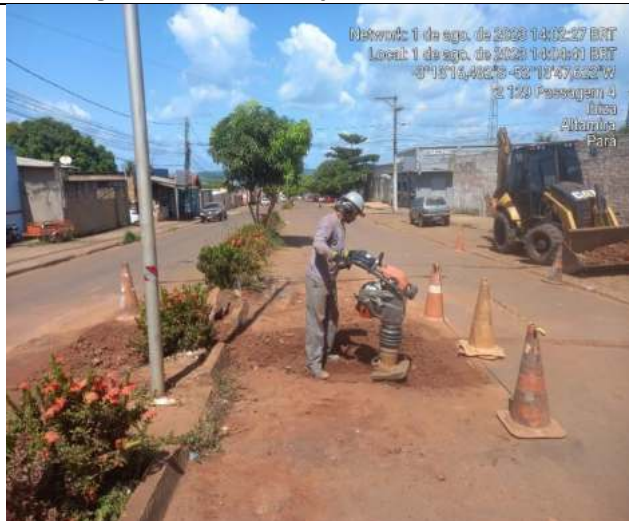
Rua acesso 03, 1243 - bairro Ibiza
