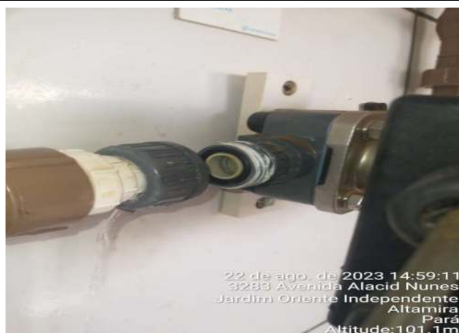
SUBSTITUIÇÃO DAS BORRACHAS DE VEDAÇÃO DAS LUVAS DE UNIÃO DA REDE DE DOSAGEM DE CLORO DA ÁGUA TRATADA
