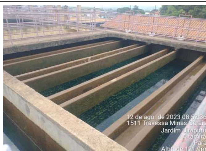
SECAGEM DOS DECANTADORES DA ETA CONVENCIONAL
