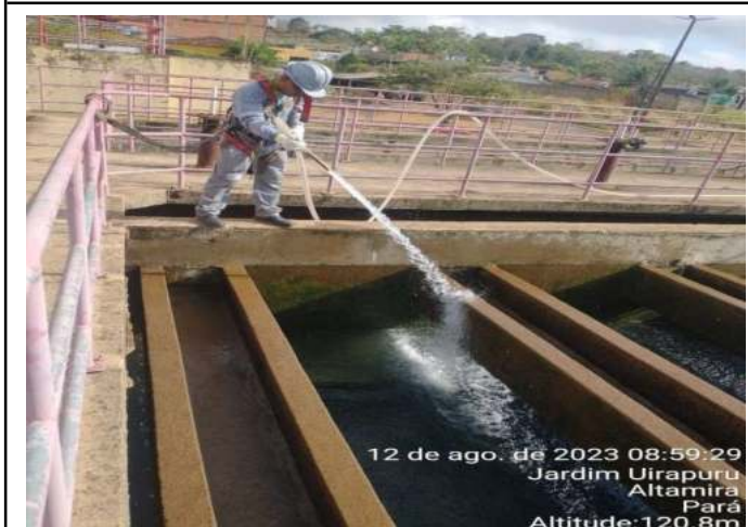
LAVAGEM DOS DECANTADORES DA ETA CONVENCIONAL
