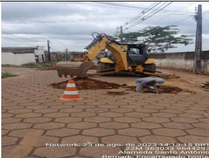
RUA MANOEL AMORIM, S/N- BAIRRO LIBERDADE 01
