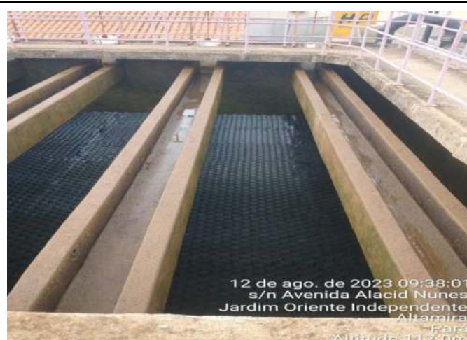
LAVAGEM DOS DECANTADORES DA ETA CONVENCIONAL
