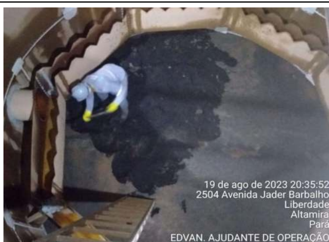
PROCESSO DE DESCOMPACTAÇÃO DE CARVÃO NO FILTRO 05
