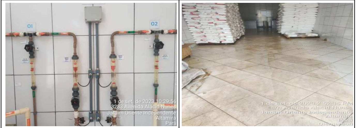
LIMPEZA DOS MANÔMETROS E DO DEPÓSITO DE PRODUTOS QUÍMICOS
