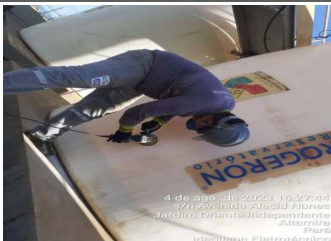
LIXAMENTO NO TANQUE DE CLORO PARA APLICAÇÃO DE VEDA-CHOQUE EM RACHADURA DETECTADA
