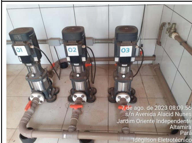
REVEZAMENTO EM BOMBAS DE PRESSURIZAÇÃO (MANOBRA REALIZADA DA BOMBA 03 PARA A BOMBA
