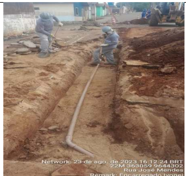
RUA MANOEL AMORIM, S/N- BAIRRO LIBERDADE 01
