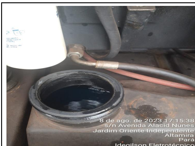
ABASTECIMENTO DO GERADOR DA ETA - ESTAÇÃO DE TRATAMENTO DE ÁGUA COM 50 LITROS DE COMBUSTÍVEL (DIESEL)
