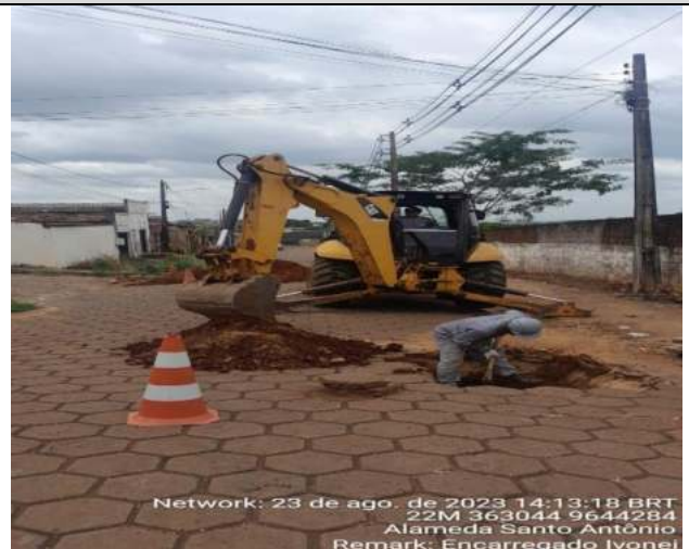
RUA MANOEL AMORIM, S/N- BAIRRO LIBERDADE 01
