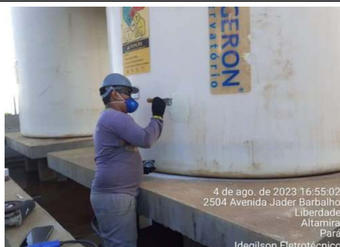
LIXAMENTO NO TANQUE DE CLORO PARA APLICAÇÃO DE VEDA-CHOQUE EM RACHADURA DETECTADA
