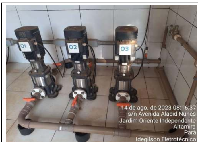
REVEZAMENTO EM BOMBAS DE PRESSURIZAÇÃO
