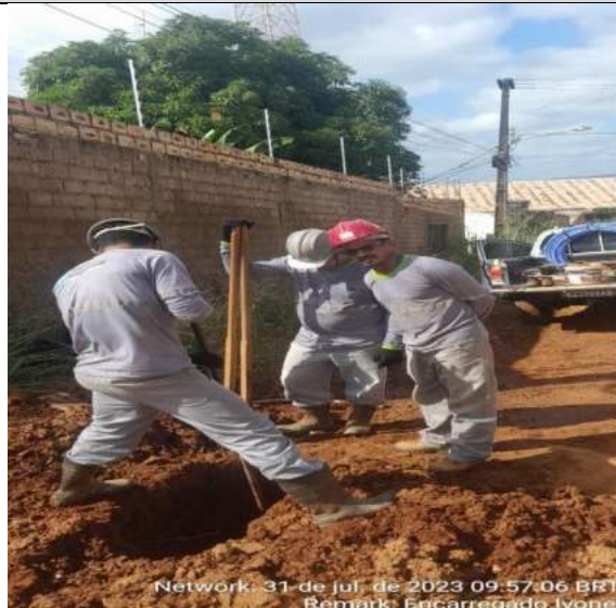
Rua Horácio boanerges, 180- bairro mirante
