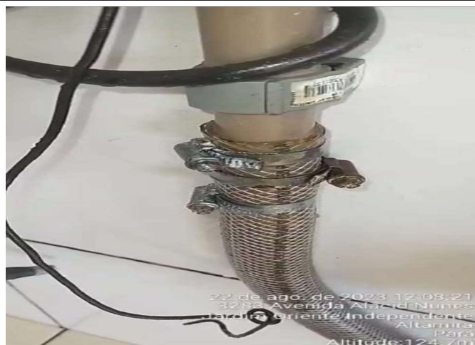
INSTALAÇÃO DE ABRAÇADEIRA NA REDE DE DOSAGEM DE PAC
