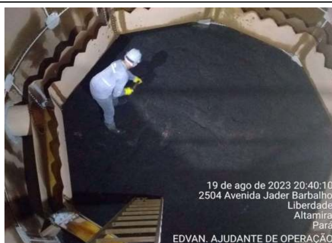
PROCESSO DE DESCOMPACTAÇÃO DE CARVÃO NO FILTRO 05
