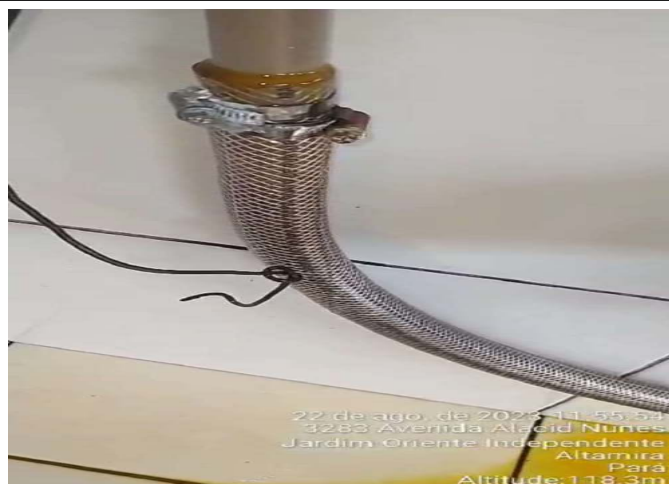
INSTALAÇÃO DE ABRAÇADEIRA NA REDE DE DOSAGEM DE PAC
