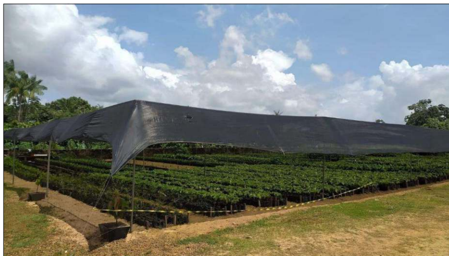
Figura 01 - Viveiro com estrutura de aço galvanizado e cobertura de sombrite. Foto: SOUSA, 2022.
