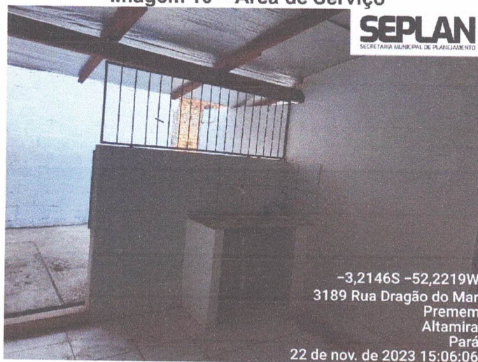
Imagem 10 – Área de Serviço
