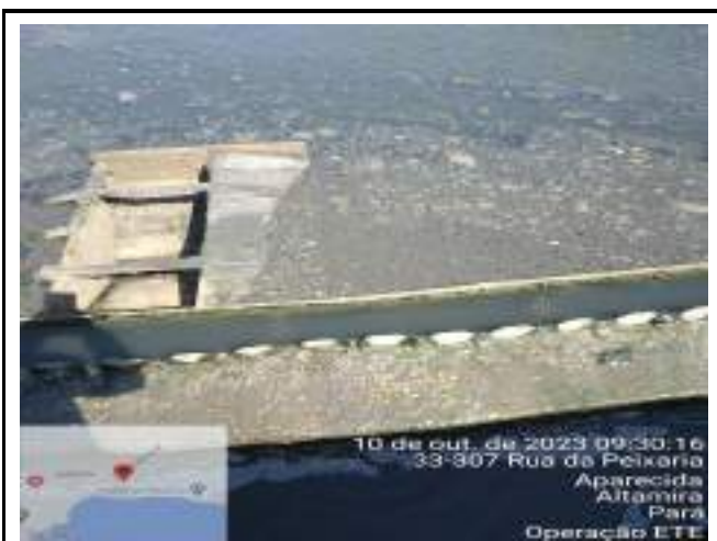
RETIRADA DE SOBRENADANTES DOS TANQUES DECANTADORES SECUNDÁRIOS
