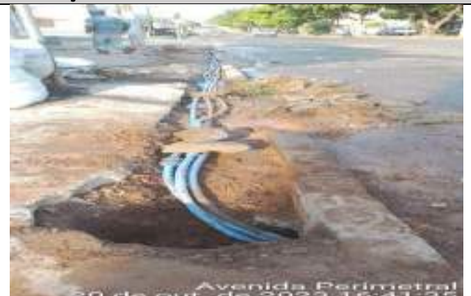
AVENIDA PERIMETRAL PRÓX. AO BOI NA BRASA
