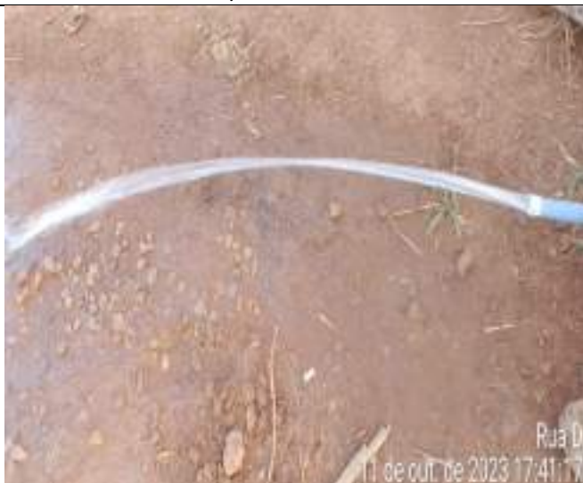
RUA D S/N BAIRRO MIRANTE
