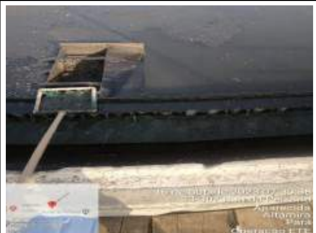
RETIRADA DE SOBRENADANTES DOS TANQUES DECANTADORES SECUNDÁRIOS
