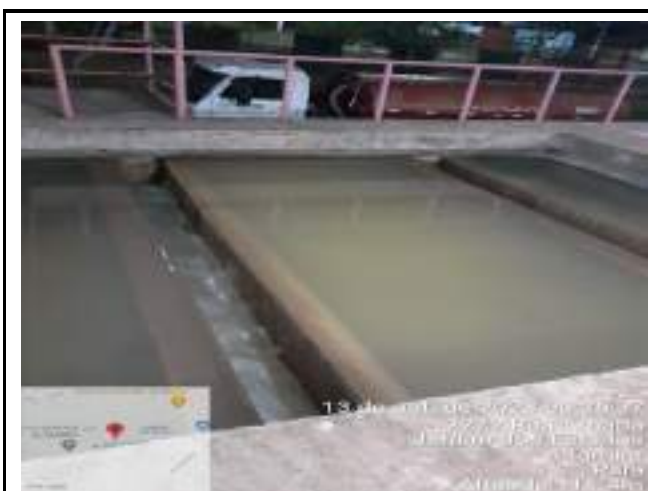
LAVAGEM DOS FILTROS DE CONCRETO DA ETA CONVENCIONAL
