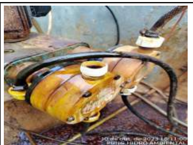
FOI RETIRADO O VAZAMENTO DE DOSADORA DE CLORETO FERRICO
