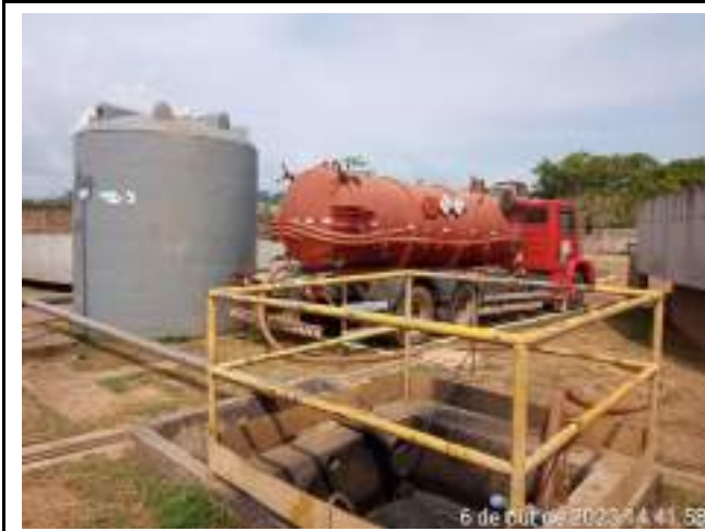
SUCÇÃO DA CAIXA DE ANTE ESPUMA
