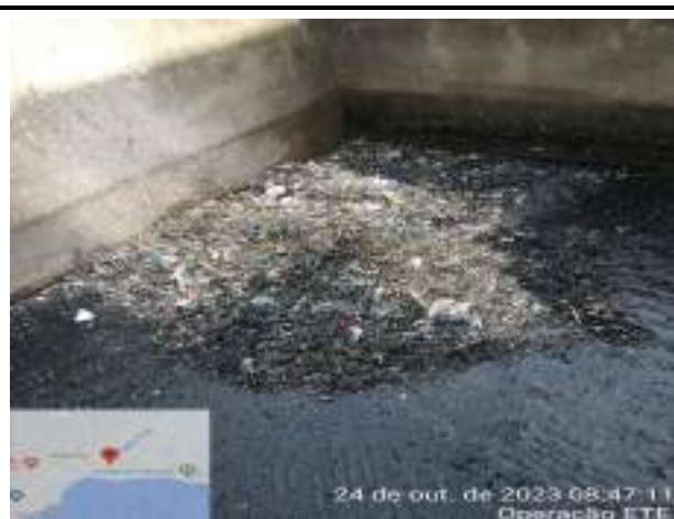
RETIRADA DOS RESÍDUOS SÓLIDOS DA CAIXA DOS KOMBIS
