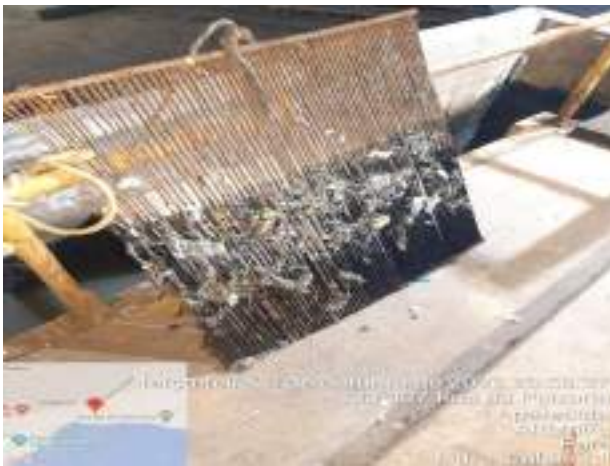
LIMPEZA DA DAS GRADES DE ENTRADA DE ESGOTO BRUTO
