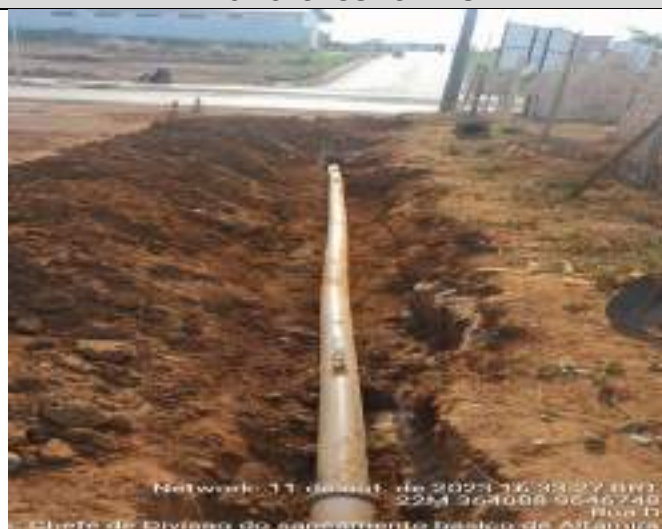
RUA D S/N BAIRRO MIRANTE
