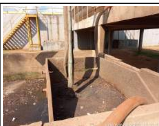
SUCÇÃO DA ÁGUA DAS CAIXAS DE AREIA DOS KOMBIS
