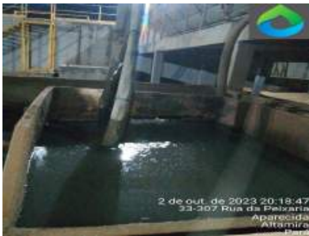
SUCÇÃO DA CAIXA DE AREIA DOS KOMBIS LINHA A
