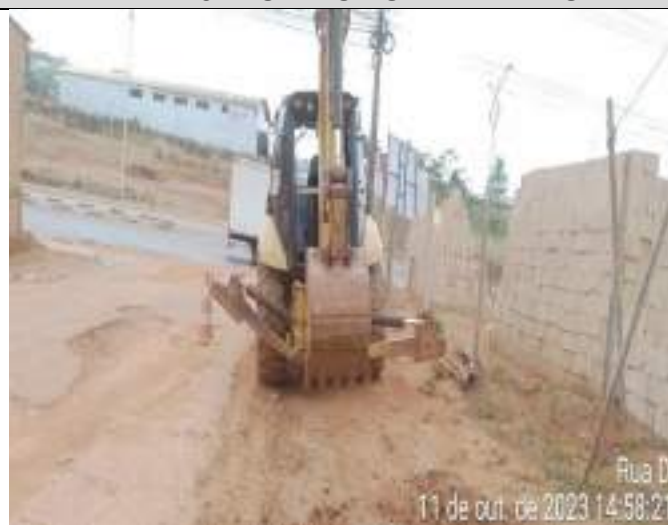
RUA D S/N BAIRRO MIRANTE
