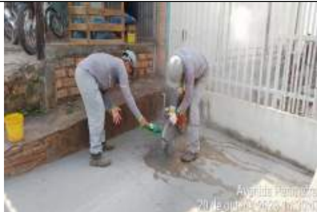
AVENIDA PERIMETRAL PRÓX. AO BOI NA BRASA
