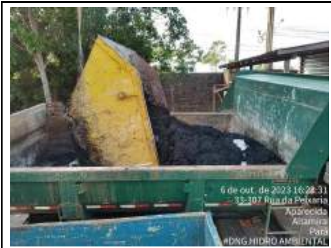
CENTRIFUGADOS 24 METROS CÚBICOS DE LODO RETIRADO DO TANQUE DECANTADOR SECUNDÁRIO LINHA B PARA O ATERRO SANITÁRIO.
