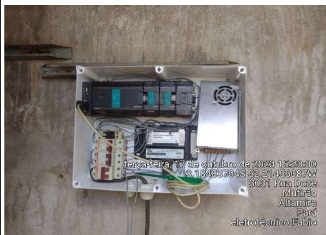
INSTALAÇÃO DE PAINEL COM CLP E UMA SONDA NO RAP - RESERVATÓRIO APOIADO DO BAIRRO MUTIRÃO
