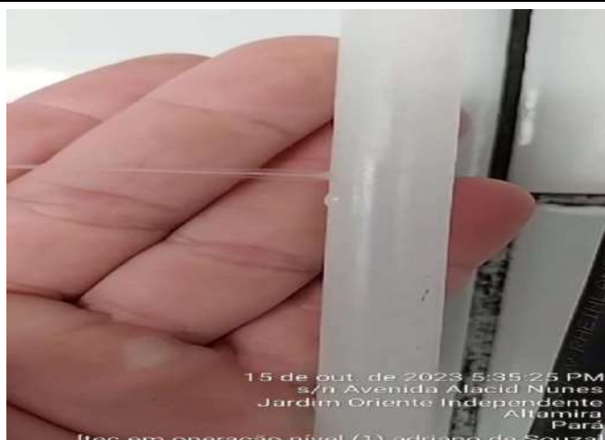
SUBSTITUIÇÃO DE MANGUEIRA DO CONTROLADOR DE PRESSÃO DAS BOMBAS DE PRESSURIZAÇÃO
