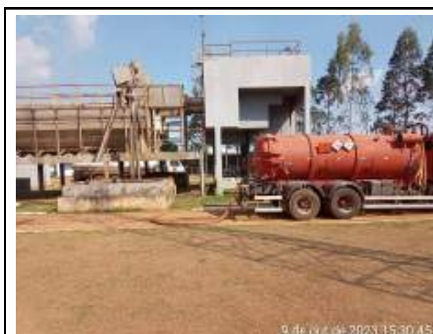
SUCÇÃO DA ÁGUA DAS CAIXAS DE AREIA DOS KOMBIS
