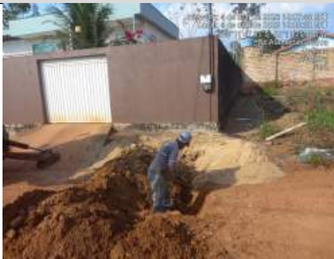
ALAMEDA GOIANA LOTE 11 BAIRRO ALTAVILLI
