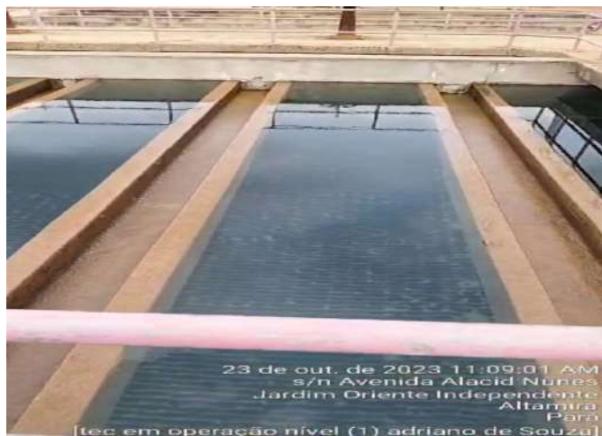
MONITORAMENTO DOS DECANTADORES DA ETA CONVENCIONAL E DA ETA MODULAR, RESPECTIVAMENTE
