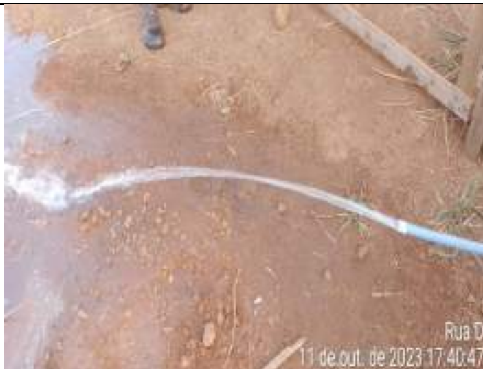
RUA D S/N BAIRRO MIRANTE
