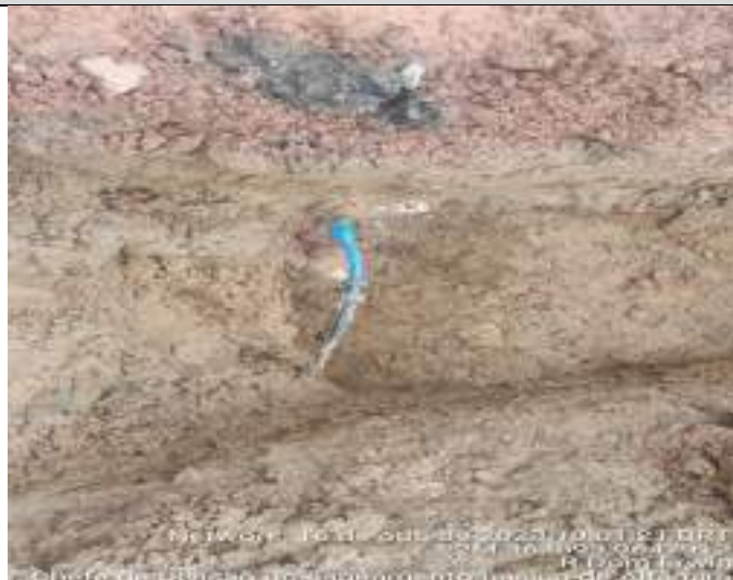
RUA 01, 140 E 3134- BAIRRO PAIXÃO DE CRISTO
