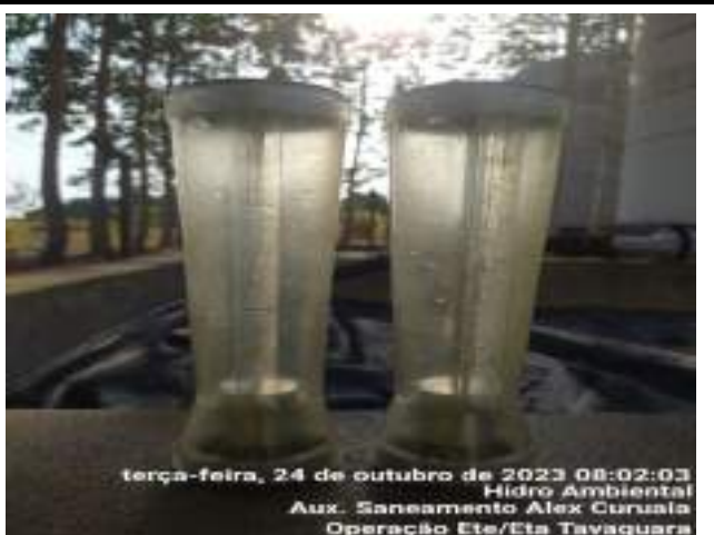
LIMPEZA DOS ROTÂMETROS
