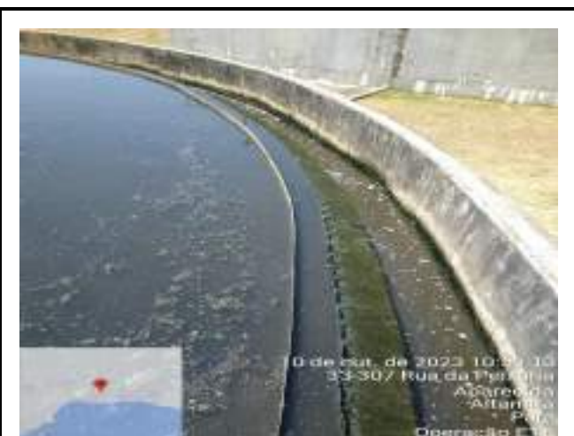
RETIRADA DE SOBRENADANTES DOS TANQUES DECANTADORES SECUNDÁRIOS
