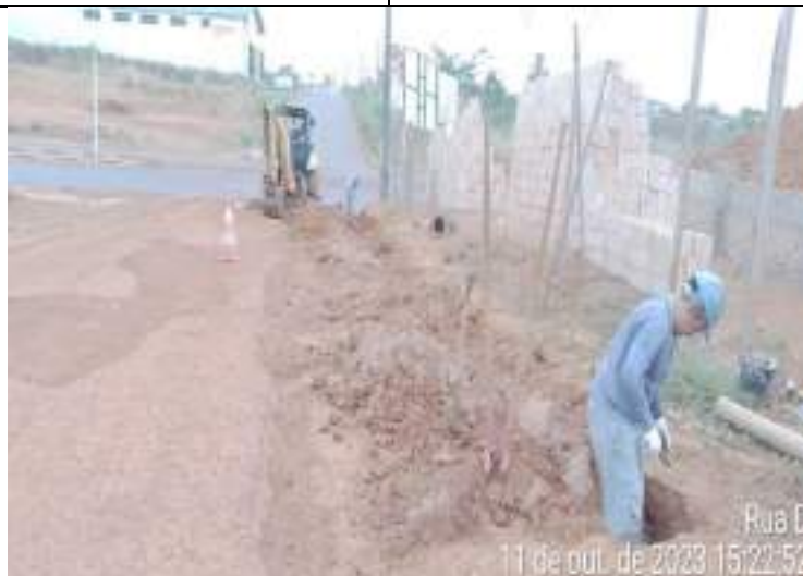
RUA D S/N BAIRRO MIRANTE
