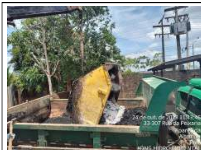
CENTRIFUGADO 20 m 3 DE LODO
