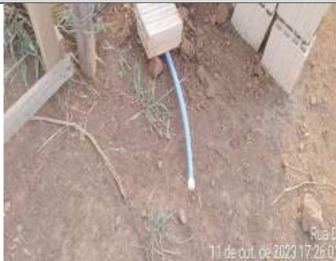
RUA D S/N BAIRRO MIRANTE
