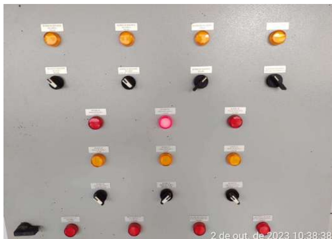
REVEZAMENTO EM BOMBAS DE PRESSURIZAÇÃO
