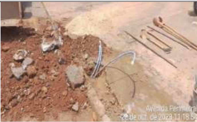
AVENIDA PERIMETRAL PRÓX. AO BOI NA BRASA
