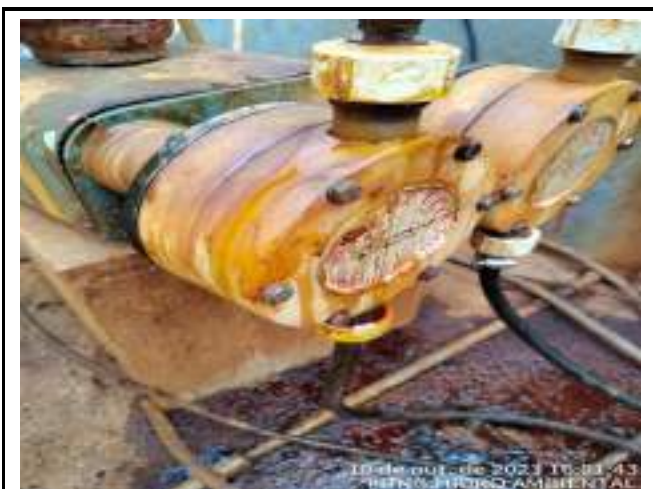
FOI RETIRADO O VAZAMENTO DE DOSADORA DE CLORETO FERRICO
