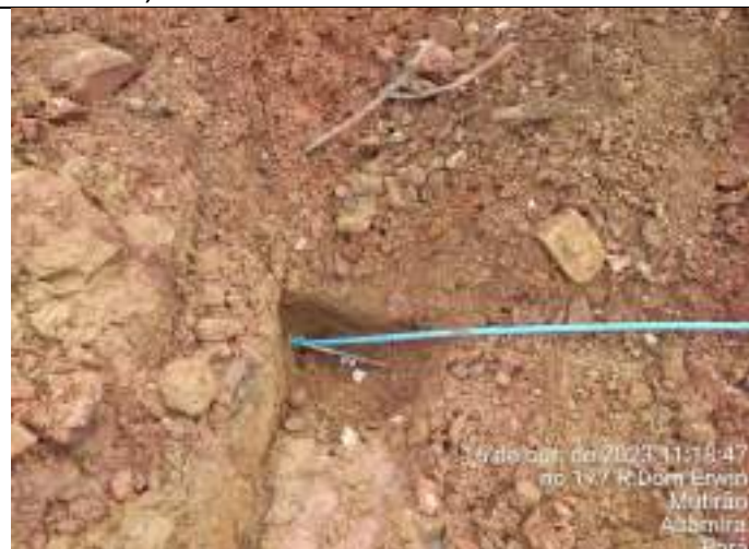
RUA 01, 140 E 3134- BAIRRO PAIXÃO DE CRISTO
