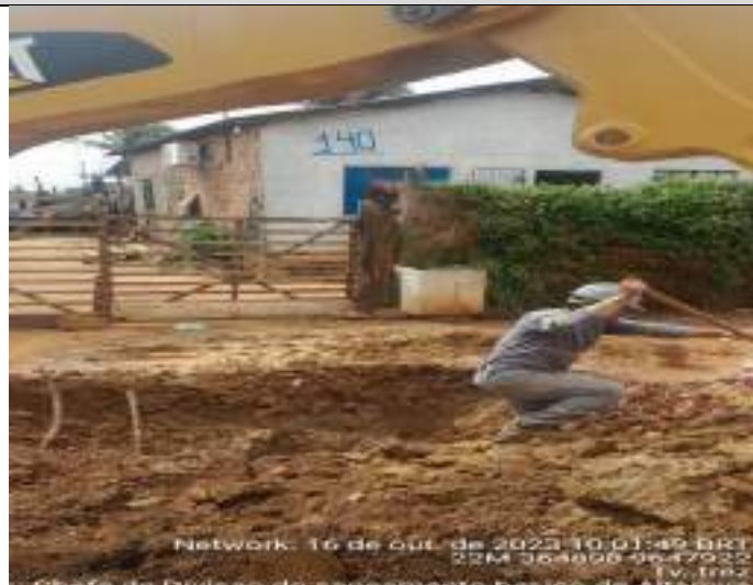
RUA 01, 140 E 3134- BAIRRO PAIXÃO DE CRISTO
