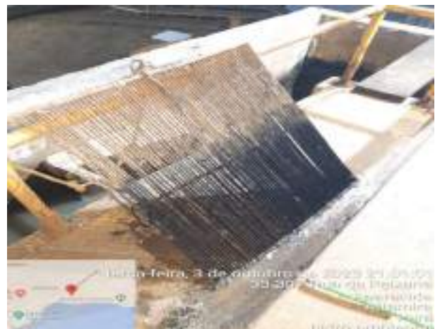
LIMPEZA DA DAS GRADES DE ENTRADA DE ESGOTO BRUTO
