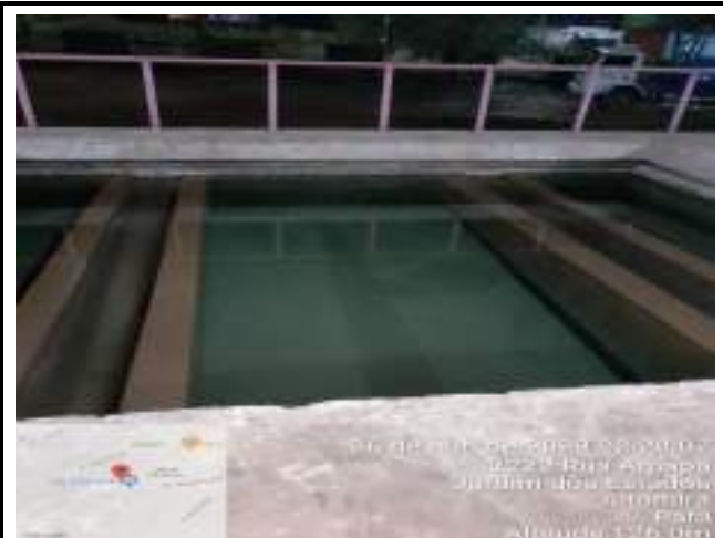
RETROLAVAGEM DOS FILTROS DE CONCRETO ETA CONVENCIONAL
