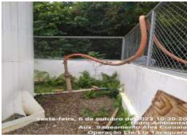
ABASTECIMENTO DA CAIXA COM CARRO PIPA
