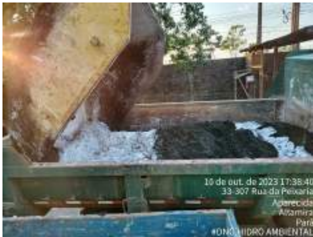
CENTRIFUGADO 30 M 3 DE LODO
