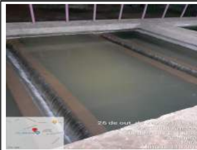
RETROLAVAGEM DOS FILTROS DE CONCRETO ETA CONVENCIONAL
