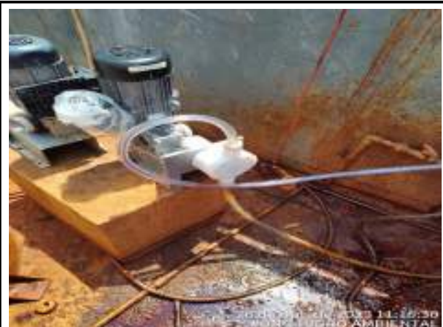
MONTAGEM E INSTALAÇÃO DAS DOSADORAS DE BARRILHA
