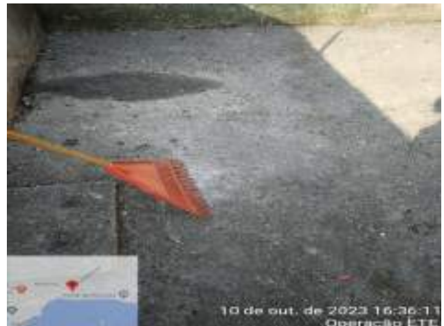
LIMPEZA DOS RESÍDUOS SÓLIDOS DOS KOMBIS
