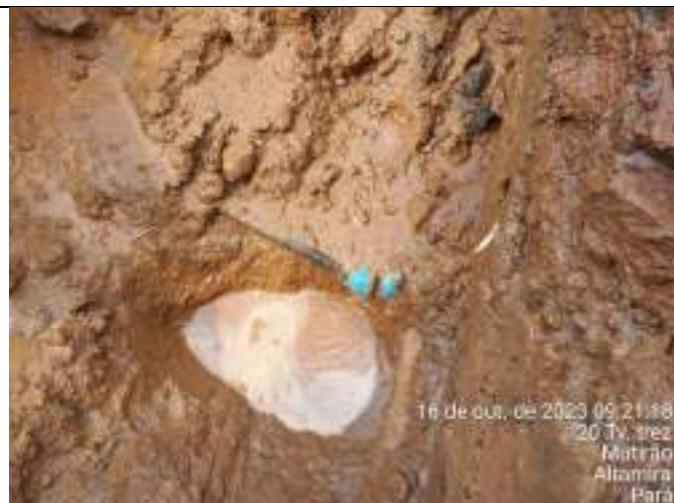
RUA 01, 140 E 3134- BAIRRO PAIXÃO DE CRISTO
