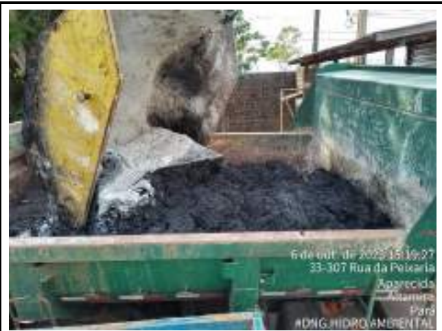
CENTRIFUGADOS 24 METROS CÚBICOS DE LODO RETIRADO DO TANQUE DECANTADOR SECUNDÁRIO LINHA B PARA O ATERRO SANITÁRIO.
