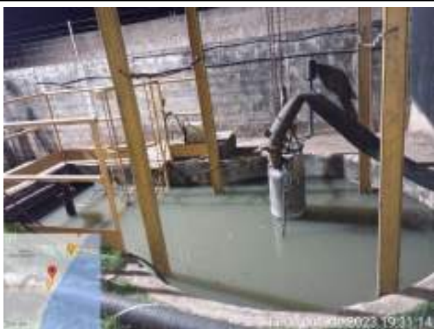
FOI FEITA A SUÇÃO DO ESGOTO DA ELEVATÓRIA IBAMA
