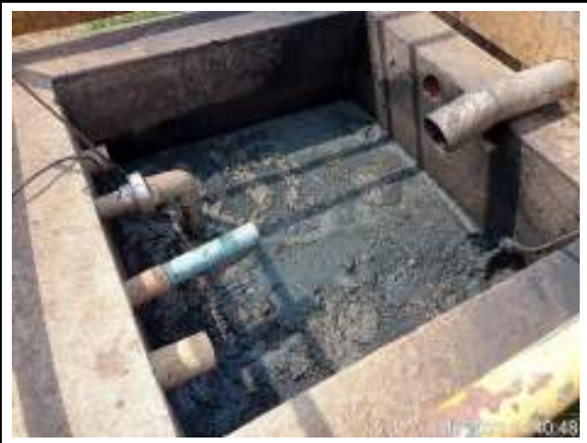
SUCÇÃO DA CAIXA DE ANTE ESPUMA
