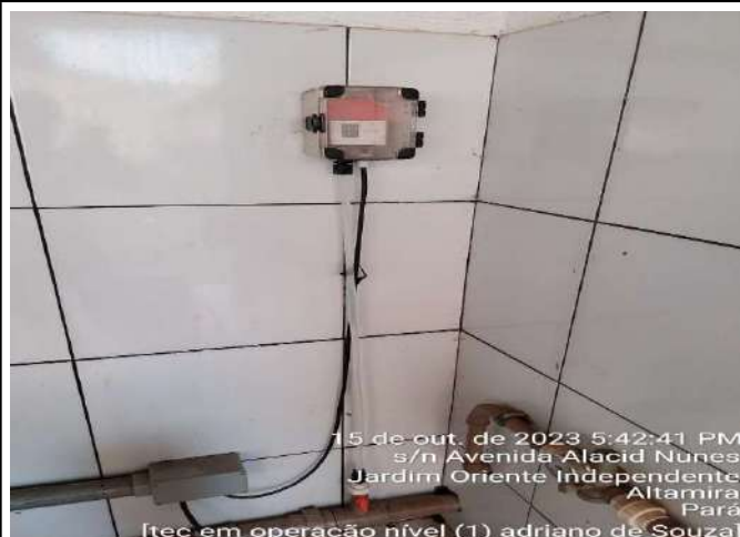
SUBSTITUIÇÃO DE MANGUEIRA DO CONTROLADOR DE PRESSÃO DAS BOMBAS DE PRESSURIZAÇÃO
