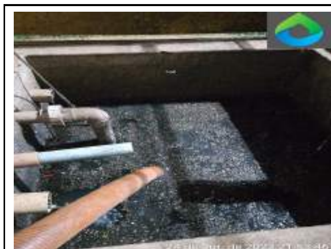
SUCÇÃO DA CAIXA DE ANTI ESPUMA
