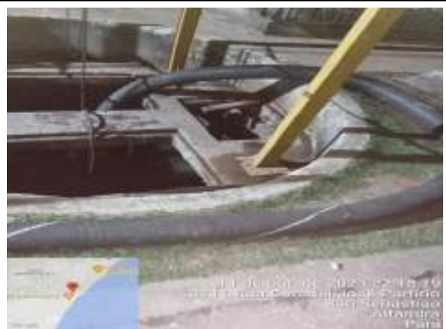
FOI FEITA A SUÇÃO DO ESGOTO DA ELEVATÓRIA IBAMA
