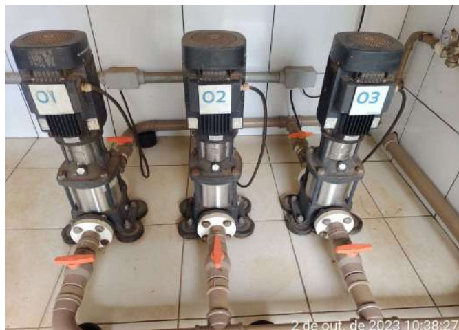
REVEZAMENTO EM BOMBAS DE PRESSURIZAÇÃO
