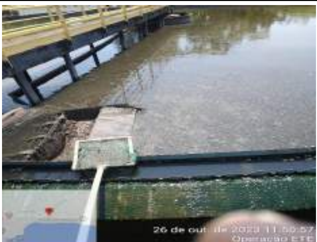
RETIRADA DE SOBRENADANTES DOS TANQUES DECANTADORES SECUNDÁRIOS
