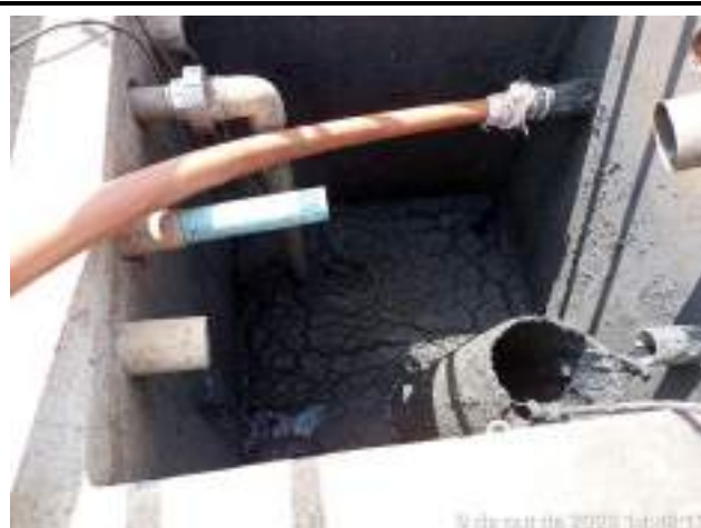
SUCÇÃO DA CAIXA DE ESPUMA
