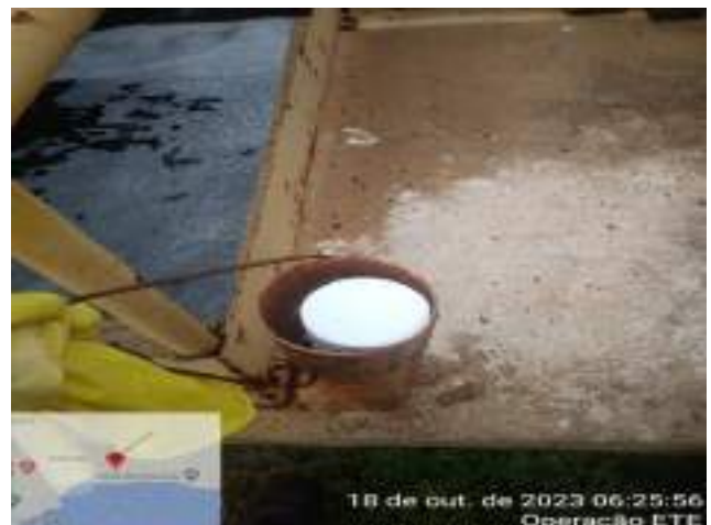
ADIÇÃO DE PASTILHA CLORO NO EMISSÁRIO FINAL
