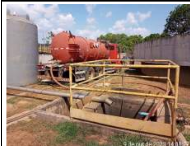
SUCÇÃO DA CAIXA DE ESPUMA
