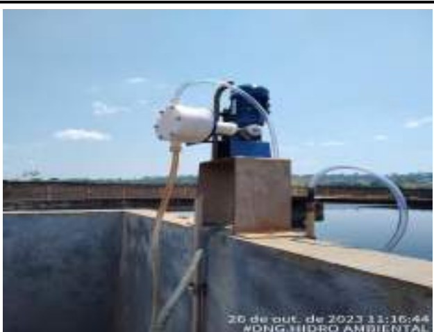
MONTAGEM E INSTALAÇÃO DAS DOSADORAS DE BARRILHA
