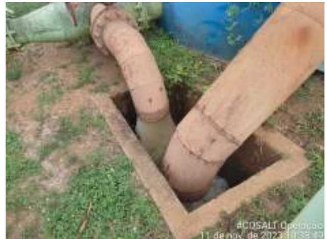
RETROLAVAGEM DOS FILTROS DE METAL
