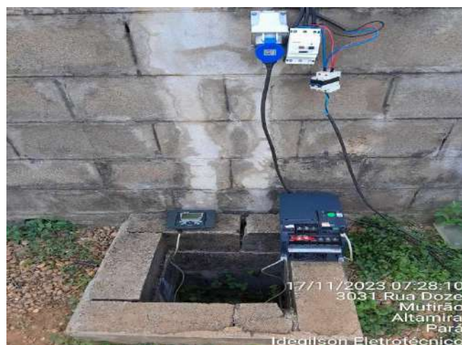
INSTALAÇÃO DE INVERSOR DE FREQUÊNCIA NO RAP - RESERVATÓRIO APOIADO DO BAIRRO MUTIRÃO
