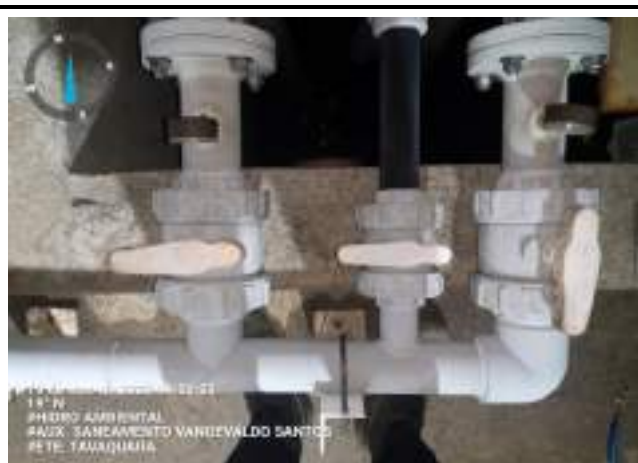
TROCA DE REGISTRO
