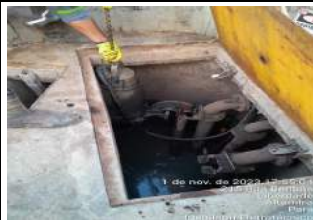
FEITO MANUTENÇÃO NA BOMBA DO EEE C.NOVA
