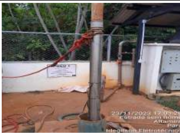
INSTALAÇÃO DA BOMBA DA ETA
