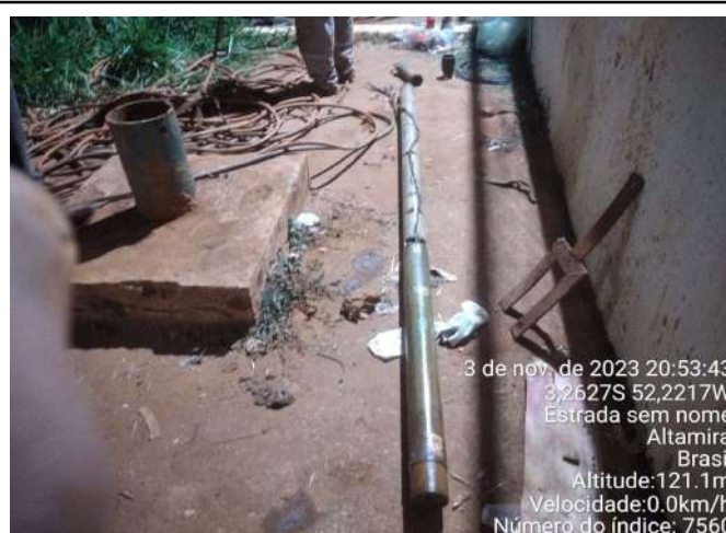
RETIRADA DA BOMBA DO POÇO DO RUC TAVAQUARA PARA ENCAMINHAMENTO À MANUTENÇÃO
