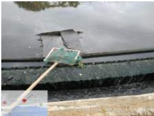
RETIRADA DE SOBRENADANTES DOS TANQUES DECANTADORES SECUNDÁRIOS
