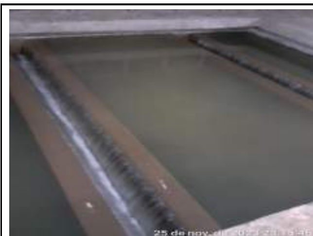
RETROLAVAGEM DOS FILTROS DE CONCRETO ETA CONVENCIONAL
