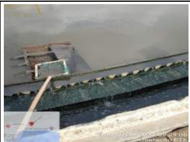
RETIRADA DE SOBRENADANTES DOS TANQUES DECANTADORES SECUNDÁRIOS
