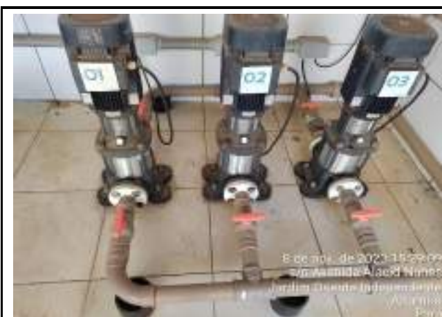
SISTEMA DE PRESSURIZAÇÃO, TROCA DA BOMBA
