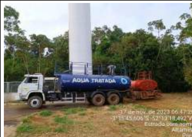
ABASTECIMENTO DA CAIXA D'ÁGUA
