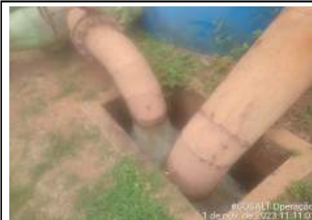
DESCARGA NOS FILTROS METAL ETA CONVENCIONAL
