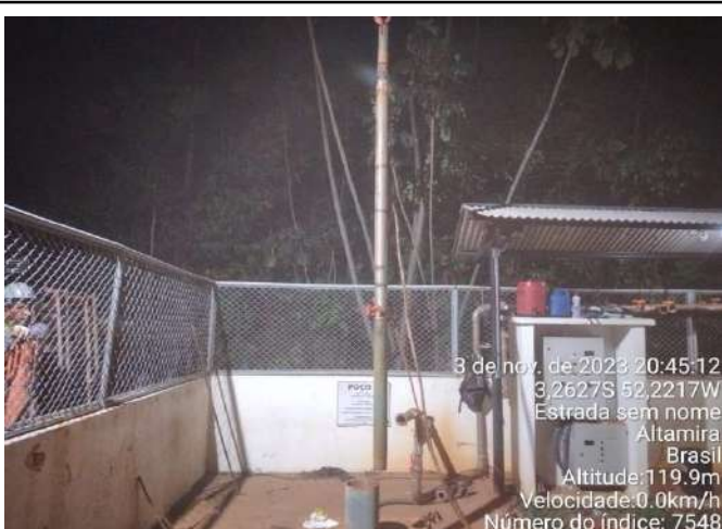
RETIRADA DA BOMBA DO POÇO DO RUC TAVAQUARA PARA ENCAMINHAMENTO À MANUTENÇÃO
