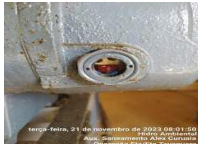
VERIFICAÇÃO DO ÓLEO DO SOPRADOR
