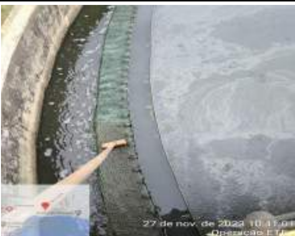
LIMPEZA DAS BORDAS DOS TANQUES DECANTADORES
