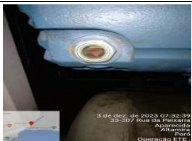
VERIFICAÇÃO DO ÓLEO DO SOPRADOR
