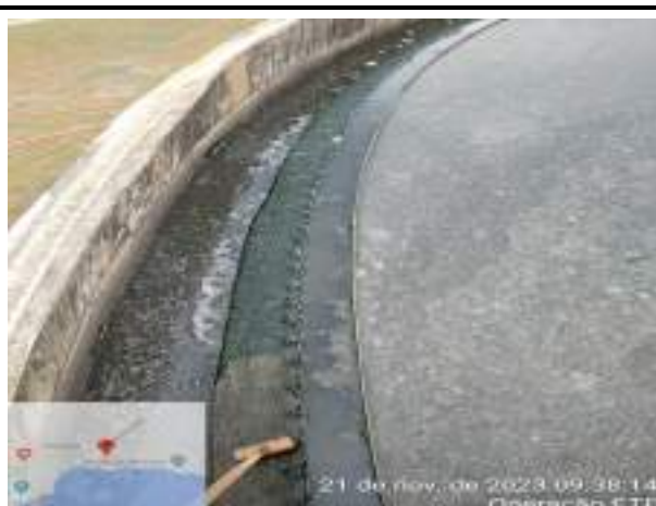
LIMPEZA DOS VERTEDOUROS E BORDAS DOS TANQUES DECANTADORES SECUNDÁRIOS E TERCIÁRIOS
