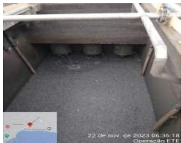
SECAGEM DOS TANQUES AERADOS PARA MANUTENÇÃO E LIMPEZA DOS CESTOS
