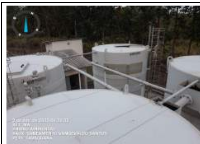
MONITORAMENTO DA PARTE SUPERIOR DOS MÓDULOS
