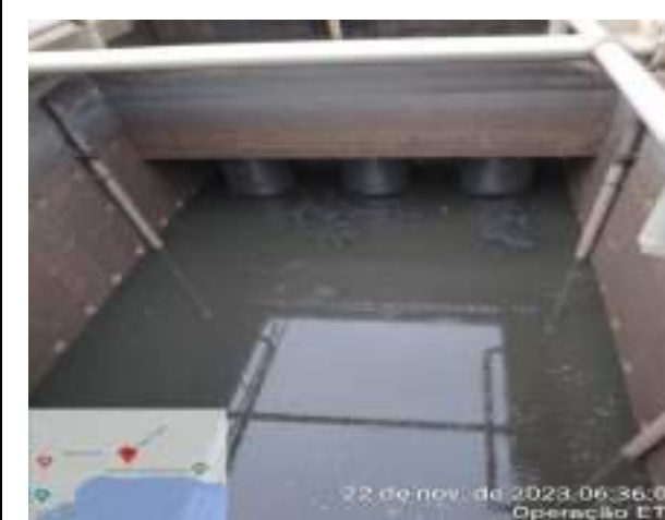
SECAGEM DOS TANQUES AERADOS PARA MANUTENÇÃO E LIMPEZA DOS CESTOS
