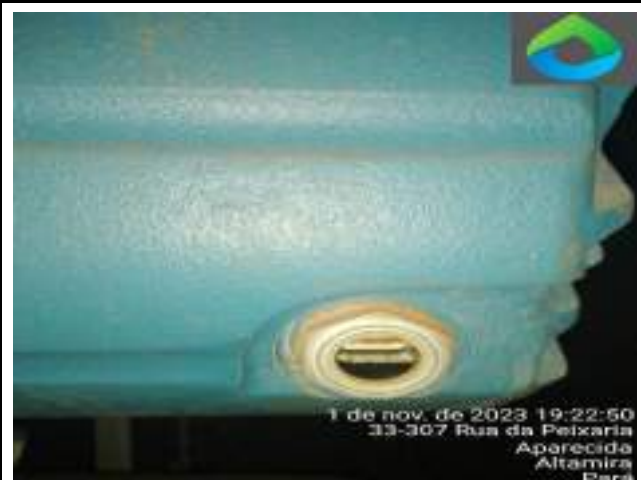
VERIFICAÇÃO DO ÓLEO DOS SOPRADORES
