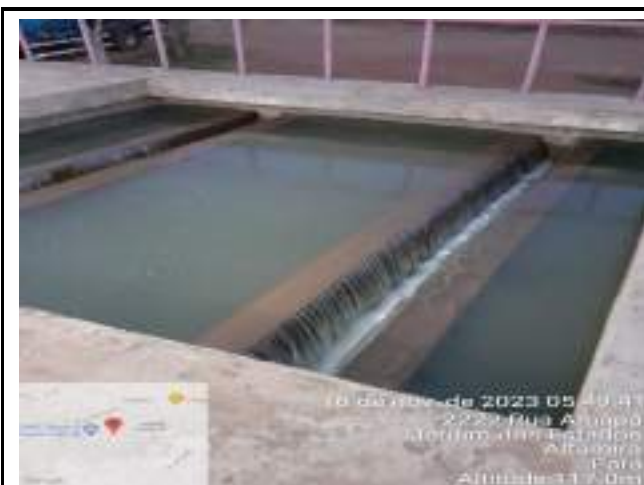
RETROLAVAGEM DOS FILTROS DE CONCRETO ETA CONVENCIONAL
