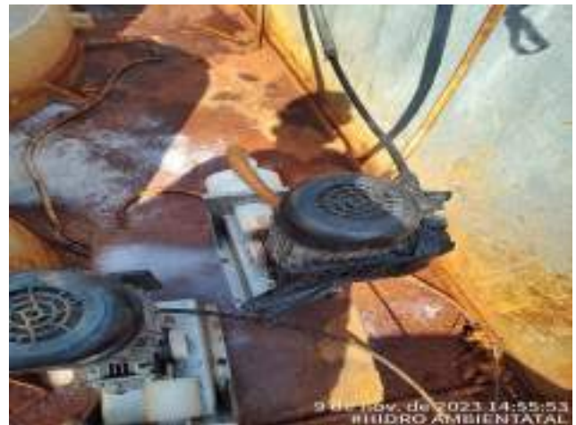
DEVIDO A DOSADORA DE ANTI-ESPUMA ESTAR SEM PRESSÃO FOI FEITO A TROCA DA MESMA
