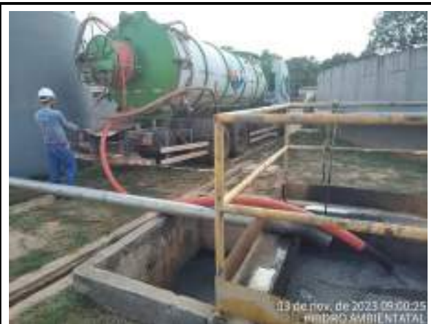
SUCÇÃO DA CAIXA DE ANTI ESPUMA
