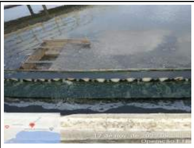
RETIRADA DE SOBRENADANTES DOS TANQUES DECANTADORES
