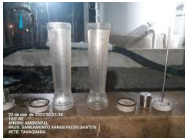
LIMPEZA DOS ROTÂMETROS
