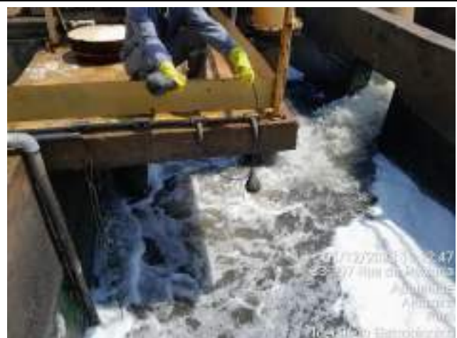
EEE 14 EFLUENTES EM FALHA, FOI FEITO RESET, O OPERADOR YGO DESTRAVOU A BOIA E FOI NORMALIZADO.
