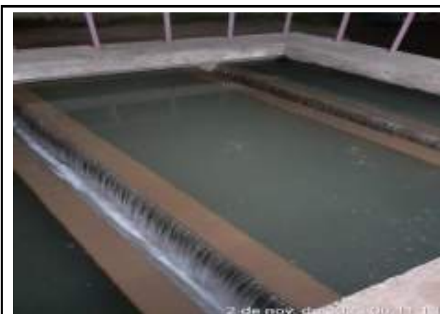
RETROLAVAGEM DOS FILTROS DE CONCRETO ETA CONVENCIONAL
