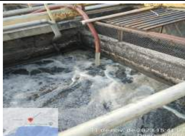
OS CESTOS DO 2º TANQUE AERADO ESTAVAM OBSTRUÍDOS, FIZEMOS AS MANOBRAS NECESSÁRIAS MAS NÃO OBTIVEMOS ÊXITO, FOI PRECISO INSTALAR A BOMBA EJ40 PARA O CONTROLE DO FLUXO DA ÁGUA, ATÉ A LIMPEZA E MANUTENÇÃO DOS MESMOS.
