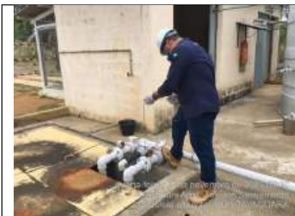
Foto 1: Ponto de coleta – entrada do efluente bruto
