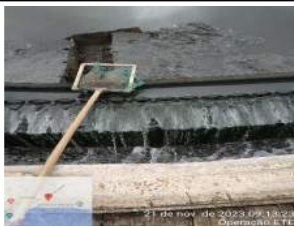
RETIRADA DE SOBRENADANTES DOS TANQUES DECANTADORES SECUNDÁRIOS
