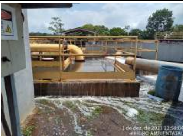
EEE 14 EFLUENTES EM FALHA, FOI FEITO RESET, O OPERADOR YGO DESTRAVOU A BOIA E FOI NORMALIZADO.
