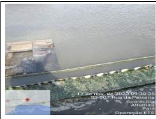
RETIRADA DE SOBRENADANTES DOS TANQUES DECANTADORES
