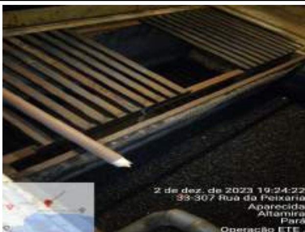
TANQUE AERADO LIMHA B ESTA COM O FINAL OBSTRUÍDO IMPOSSIBILITANDO A PASSAGEM DO EFLUENTE, FOI INSTADO A BOMBA EJ40 PARA DIMINUIR O VOLUME DE ÁGUA.
