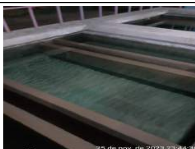
RETROLAVAGEM DOS FILTROS DE CONCRETO ETA CONVENCIONAL
