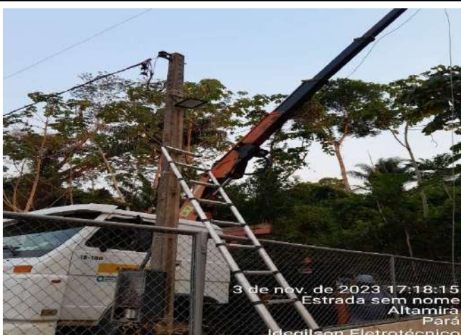
INSTALAÇÃO DE REFLETOR NO POÇO DO RUC TAVAQUARA
