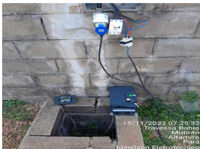
INSTALAÇÃO DE INVERSOR DE FREQUÊNCIA NO RAP - RESERVATÓRIO APOIADO DO BAIRRO MUTIRÃO
