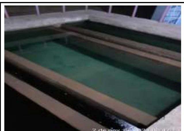
RETROLAVAGEM DOS FILTROS DE CONCRETO ETA CONVENCIONAL
