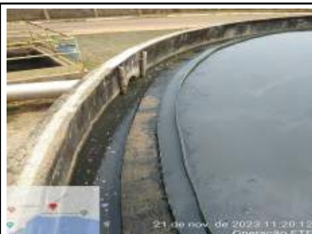
LIMPEZA DOS VERTEDOUROS E BORDAS DOS TANQUES DECANTADORES SECUNDÁRIOS E TERCIÁRIOS
