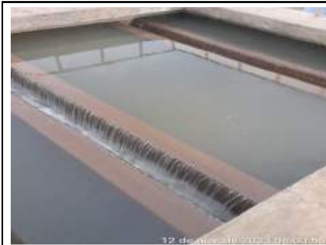
RETROLAVAGEM DOS FILTROS DE CONCRETO ETA CONVENCIONAL
