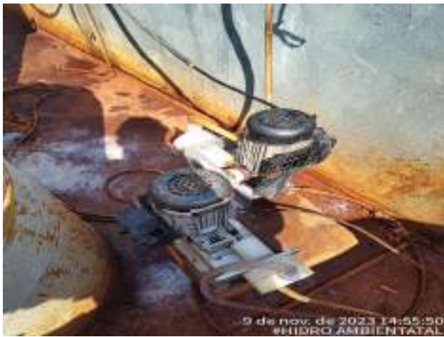
DEVIDO A DOSADORA DE ANTI-ESPUMA ESTAR SEM PRESSÃO FOI FEITO A TROCA DA MESMA
