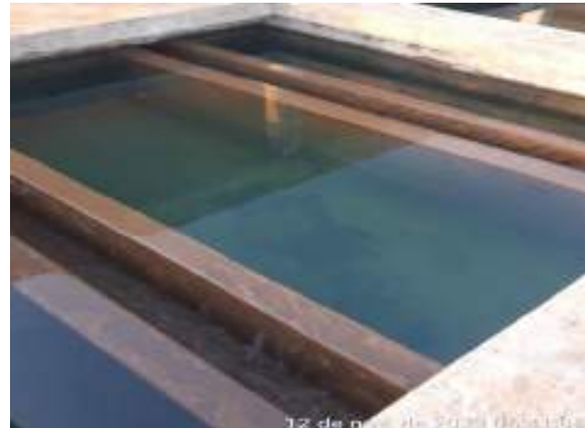
RETROLAVAGEM DOS FILTROS DE CONCRETO ETA CONVENCIONAL
