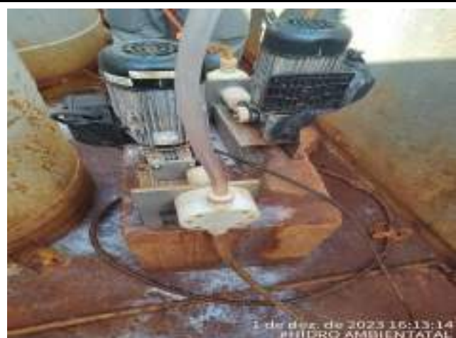
DOSADORA DE BARRILHA ESTAVA COM VAZAMENTO DEVIDO O DIAFRAGMA ESTÁ DANIFICADO, FOI FEITO A SUBSTITUIÇÃO DO MESMO E O VAZAMENTO FOI RESOLVIDO
