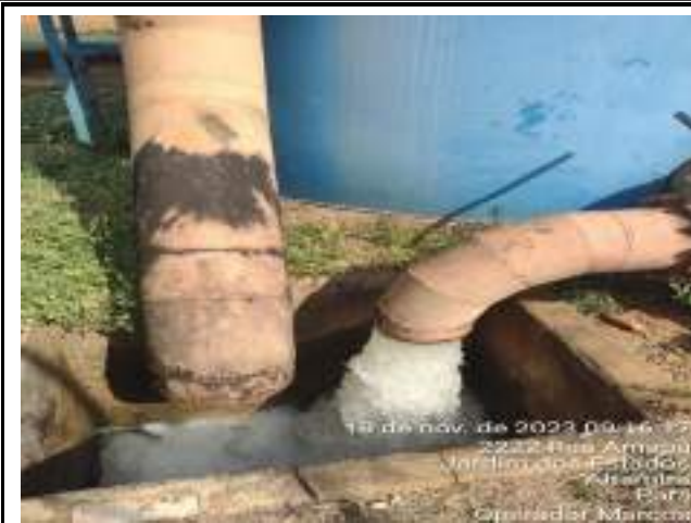
RETROLAVAGEM DOS FILTROS DE METAL ETA CONVENCIONAL
