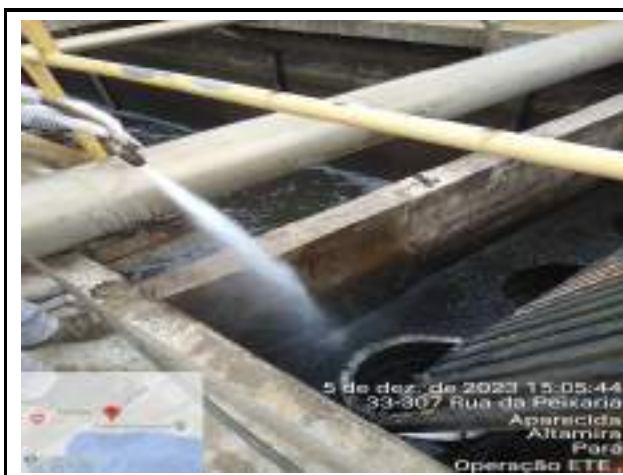
LAVAGEM E LIMPEZA DOS CESTOS DOS TANQUES AERADOS
