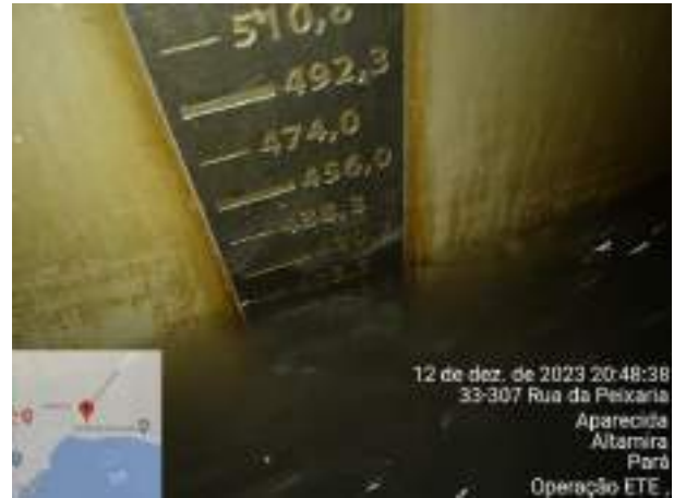
MONITORAMENTO DO VASÃO
