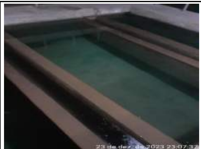
RETROLAVAGEM DOS FILTROS DE CONCRETO ETA CONVENCIONAL
