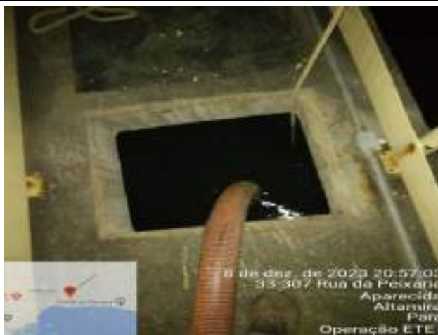
SECAGEM DO TANQUE AERADO PARA LIMPEZA DA ENTRADA DO ESGOTO
