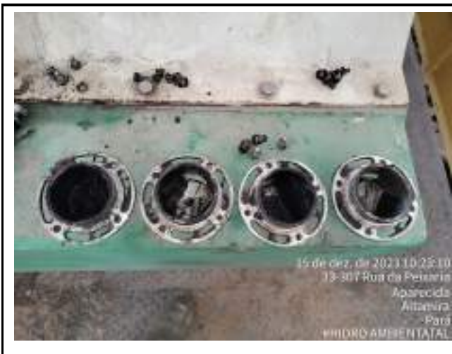
DESMONTAGEM DOS COPINHOS DO DECANTER PARA LIMPEZA
