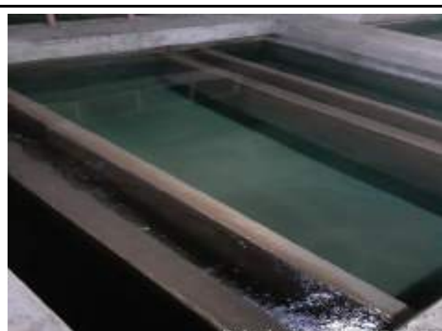
RETROLAVAGEM DOS FILTROS DE CONCRETO ETA CONVENCIONAL
