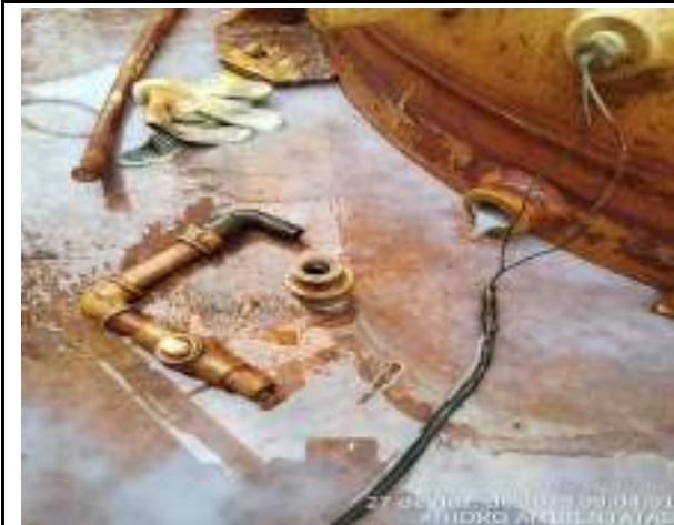
FOI FEITA A TROCA DAS CONEXÕES QUEBRADAS DA TINA DE ANTI-ESPUMA.
