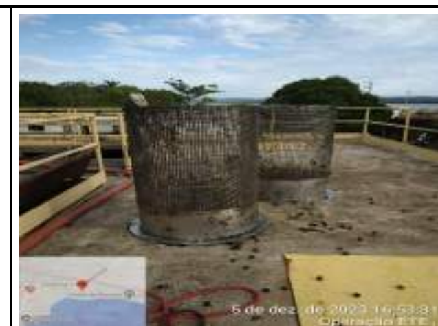
LAVAGEM E LIMPEZA DOS CESTOS DOS TANQUES AERADOS
