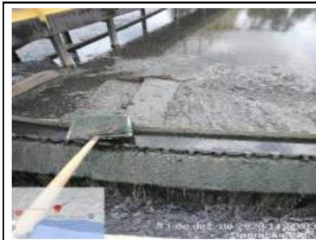
RETIRADA DE SOBRENADANTES DOS TANQUES DECANTADORES SECUNDÁRIOS
