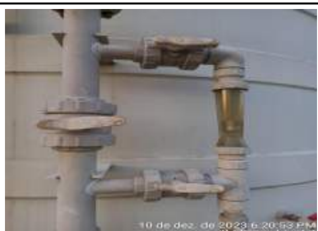
MONITORAMENTO DO VASÃO
