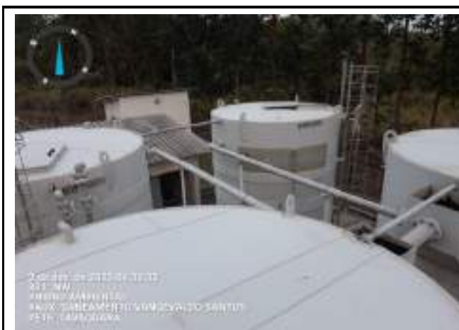
MONITORAMENTO DA PARTE SUPERIOR DOS MÓDULOS
