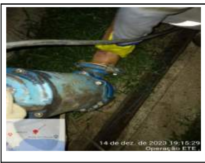
FOI INSTALADO A BOMBA EJ40 PARA RETIRADA DE MATERIAL DO TANQUE TERCIÁRIO LINHA A PARA O TANQUE TERCIÁRIO LINHA B.
