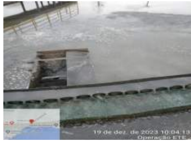
RETIRADA DE SOBRENADANTES DOS TANQUES DECANTADORES SECUNDÁRIOS
