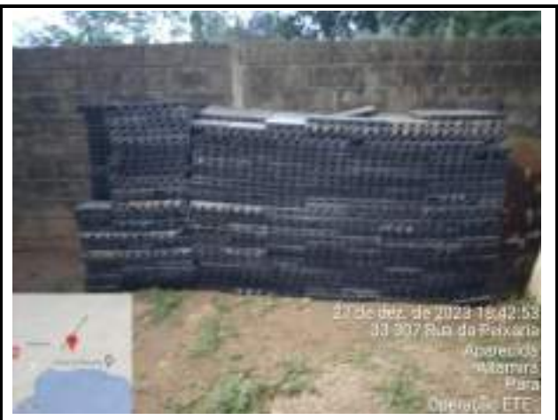
LIMPEZA E ORGANIZAÇÃO DOS FILTROS DO LEITO DE SECAGEM
