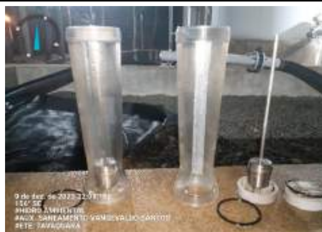
LIMPEZA DOS ROTÂMETROS
