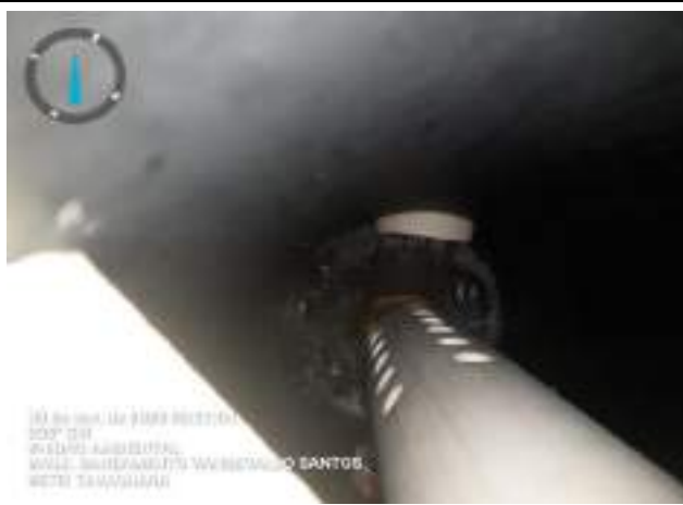
MONITORAMENTO DO EMISSÁRIO FINAL E ADIÇÃO DE PASTILHA D CLORO
