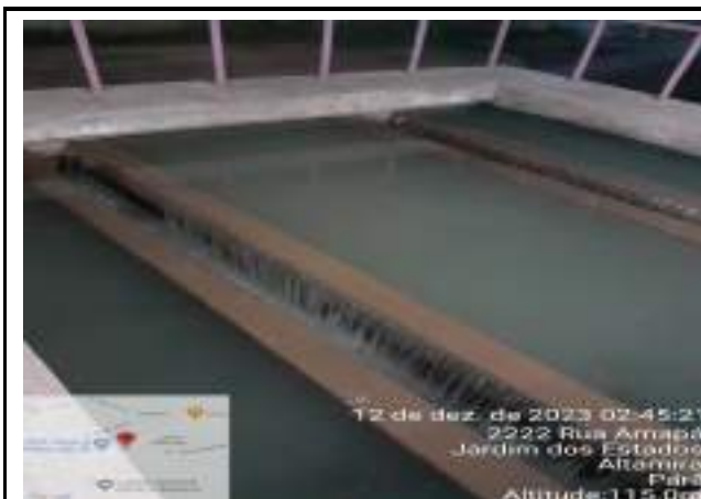
RETROLAVEGEM DOS FILTROS DE METAL ETA CONVENCIONAL
