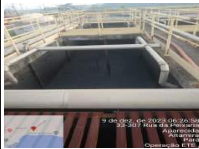
SECAGEM DO TANQUE AERADO PARA LIMPEZA DA ENTRADA DO ESGOTO
