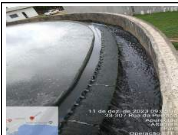
LIMPEZA DAS BORDAS DOS TANQUES DECANTADORES
