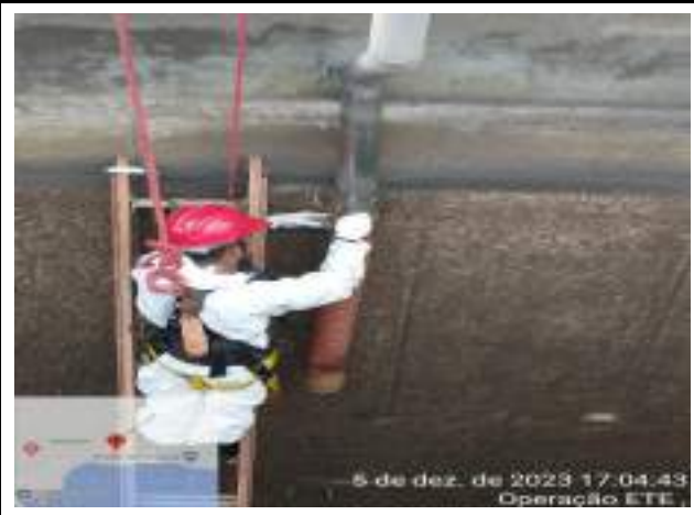
SECAGEM DO TANQUE AERADO PARA MANUTENÇÃO DO TUBO DE AR.
