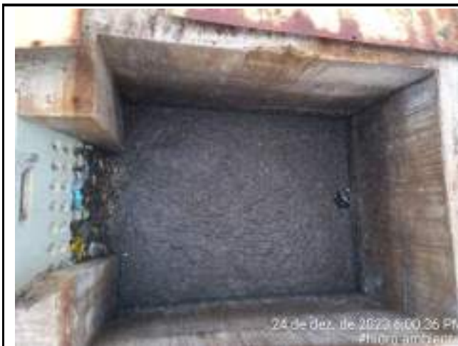
LIMPEZA DA CAIXA DE ENTRADA DO ESGOTO BRUTO
