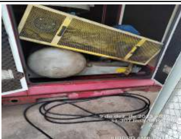
DESMONTAGEM DO SOPRADOR 3 PARA TROCA DE CORREIAS
