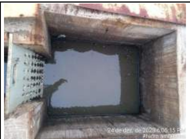
LIMPEZA DA CAIXA DE ENTRADA DO ESGOTO BRUTO
