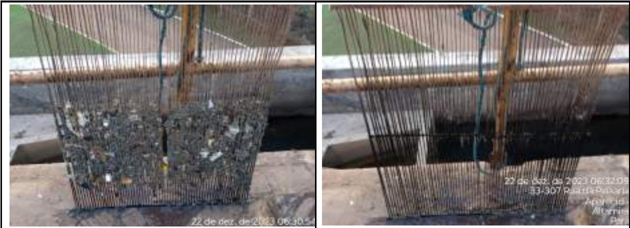
LIMPEZA DAS GRADES DE ENTRADA DO ESGOTO BRUTO.
