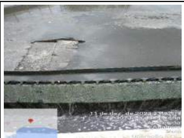
RETIRADA DE SOBRENADANTES DOS TANQUES DECANTADORES SECUNDÁRIOS
