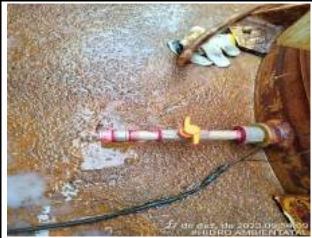
FOI FEITA A TROCA DAS CONEXÕES QUEBRADAS DA TINA DE ANTI-ESPUMA.
