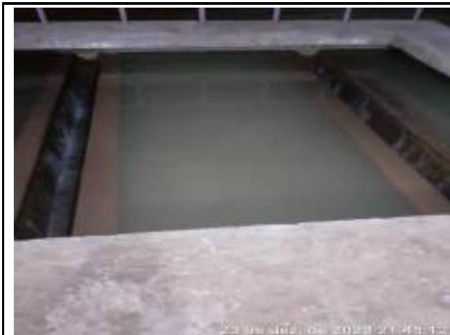
RETROLAVAGEM DOS FILTROS DE CONCRETO ETA CONVENCIONAL
