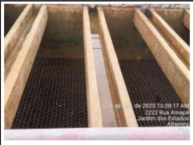
LIMPEZA DAS COLMEIAS DOS CANTADORES ETA CONVENCIONAL
