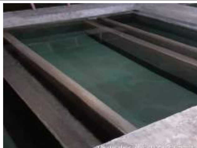
RETROLAVAGEM DOS FILTROS DE CONCRETO ETA CONVENCIONAL
