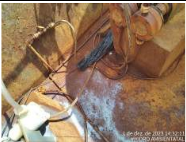
DOSADORA DE BARRILHA ESTAVA COM VAZAMENTO DEVIDO O DIAFRAGMA ESTÁ DANIFICADO, FOI FEITO A SUBSTITUIÇÃO DO MESMO E O VAZAMENTO FOI RESOLVIDO
