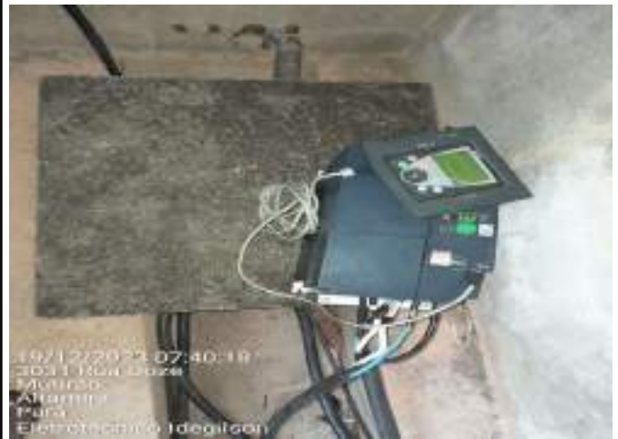
INSTALAÇÃO DE INVERSOR DE FREQUÊNCIA NO RAP - RESERVATÓRIO APOIADO DO BAIRRO MUTIRÃO
