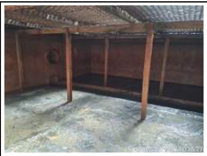
LIMPEZA DO FUNDO DOS CANTADORES ETA CONVENCIONAL
