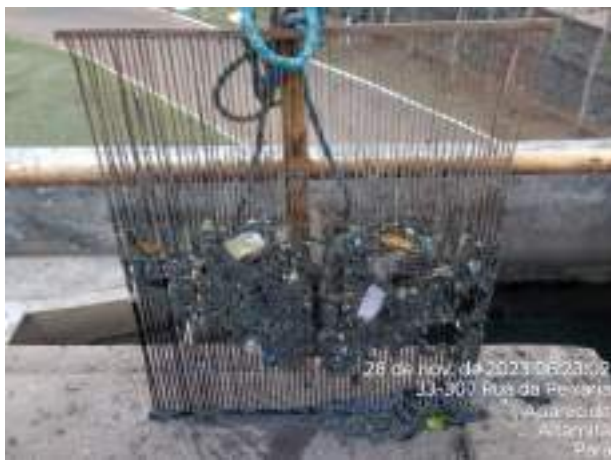
LIMPEZA DAS GRADES DE ENTRADA DO ESGOTO BRUTO
