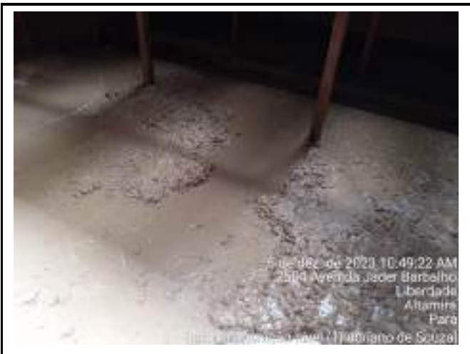
LIMPEZA DO FUNDO DOS CANTADORES ETA CONVENCIONAL
