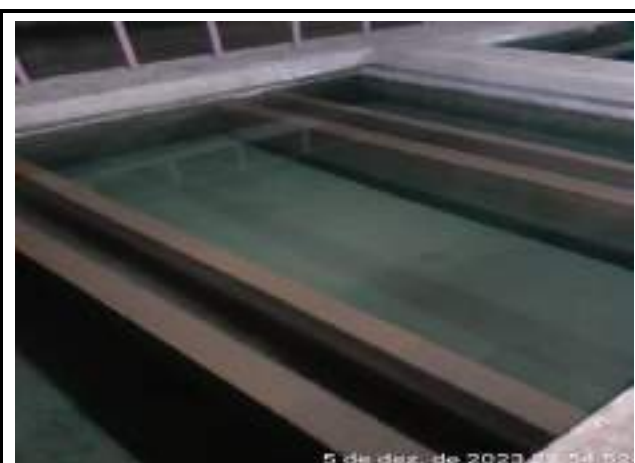
RETROLAVAGEM DOS FILTROS DE CONCRETO DA ETA CONVENCIONAL
