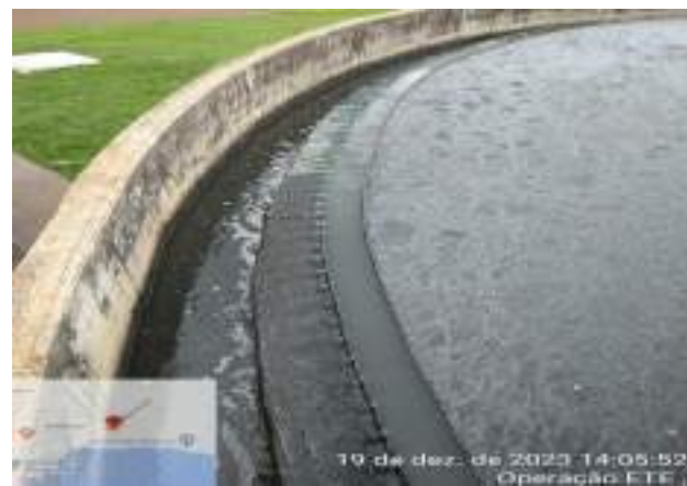
LIMPEZA DAS BORDAS DOS TANQUES DECANTADORES
