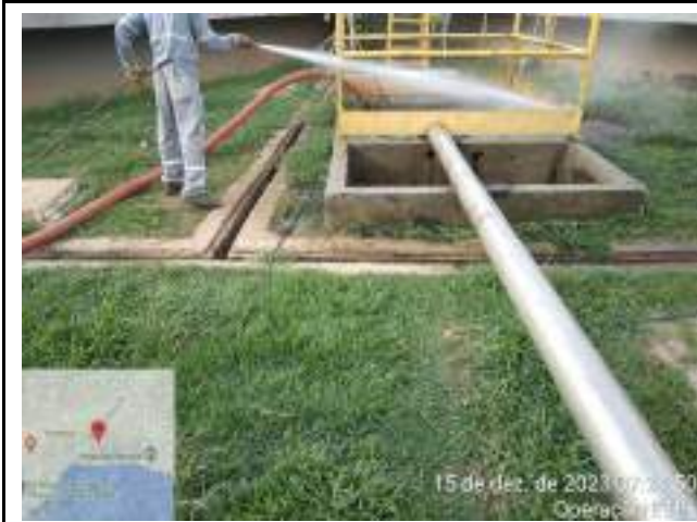
LAVAGEM DA CAIXA DE ESPUMA
