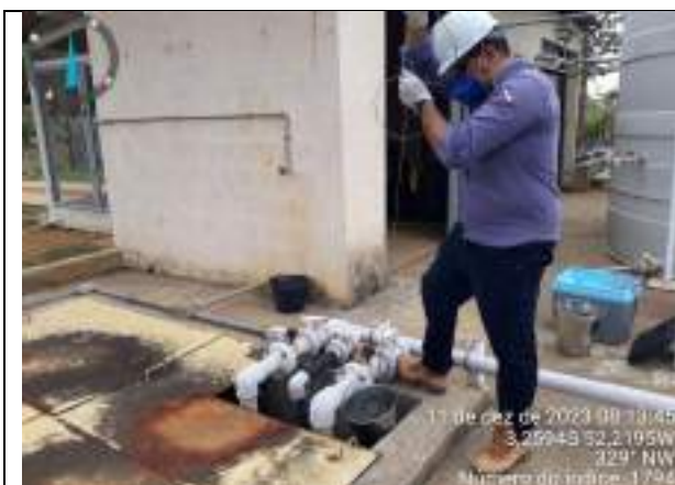
Foto 1: Ponto de coleta – entrada do efluente bruto
