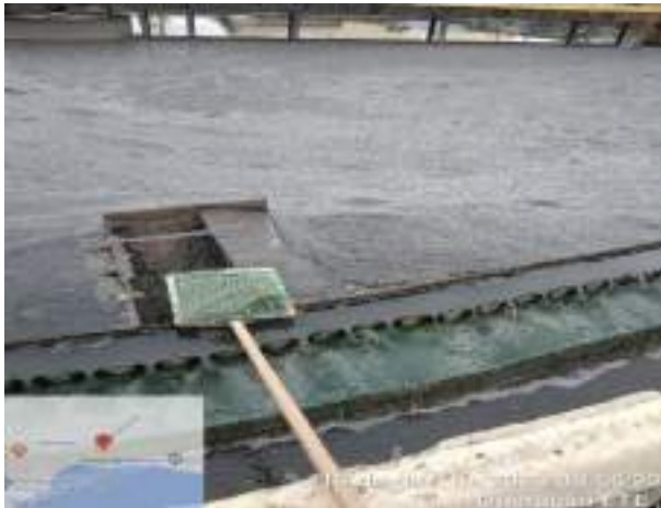
RETIRADA DE SOBRENADANTES DOS TANQUES DECANTADORES SECUNDÁRIOS
