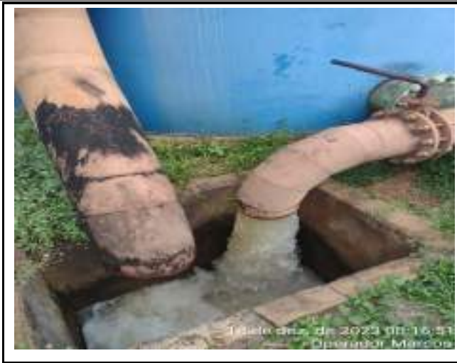
RETROLAVAGEM DOS FILTROS DE METAL DA ETA CONVENCIONAL - VETA
