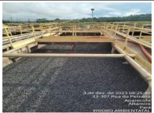
TANQUE AERADO LIMHA B ESTA COM O FINAL OBSTRUÍDO IMPOSSIBILITANDO A PASSAGEM DO EFLUENTE, FOI INSTADO A BOMBA EJ40 PARA DIMINUIR O VOLUME DE ÁGUA.
