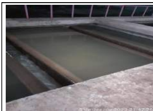
RETROLAVAGEM DOS FILTROS DE CONCRETO DA ETA CONVENCIONAL
