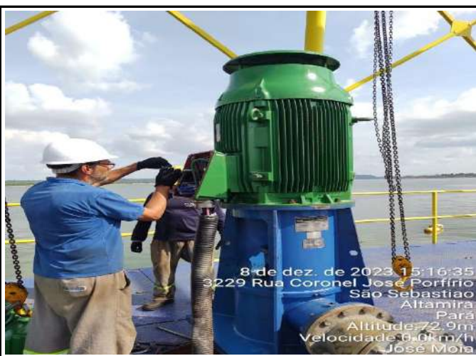
MANUTENÇÃO DA BOMBA 04 DA CAPTAÇÃO
