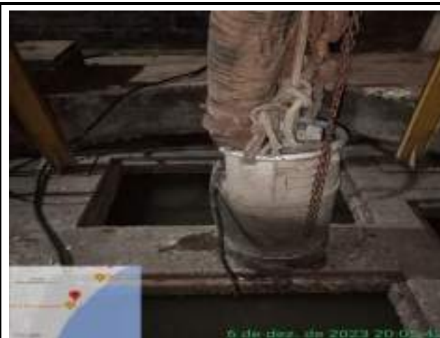
SUCÇÃO DO ESGOTO DA EEE IBAMA E LIMPEZA DA BOMBA
