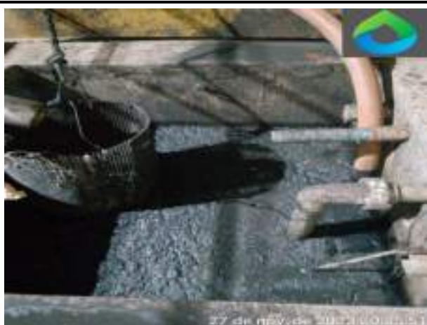
SUCÇÃO DA CAIXA DE ESPUMA
