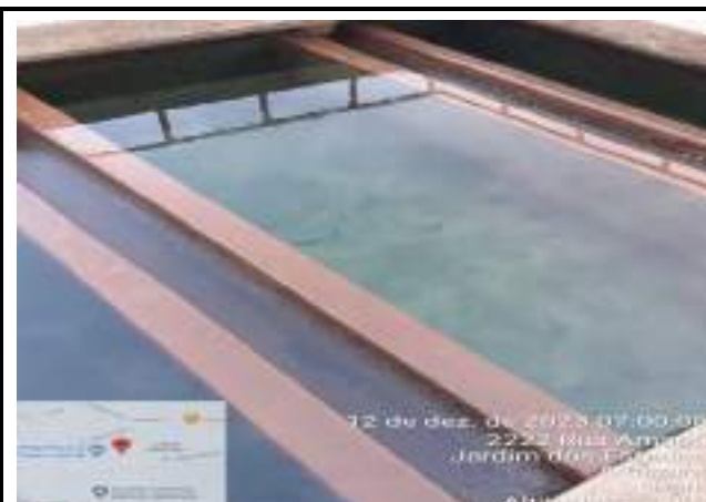
RETROLAVEGEM DOS FILTROS DE METAL ETA CONVENCIONAL
