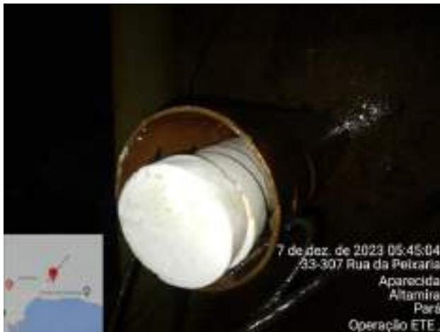
ADIÇÃO DE PASTILHA DE CLORO EMISSÁRIO FINAL
