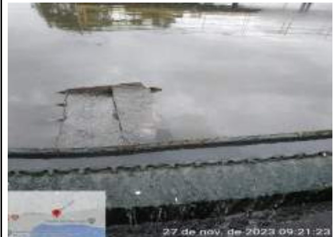
RETIRADA DE SOBRENADANTES DOS TANQUES DECANTADORES SECUNDÁRIOS
