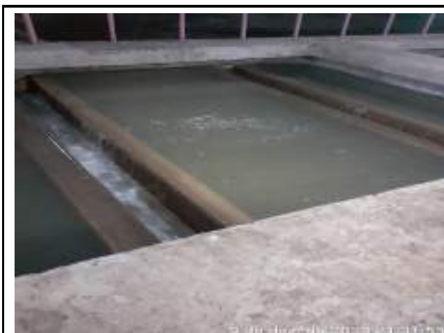
RETROLAVAGEM DOS FILTROS DE CONCRETO ETA CONVENCIONAL
