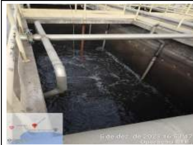
SECAGEM DO TANQUE AERADO PARA MANUTENÇÃO DO TUBO DE AR.
