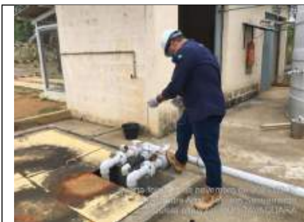
Foto 1: Ponto de coleta – entrada do efluente bruto
