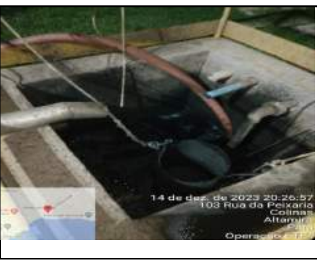
FOI INSTALADO A BOMBA EJ40 PARA RETIRADA DE MATERIAL DO TANQUE TERCIÁRIO LINHA A PARA O TANQUE TERCIÁRIO LINHA B.
