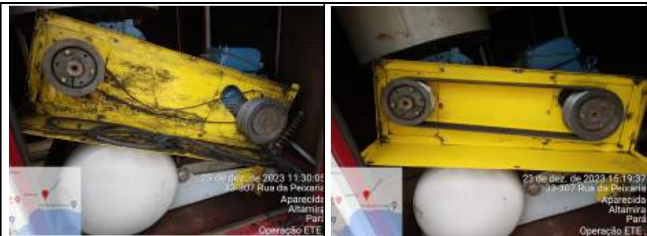
DESMONTAGEM SOPRADOR 1 PARA TROCA DE CORREIAS.
