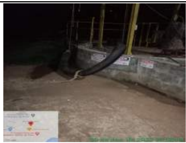
SUCÇÃO DO ESGOTO NA EEE SUPER PÃO
