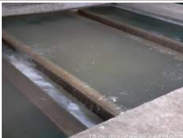
RETROLAVAGEM DOS FILTROS DE CONCRETO ETA CONVENCIONAL
