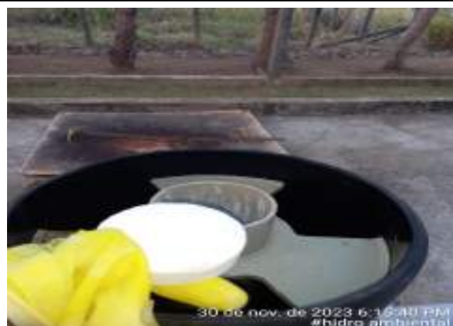
MONITORAMENTO DO EMISSÁRIO FINAL E ADIÇÃO DE PASTILHA D CLORO
