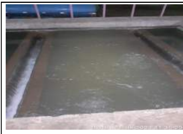
LAVAGEM DOS FILTROS DE CONCRETO ETA CONVENCIONAL
