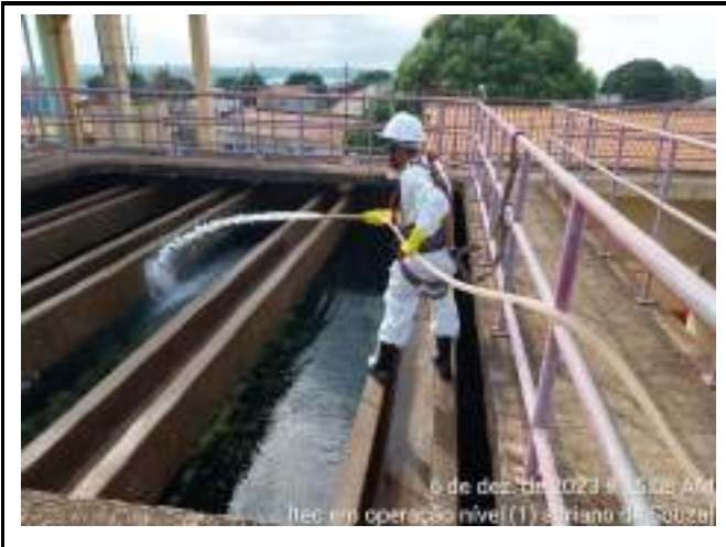
LIMPEZA DAS COLMEIAS DOS CANTADORES ETA CONVENCIONAL
