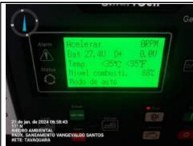
NÍVEL DO ÓLEO DO GERADOR FINAL DO TURNO
