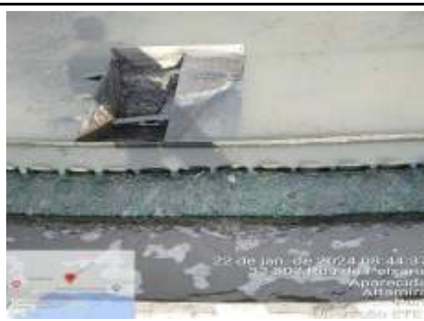
RETIRADA DE SOBRENADANTES DOS TANQUES DECANTADORES SECUNDÁRIOS
