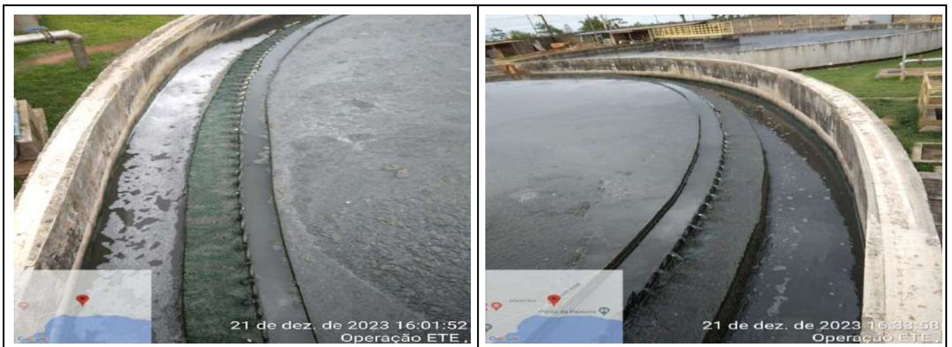
LIMPEZA DAS BORDAS DOS TANQUES DECANTADORES DAS LINHAS A E B
