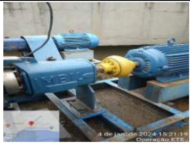
FOI FINALIZADO A LIMPEZA, E FEITA A MONTAGEM DA BOMBA DE RECIRCULAÇÃO DA LINHA B.
