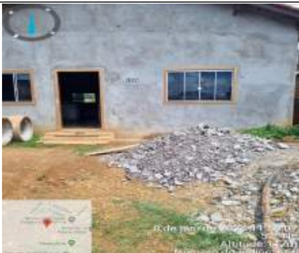
Figura 12: TRAVESSA JULIO MARQUES, 1256
