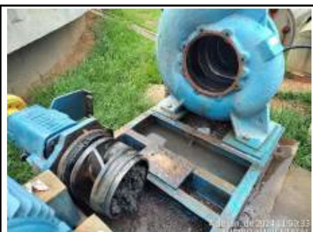
DESMONTAGEM DA BOMBA DE RECIRCULAÇÃO DA LINHA B PARA LIMPEZA E VERIFICAÇÃO
