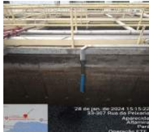
MANUTENÇÃO PROVISÓRIA NO TANQUE AERADO DA LINHA B PARA TRANSPOSIÇÃO DE MÍDIAS E OXIGENAÇÃO DO TANQUE PRIMÁRIO
