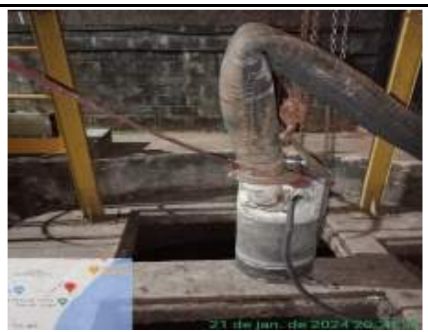
SUCÇÃO DE ESGOTO NA EEE IBAMA E LIMPEZA DA BOMBA
