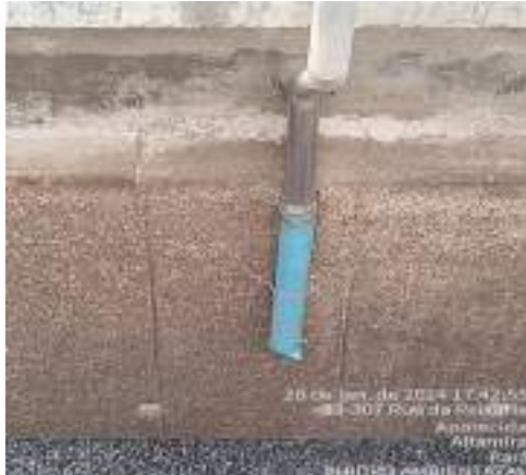
MANUTENÇÃO PROVISÓRIA NO TANQUE AERADO DA LINHA B PARA TRANSPOSIÇÃO DE MÍDIAS E OXIGENAÇÃO DO TANQUE PRIMÁRIO
