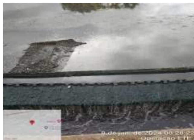
RETIRADA DE SOBRENADANTES DOS TANQUES DECANTADORES SECUNDÁRIOS
