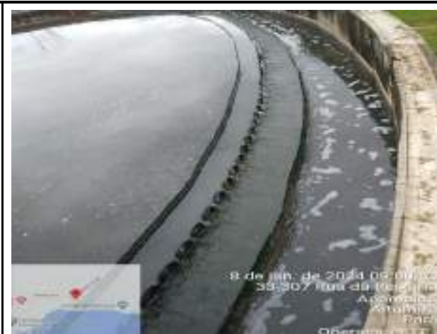
LIMPEZA DAS BORDAS DOS TANQUES DECANTADORES
