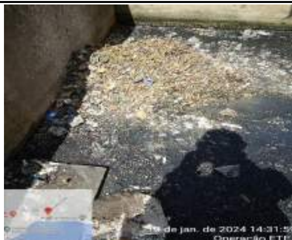
LIMPEZA DOS RESÍDUOS SÓLIDOS DA CAIXA DOS KOMBIS
