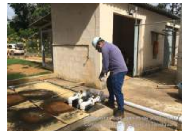
Foto 1: Ponto de coleta – entrada do efluente bruto
