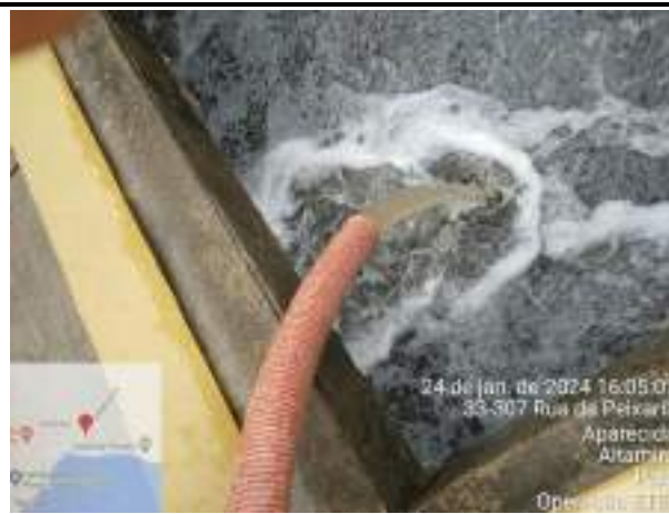
INSTALAÇÃO DA BOMBA EJ40 PARA SECAGEM DO TAMQUE AERADO LINHA B
