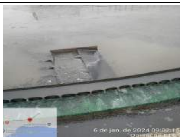
RETIRADA DE SOBRENADANTES DOS TANQUES DECANTADORES SECUNDÁRIOS
