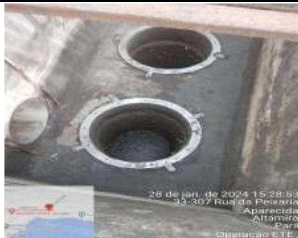
LAVAGEM E LIMPEZA DOS CESTOS DO TANQUE AERADO DA LINHA B.
