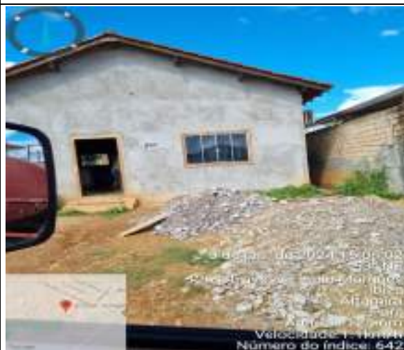
Figura 12: TRAVESSA JULIO MARQUES, 1256
