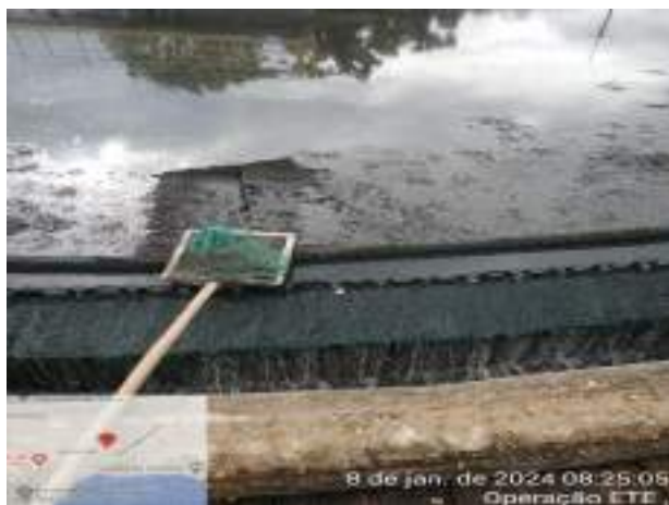
RETIRADA DE SOBRENADANTES DOS TANQUES DECANTADORES SECUNDÁRIOS
