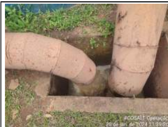
DESCARGA DE FUNDO NO FILTRO DE METAL 03 DA VETA
