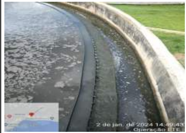
LIMPEZA DAS BORDAS DOS TANQUES DECANTADORES
