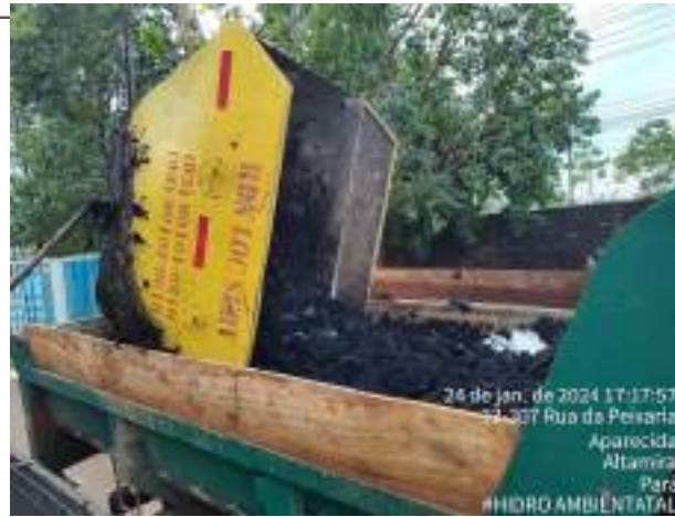
CENTRIFUGADO 16 M 3 DE LODO
