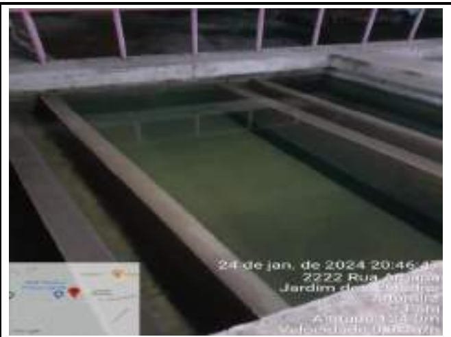
RETROLAVAGEM DOS FILTROS DE CONCRETO ETA CONVENCIONAL
