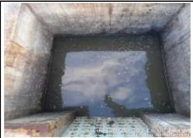
LIMPEZA DAS CAIXAS E DAS GRADES DE ENTRADA DO ESGOTO BRUTO
