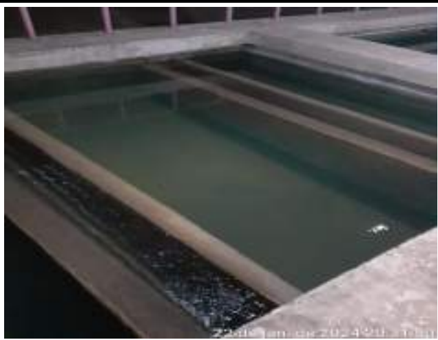
RETROLAVAGEM DOS FILTROS DE CONCRETO ETA CONVENCIONAL
