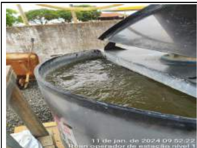
ABASTECIMENTO DA TINA DE BARRILHA
