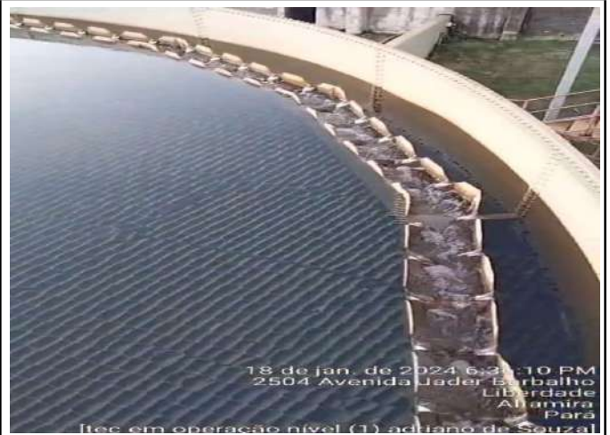
MONITORAMENTO DE DECANTADORES DA ETA MODULAR
