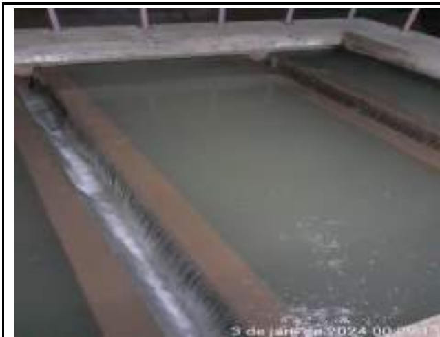
RETROLAVAGEM DOS FILTROS DE CONCRETO ETA CONVENCIONAL
