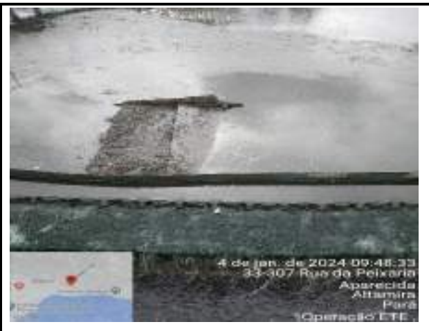
RETIRADA DE SOBRENADANTES DOS TANQUES DECANTADORES SECUNDÁRIOS
