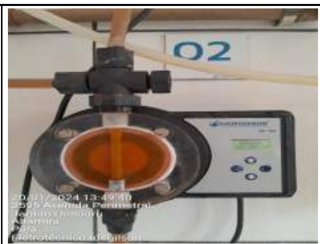
FEITO RESET NA BOMBA DOSADORA DE PAC B02, E NA OCASIÃO FOI FEITO A LIMPEZA DA MESMA
