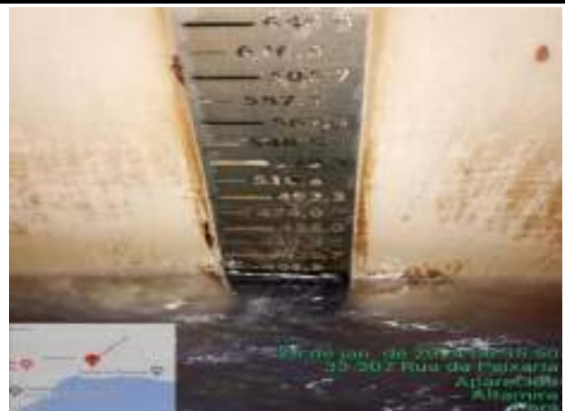
MONITORAMENTO DA VASÃO LINHA B
