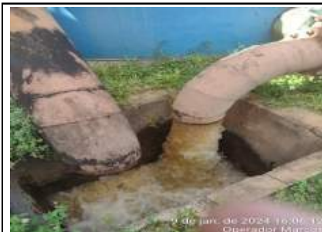
RETROLAVAGEM DOS FILTROS DE METAL 02 e 04 DA VETA
