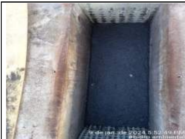
LIMPEZA DAS CAIXAS E DAS GRADES DE ENTRADA DO ESGOTO BRUTO
