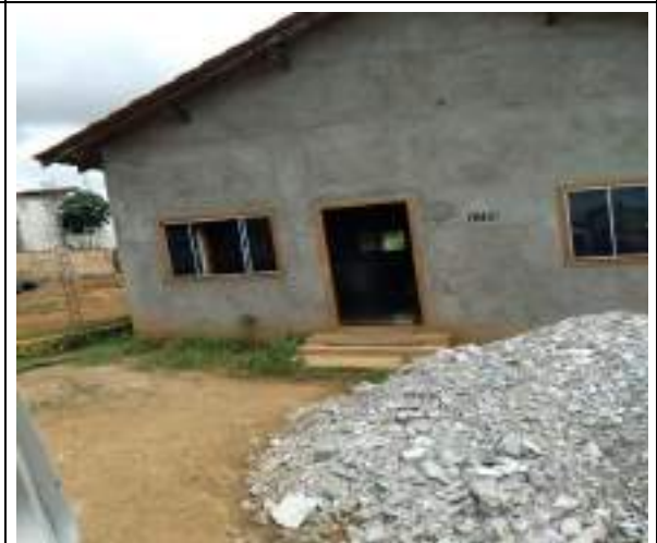
Figura 12: TRAVESSA JULIO MARQUES, 1256
