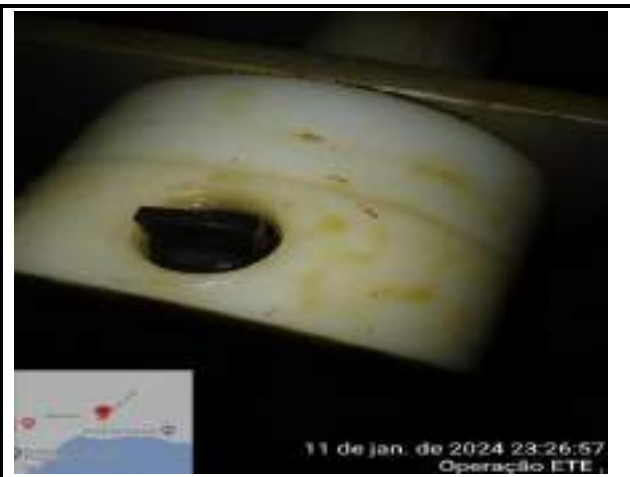
FOI FEITA A TROCA DA BORRACHA DA DOSADORA QUE ESTAVA DANIFICADA
