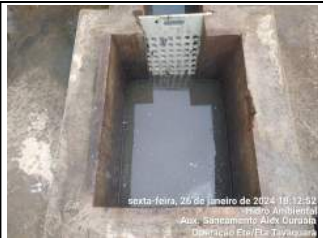
LIMPEZA DA CAIXA E DAS GRADES DE ENTRADA DO ESGOTO BRUTO
