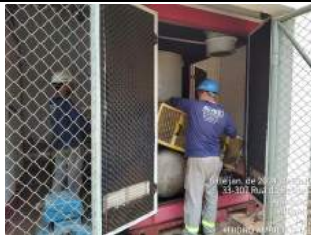
DESMONTAGEM DO SOPRADOR 3 PARA MANUTENÇÃO E LIMPEZA
