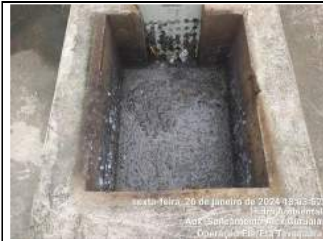
LIMPEZA DA CAIXA E DAS GRADES DE ENTRADA DO ESGOTO BRUTO
