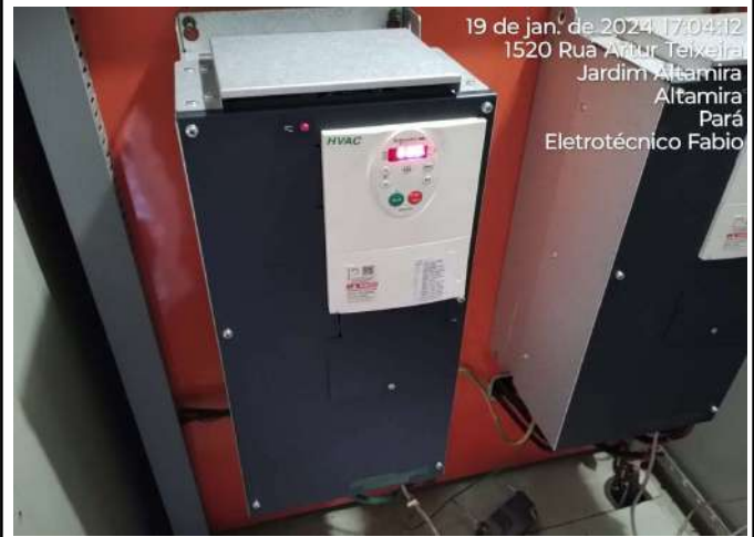
INSTALAÇÃO DE INVERSOR DE FREQUÊNCIA NO PAINEL ELÉTRICO DO RAP BRASÍLIA
