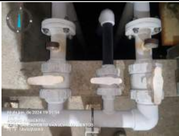
TROCA DE REGISTRO
