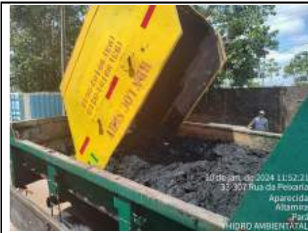
FOI CENTRIFUGADO 16 M 3 DE LODO E DEPOIS ENVIADO PRA O ATERRO SANITÁRIO
