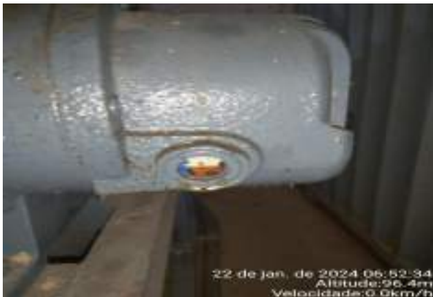
MONITORAMENTO DO VÍVEL DO ÓLEO DO SOPRADOR
