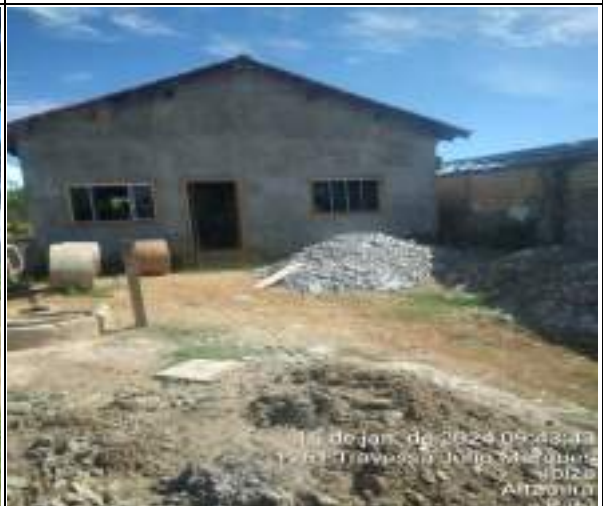
Figura 12: TRAVESSA JULIO MARQUES, 1256
