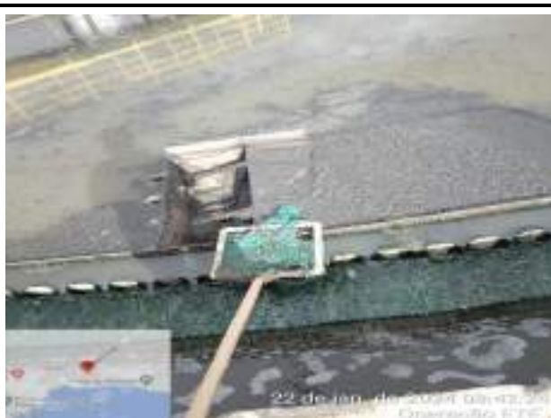
RETIRADA DE SOBRENADANTES DOS TANQUES DECANTADORES SECUNDÁRIOS
