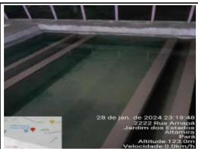
RETROLAVAGEM DOS FILTROS DE CONCRETO ETA CONVENCIONAL
