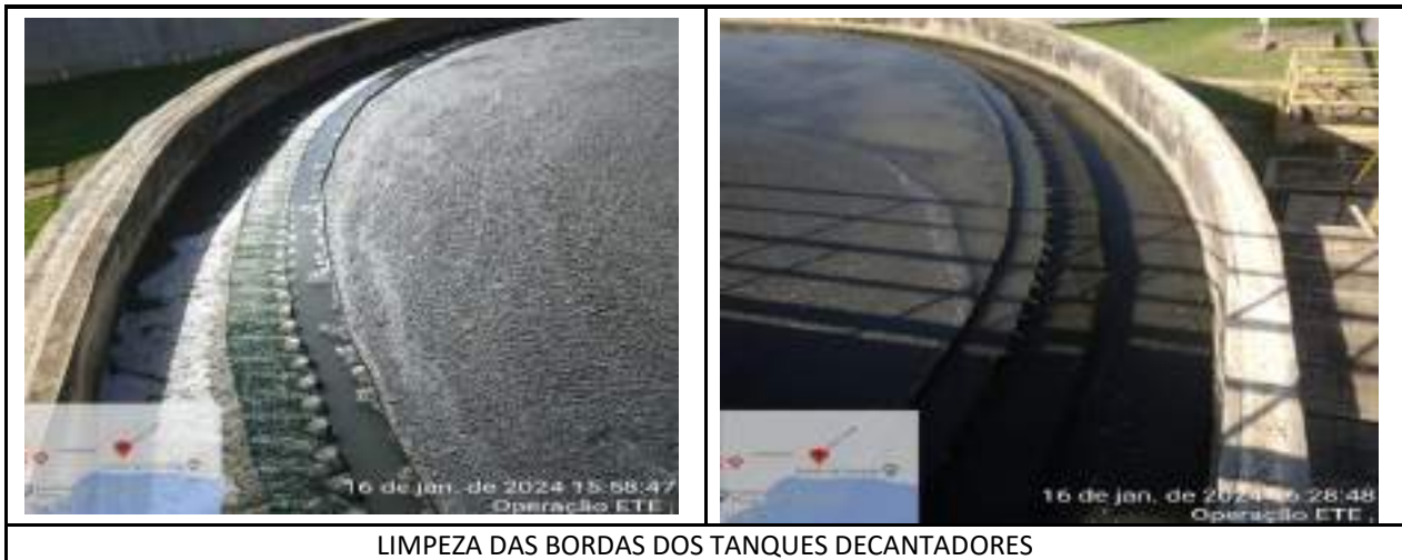
RETIRADA DE SOBRENADANTES DOS TANQUES DECANTADORES SECUNDÁRIOS
