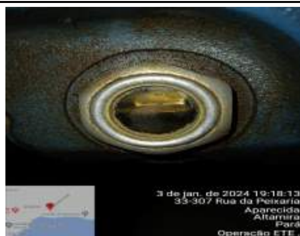
VERIFICAÇÃO DO NÍVEL DO ÓLEO DO SOPRADOR
