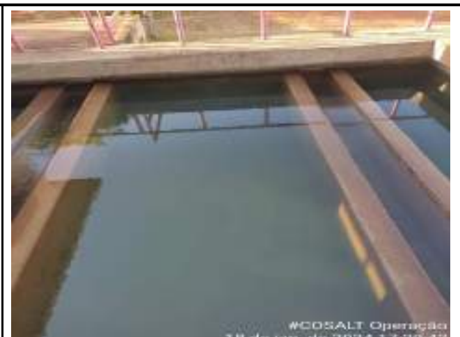
RETROLAVAGEM DOS FILTROS DE CONCRETO ETA CONVENCIONAL
