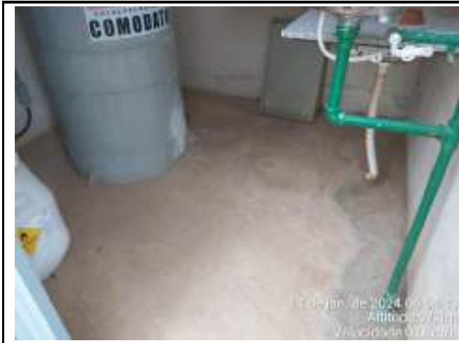
LIMPEZA DA SALA DOS QUÍMICOS
