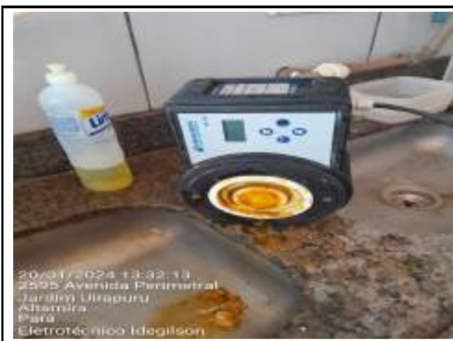
FEITO RESET NA BOMBA DOSADORA DE PAC B02, E NA OCASIÃO FOI FEITO A LIMPEZA DA MESMA
