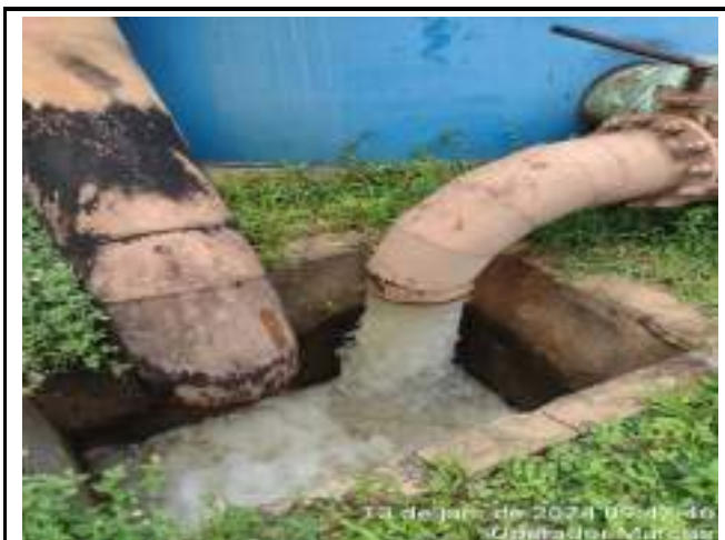
RETROLAVAGEM DOS FILTROS DE METAL ETA CONVENCIONAL
