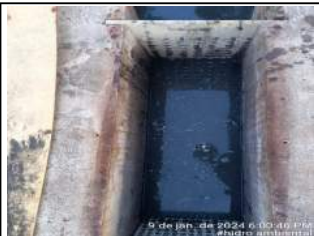
LIMPEZA DAS CAIXAS E DAS GRADES DE ENTRADA DO ESGOTO BRUTO
