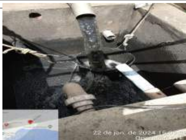
LIMPEZA DO TERCIÁRIO DA LINHA A
