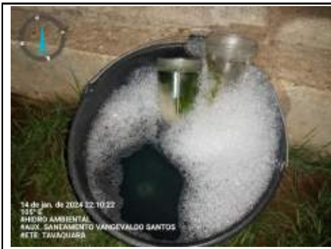
LIMPEZA DOS ROTÂMETROS
