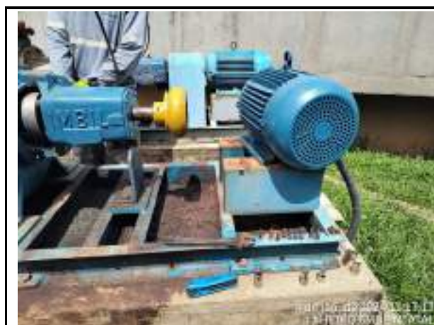
DESMONTAGEM DA BOMBA DE RECIRCULAÇÃO DA LINHA B PARA LIMPEZA E VERIFICAÇÃO
