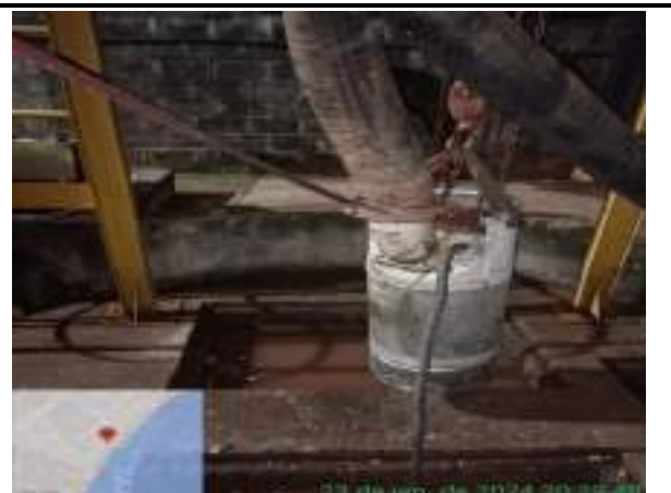
FOI FEITA A SUCÇÃO DE ESGOTO NA EEE IBAMA E LIMPEZA DA BOMBA
