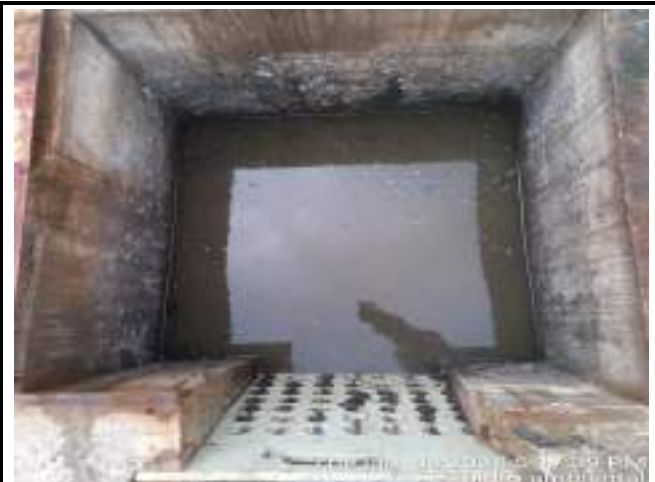
LIMPEZA DA GRADES E RETIRADA DE SOBRE NADANTES
