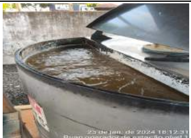
ABASTECIMENTO DA TINA DE BARRILHA
