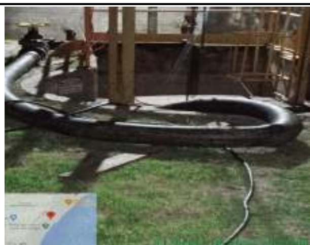
SUCÇÃO DE ESGOTO NA EEE IBAMA E LIMPEZA DA BOMBA
