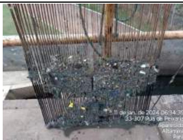
LIMPEZA DAS GRADES DE ENTRADA DO ESGOTO BRUTO
