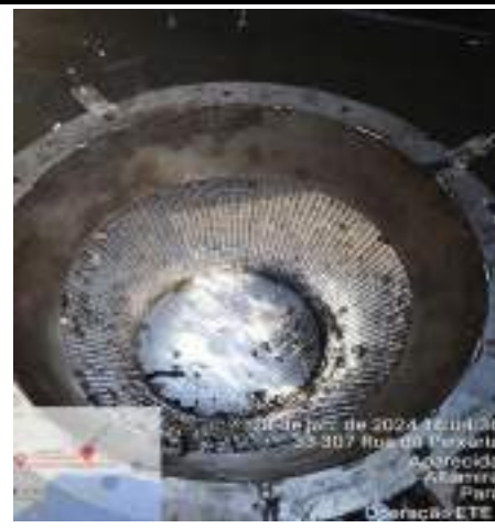
LAVAGEM E LIMPEZA DOS CESTOS DO TANQUE AERADO DA LINHA B.
