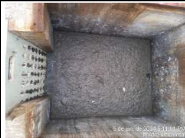
LIMPEZA DA GRADES E RETIRADA DE SOBRE NADANTES
