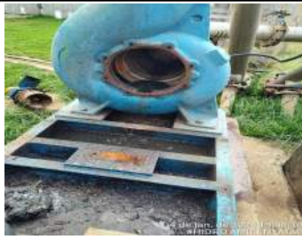
FOI FINALIZADO A LIMPEZA, E FEITA A MONTAGEM DA BOMBA DE RECIRCULAÇÃO DA LINHA B.
