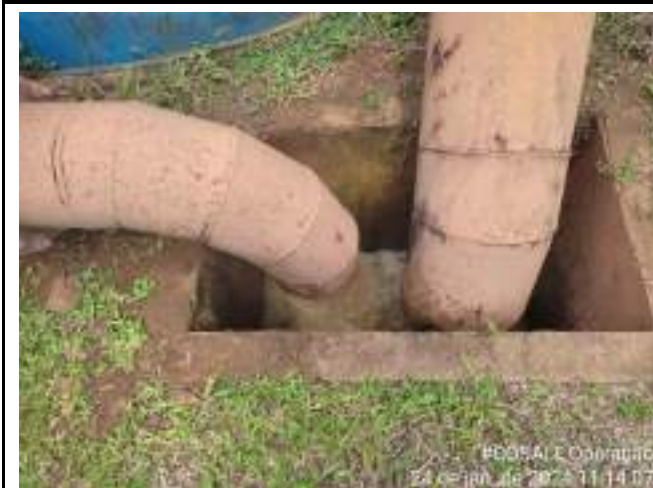
DESCARGA DE FUNDO NO FILTRO DE METAL 01 DA VETA
