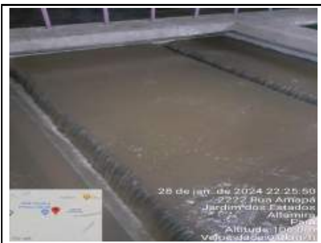
RETROLAVAGEM DOS FILTROS DE CONCRETO ETA CONVENCIONAL
