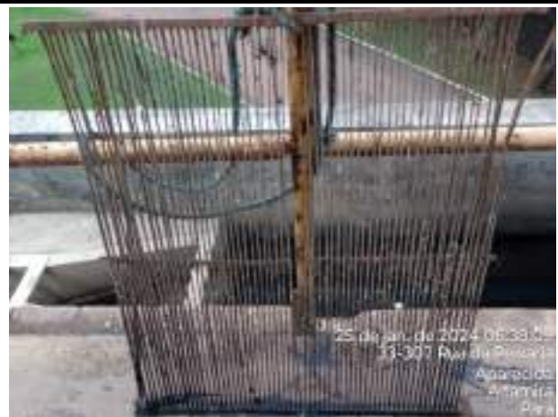
LIMPEZA DAS GARDES DE ENTRADA DO ESGOTO BRUTO
