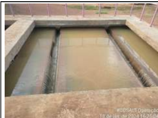
RETROLAVAGEM DOS FILTROS DE CONCRETO ETA CONVENCIONAL
