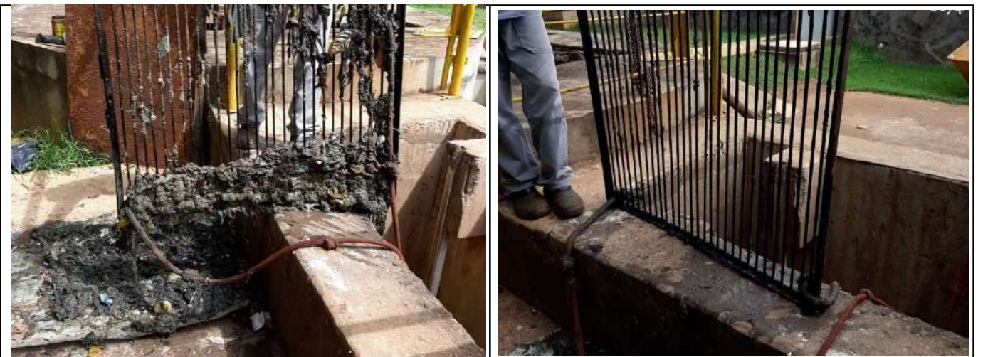
LIMPEZA DE GRADE DA EEE APARECIDA
