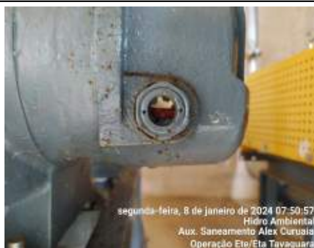
VERIFICAÇÃO DO ÓLEO DO SOPRADOR
