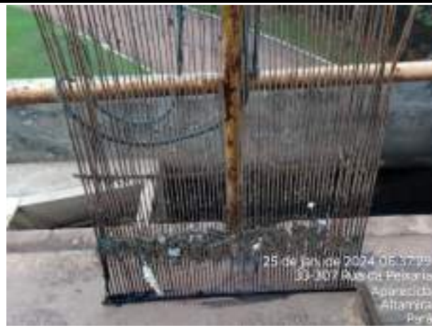
LIMPEZA DAS GARDES DE ENTRADA DO ESGOTO BRUTO
