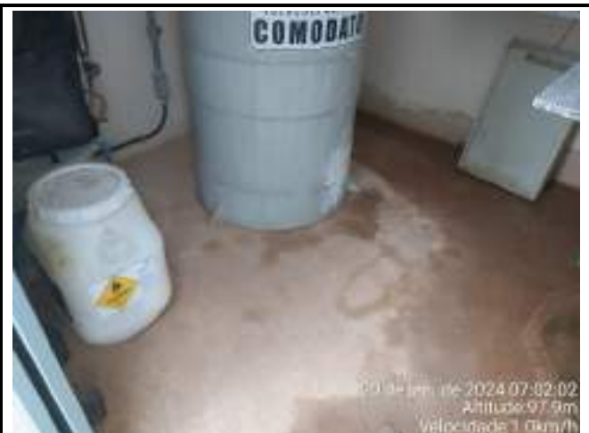
LIMPEZA DA SALA DOS QUÍMICOS
