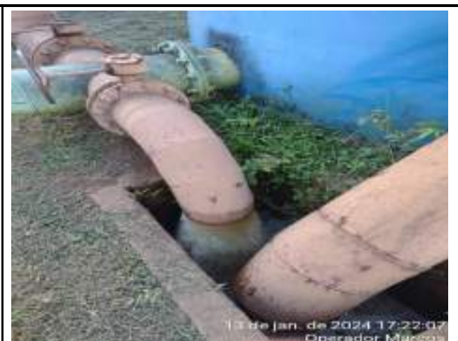
RETROLAVAGEM DOS FILTROS DE METAL ETA CONVENCIONAL
