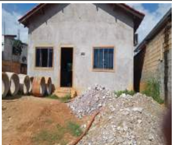
Figura 12: TRAVESSA JULIO MARQUES, 1256
