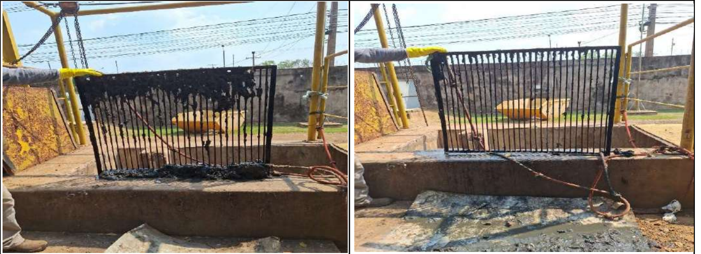
LIMPEZA DOS CESTOS DAS ELEVATÓRIAS
