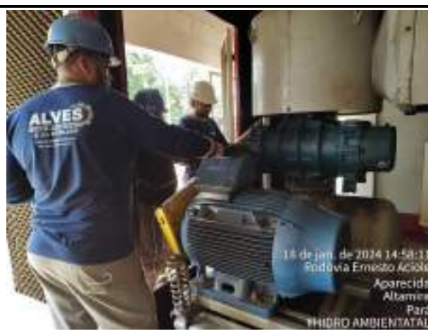
ALINHAMENTO DO SOPRADOR 3, E MONTAGEM DAS CORREIAS PELA EQUIPE DA ALVES.
