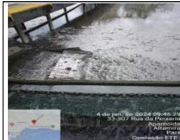
RETIRADA DE SOBRENADANTES DOS TANQUES DECANTADORES SECUNDÁRIOS
