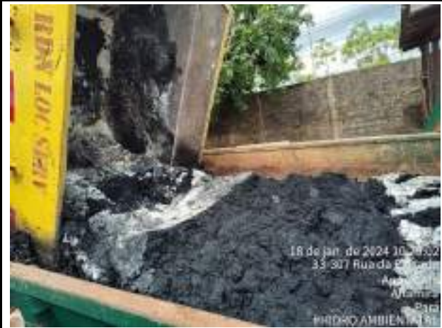
FOI CENTRIFUGADO 16 M 3 DE LODO
