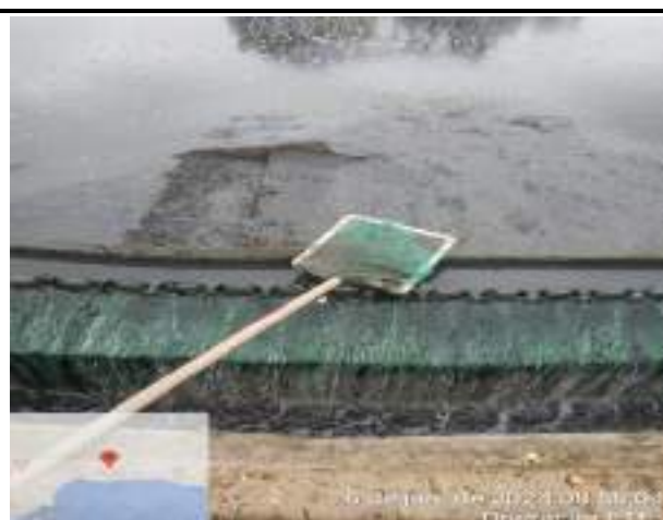
RETIRADA DE SOBRENADANTES DOS TANQUES DECANTADORES SECUNDÁRIOS
