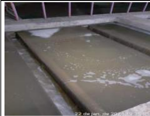
RETROLAVAGEM DOS FILTROS DE CONCRETO ETA CONVENCIONAL
