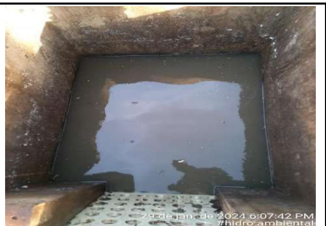
LIMPEZA DA CAIXA E DAS GRADES DE ENTRADA DO ESGOTO BRUTO
