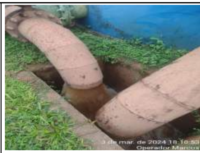
DESCARGA DE FUNDO DOS FILTROS DE METAL ETA CONVENCIONAL
