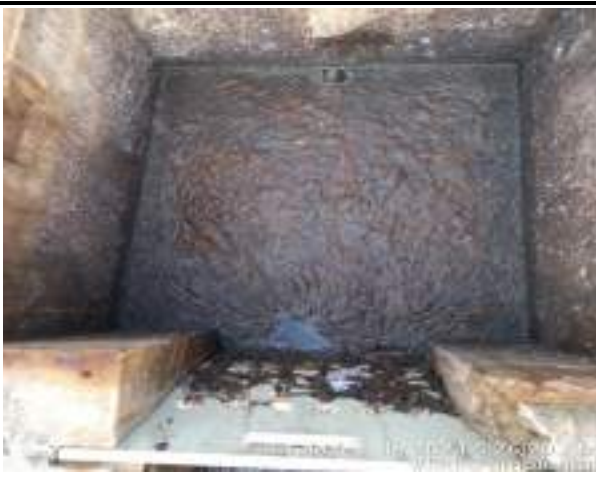
LIMPEZA DA CAIXA E DAS GRADES DE ENTRADA DO ESGOTO BRUTO
