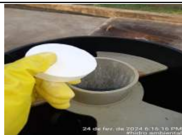
ADIÇÃO DE PASTILHA DE CLORO EMISSÁRIO FINAL
