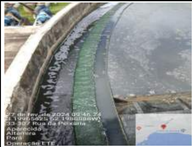
LIMPEZA DAS BORDAS DOS TANQUES DECANTADORES
