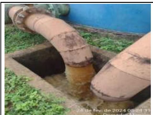
DESCARGA DE FUNDO DOS FILTROS DE METAL 2 e 3- VETA
