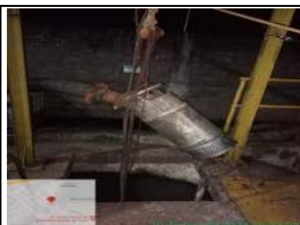
FOI FEITA A SUCCÃO DA EEE SUPER PÃO E LIMPEZA DA BOMBA
