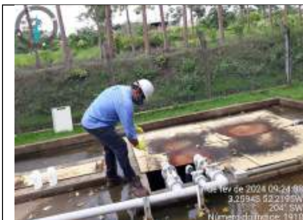
Foto 1: Ponto de coleta – entrada do efluente bruto
