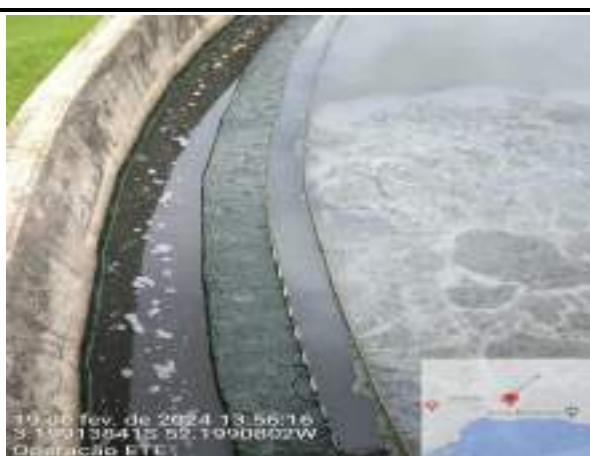
LIMPEZA DAS BORDAS DOS TANQUES DECANTADORES
