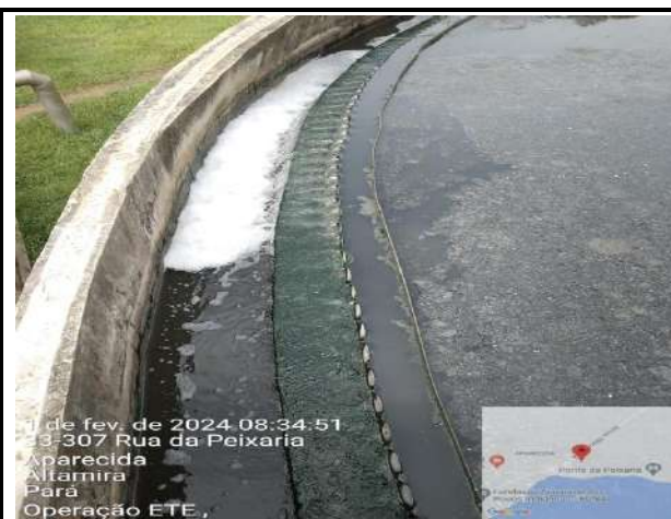
LIMPEZA DAS BORDAS DOS TANQUES DECANTADORES
