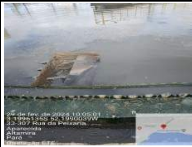
RETIRADA DE SOBRENADANTES DOS TANQUES DECANTADORES SECUNDÁRIOS
