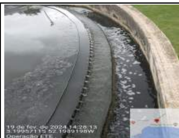
LIMPEZA DAS BORDAS DOS TANQUES DECANTADORES
