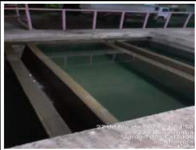
RETROLAVAGEM DOS FILTROS DE CONCRETO ETA CONVENCIONAL
