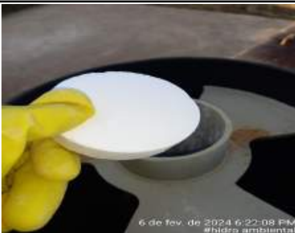
ADIÇÃO DE PASTILHA DE CLORO EMISSÁRIO FINAL
