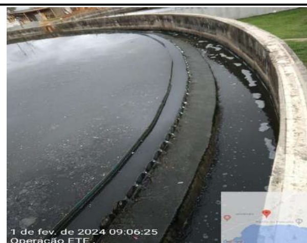
LIMPEZA DAS BORDAS DOS TANQUES DECANTADORES
