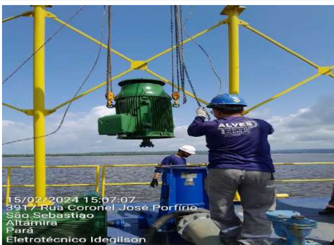
RETIRADA DO MOTOR DA BOMBA 04 DA CAPTAÇÃO FLUTUANTE PARA MANUTENÇÃO
