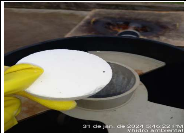
ADIÇÃO DE PASTILHA DE CLORO EMISSÁRIO FINAL
