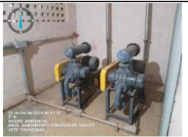
VERIFICAÇÃO E LIMPEZA DA SALA DOS SOPRADORES
