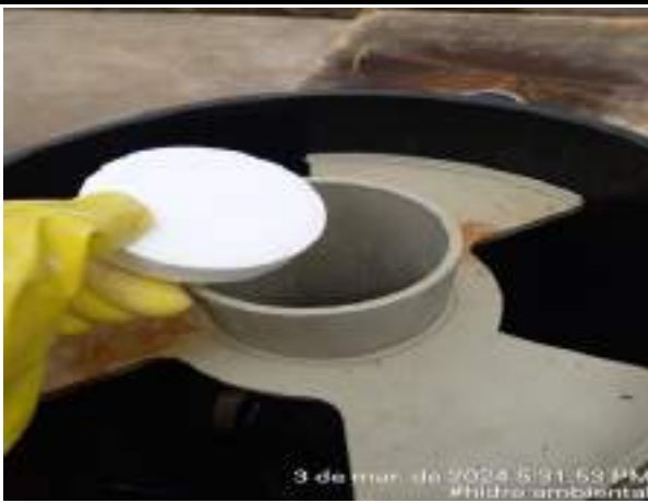
ADIÇÃO DE PASTILHA DE CLORO EMISSÁRIO FINAL
