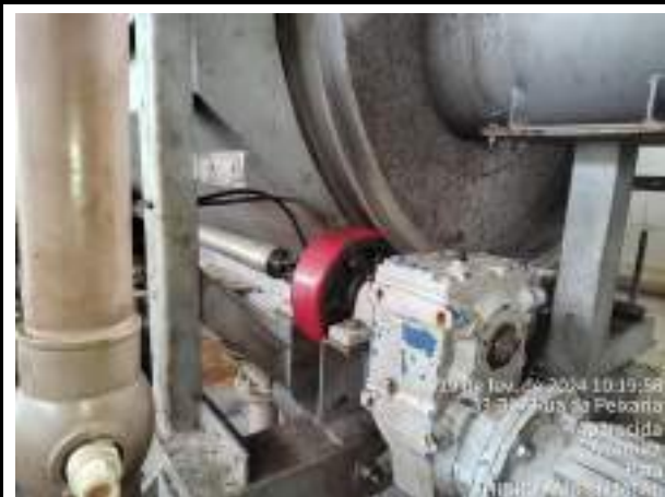
MONTAGEM DA RODA DA PONTE DO ADENSADOR DE LODO 2 DO TANQUE DECANTADOR SECUNDÁRIO LINHA B, E ALINHAMENTO DO MESMA
