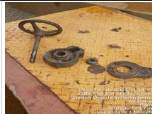
FOI FEITA A TROCA DA CHAVETA DO REGISTRO DE DESCARGA DO DECANTADOR 02 QUE ESTAVA QUEBRADA, O REGISTRO FOI COLOCADO NO LUGAR E ESTA FUNCIONANDO NORMALMENTE
