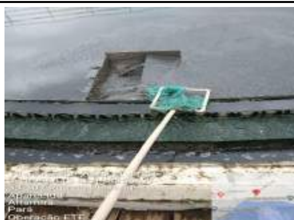
RETIRADA DE SOBRENADANTES DOS TANQUES DECANTADORES SECUNDÁRIOS
