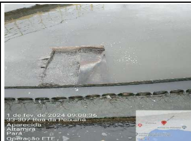
RETIRADA DE SOBRENADANTES DOS TANQUES DECANTADORES SECUNDÁRIOS
