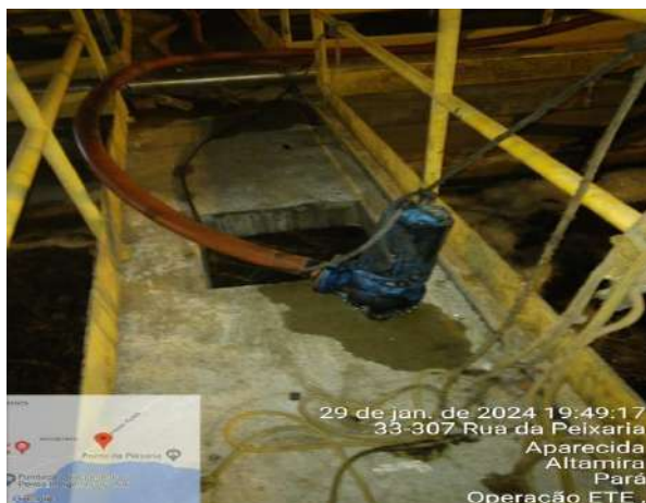
FOI LEVANTADO A BOMBA EJ40 DO TANQUE PRIMÁRIO
