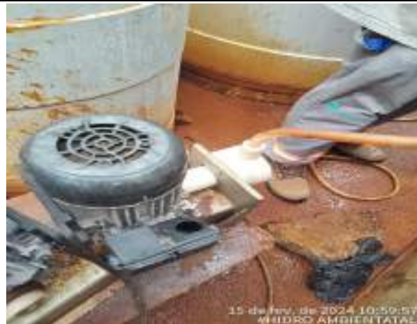
A DOSADORA DE ANTI-ESPUMA ESTÁ COM AVARIA
