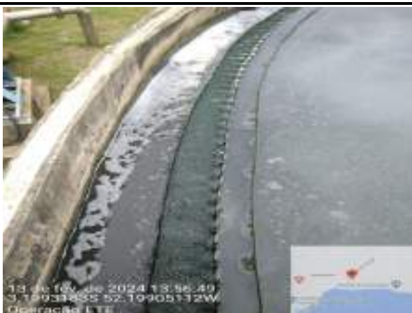
LIMPEZA DAS BORDAS DOS TANQUES DECANTADORES
