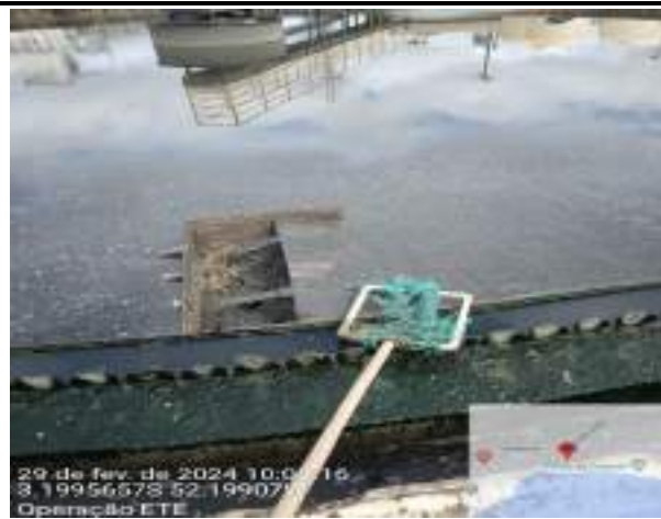
RETIRADA DE SOBRENADANTES DOS TANQUES DECANTADORES SECUNDÁRIOS
