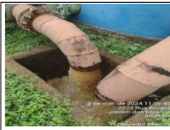
DESCARGA DE FUNDO DOS FILTROS DE METAL ETA CONVENCIONAL
