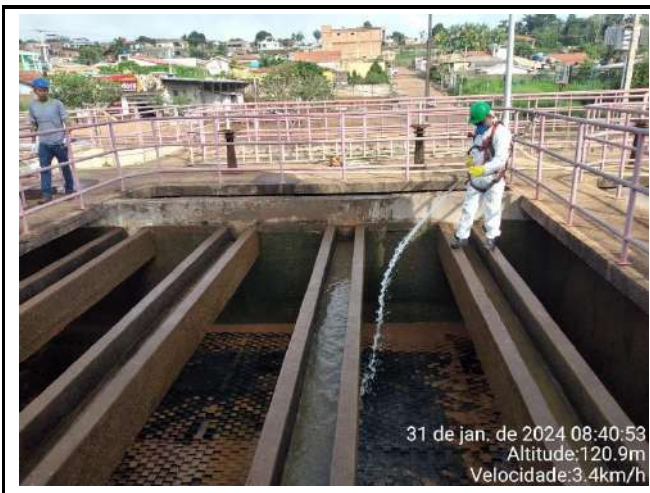
ATIVIDADE DE LIMPEZA E HIGIÊNIZAÇÃO DOS DECANTADORES ETA CONVENCIONAL (COLMÉIA)
