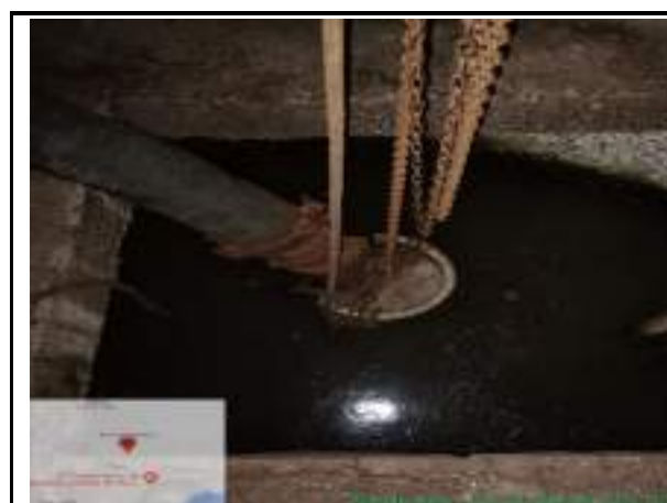
FOI FEITA A SUCCÃO DA EEE SUPER PÃO E LIMPEZA DA BOMBA
