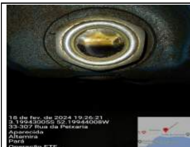
VERIFICAÇÃO DO ÓLEO DO SOPRADOR
