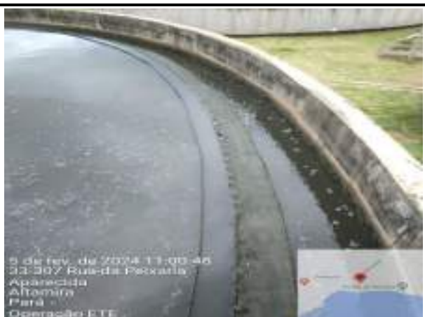
LIMPEZA DAS BORDAS DOS TANQUES DECANTADORES
