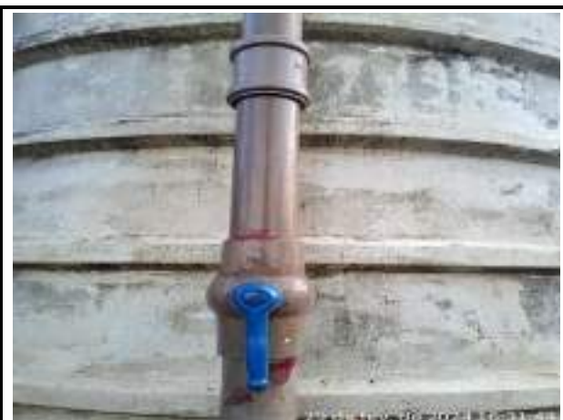
FOI FEITA A TROCA DO REGISTRO DANIFICADO DO CILO DA CENTRÍFUGA
