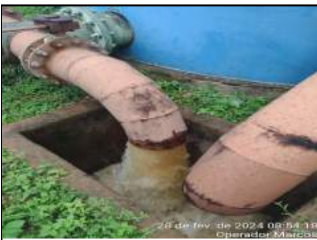
DESCARGA DE FUNDO DO FILTRO DE METAL ETA CONVENCIONAL
