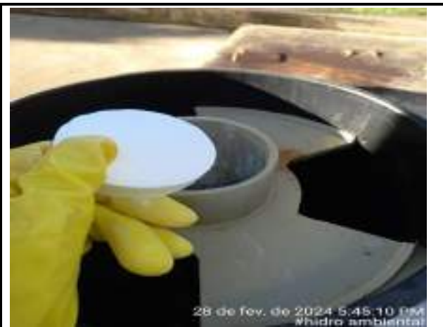
ADIÇÃO DE PASTILHA DE CLORO EMISSÁRIO FINAL
