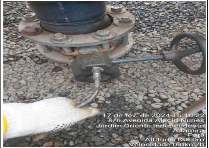
MANUTENÇÃO DO REGISTRO DE DESCARGA DO FILTRO 04
