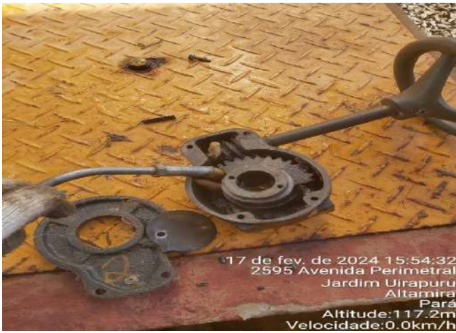
MANUTENÇÃO DO REGISTRO DE DESCARGA DO FILTRO 04
