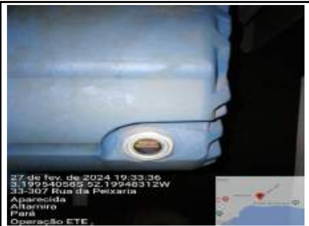
VERIFICAÇÃO DO ÓLEO DO SOPRADOR
