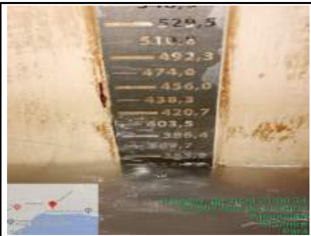
MONITORAMENTO DA VASÃO
