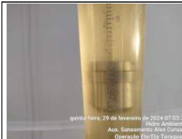
RÉGULAGEM DOS ROTÂMETROS
