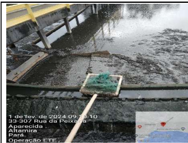
RETIRADA DE SOBRENADANTES DOS TANQUES DECANTADORES SECUNDÁRIOS
