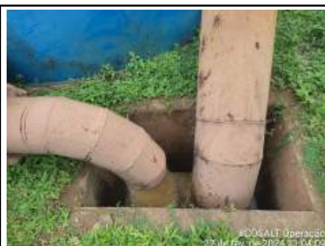
DESCARGA DE FUNDO DO FILTRO DE METAL ETA CONVENCIONAL
