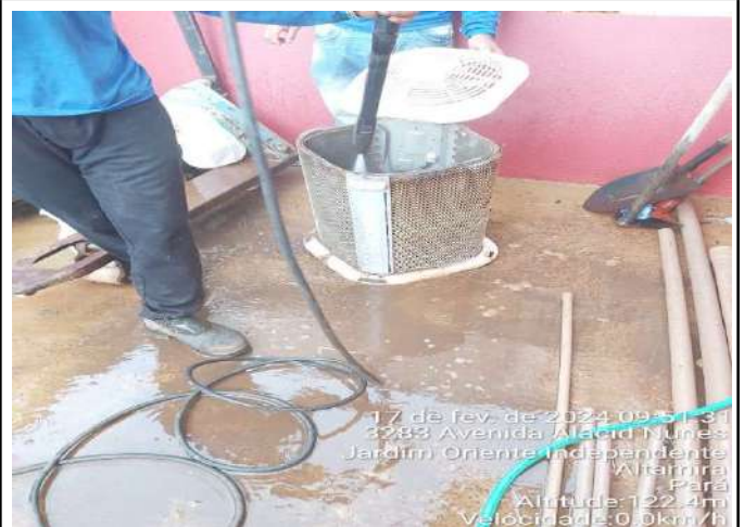
LIMPEZA E MANUTENÇÃO DA CENTRAL DE AR DA SALA DE GERADORES DA ETA MODULAR
