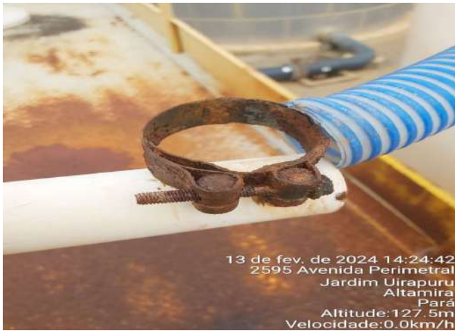
SUBSTITUIÇÃO DE BRAÇADEIRA ENFERRUJADA NA TUBULAÇÃO DE ABASTECIMENTO DO RESERVATÓRIO DE CLORO
