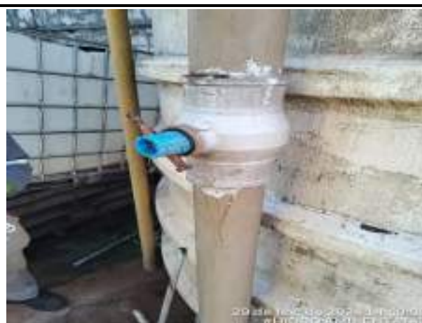
FOI FEITA A TROCA DO REGISTRO DANIFICADO DO CILO DA CENTRÍFUGA
