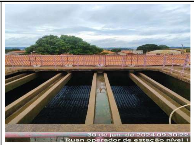
ATIVIDADE DE LIMPEZA E HIGIÊNIZAÇÃO DOS DECANTADORES 02 e 01 ETA CONVENCIONAL
