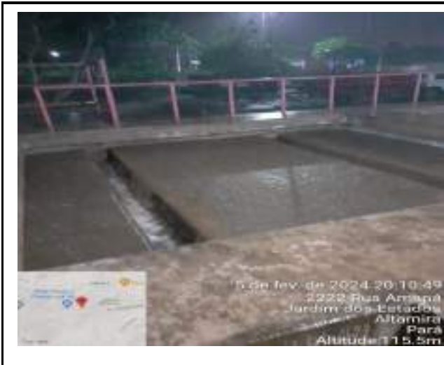
RETROLAVAGEM DOS FILTROS DE CONCRETO ETA CONVENCIONAL
