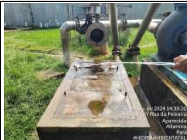
RETIRADA DA BOMBA DE RECIRCULAÇÃO DA LINHA B PARA MANUTENÇÃO E LIMPEZA
