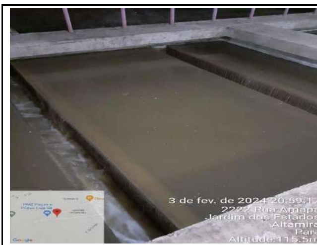
RETROLAVAGEM DOS FILTROS DE CONCRETO DA ETA CONVENCIONAL
