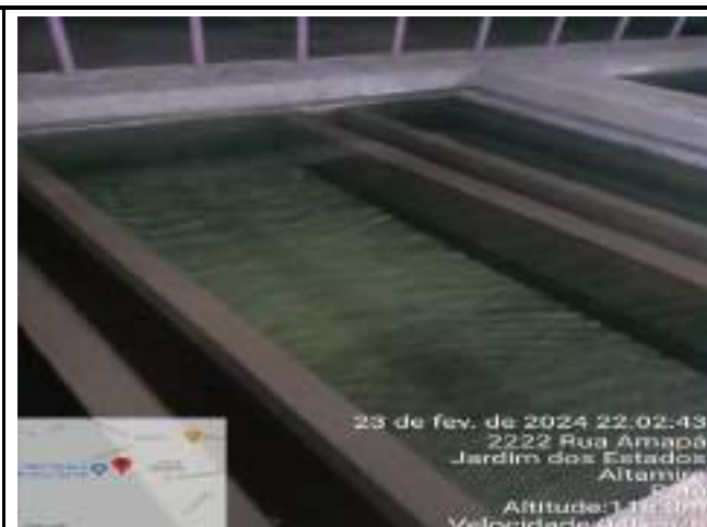
RETROLAVAGEM DOS FILTROS DE METAL DA ETA CONVENCIONAL
