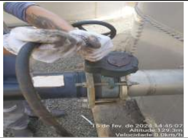
FOI FEITA A TROCA DA CHAVETA DO REGISTRO DE DESCARGA DO DECANTADOR 02 QUE ESTAVA QUEBRADA, O REGISTRO FOI COLOCADO NO LUGAR E ESTA FUNCIONANDO NORMALMENTE
