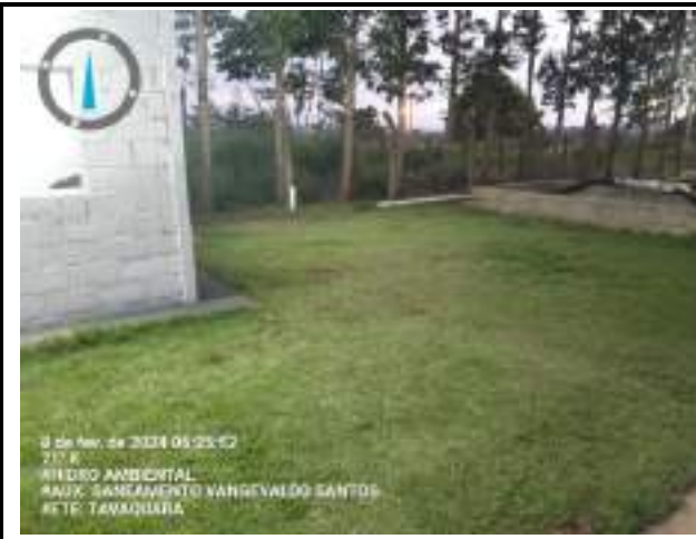
LIMPEZA DO PÁTIO DA ESTAÇÃO
