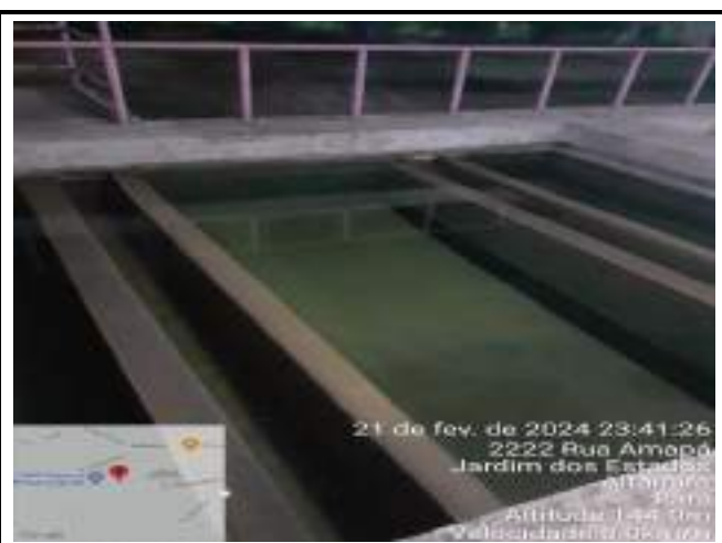
RETROLAVAGEM DOS FILTROS DE CONCRETO ETA CONVENCIONAL
