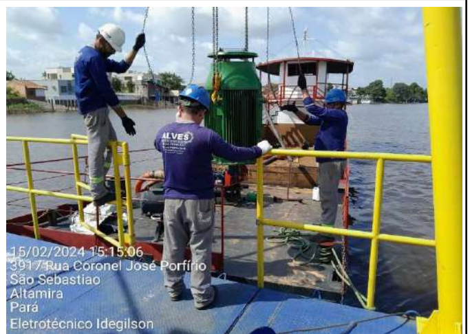
RETIRADA DO MOTOR DA BOMBA 04 DA CAPTAÇÃO FLUTUANTE PARA MANUTENÇÃO
