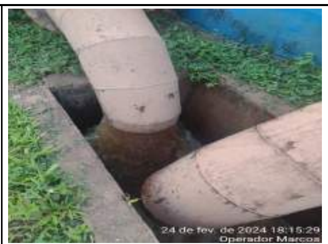
DESCARGA DE FUNDO DOS FILTROS DE METAL 2 e 3- VETA
