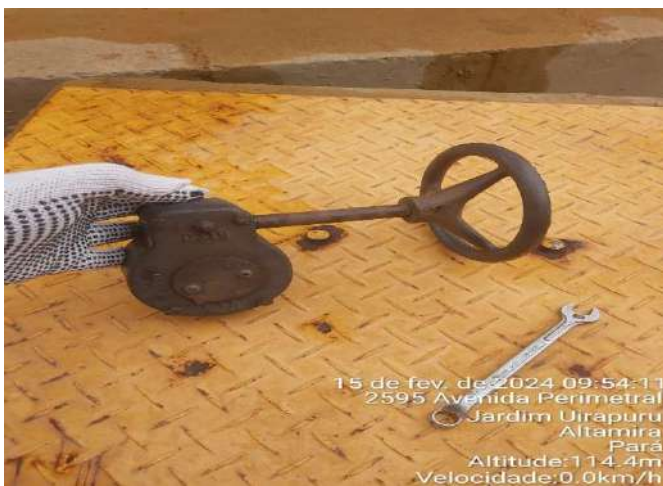
REMOÇÃO DO REGISTRO DE DESCARGA DO DECANTADOR 02 PARA MANUTENÇÃO
