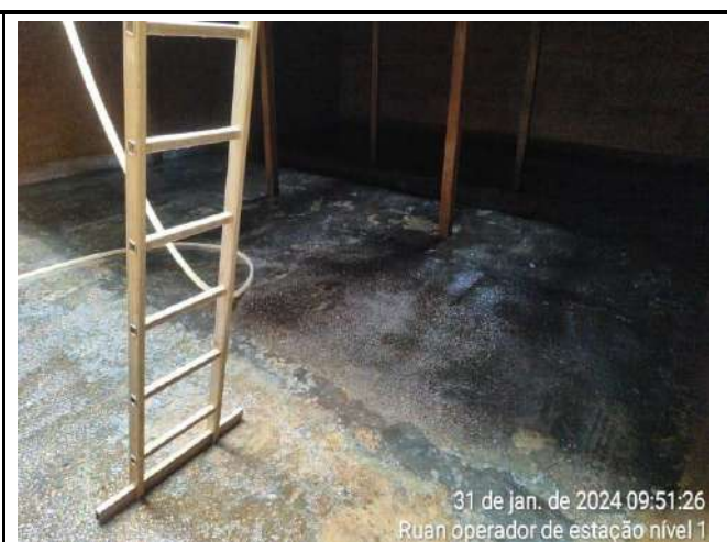
ATIVIDADE DE LIMPEZA E HIGIÊNIZAÇÃO DOS DECANTADORES ETA CONVENCIONAL (POÇO DA COLMÉIA)
