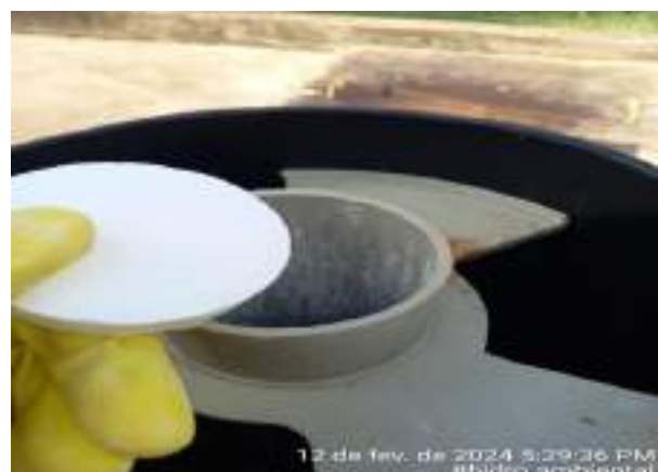
ADIÇÃO DE PASTILHA DE CLORO EMISSÁRIO FINAL
