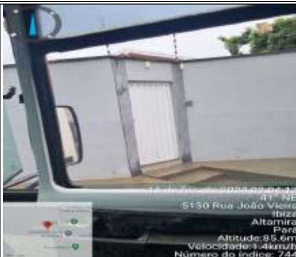
Figura 02: TRAVESSA JOÃO VIEIRA, 44
