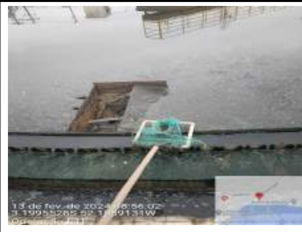
RETIRADA DE SOBRENADANTES DOS TANQUES DECANTADORES SECUNDÁRIOS
