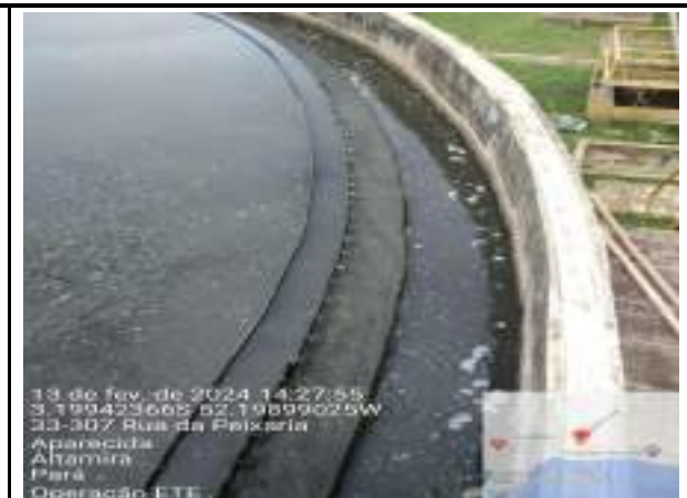
LIMPEZA DAS BORDAS DOS TANQUES DECANTADORES
