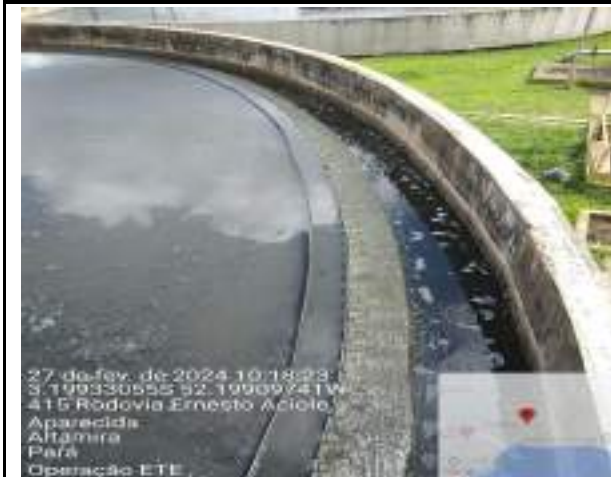
LIMPEZA DAS BORDAS DOS TANQUES DECANTADORES
