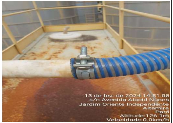
SUBSTITUIÇÃO DE BRAÇADEIRA ENFERRUJADA NA TUBULAÇÃO DE ABASTECIMENTO DO RESERVATÓRIO DE CLORO
