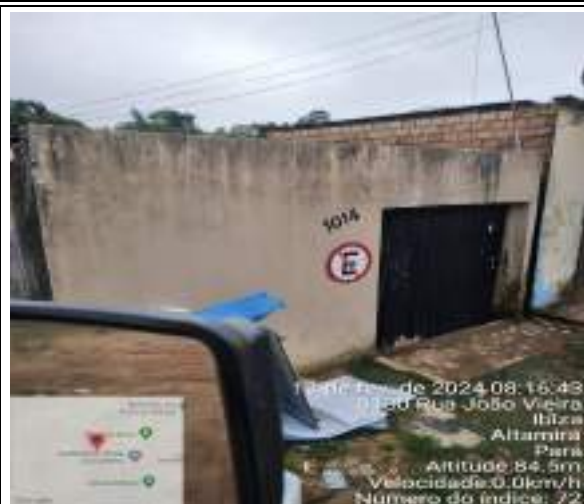
Figura 01: TRAVESSA JOÃO VIEIRA, 1014
