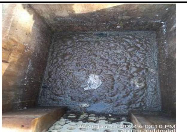
LIMPEZA DA CAIXA E DAS GRADES DE ENTRADA DO ESGOTO BRUTO
