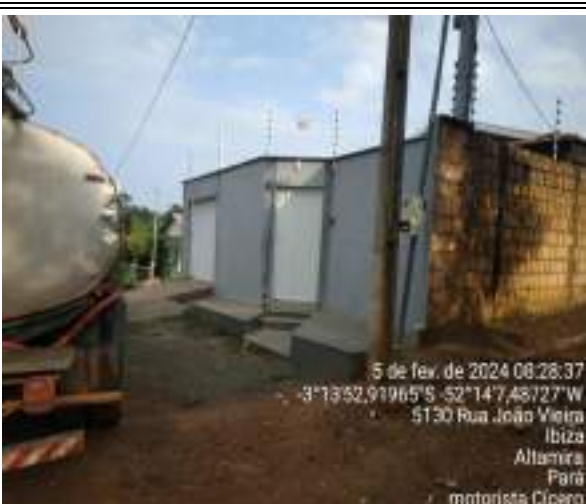
Figura 02: TRAVESSA JOÃO VIEIRA, 44
