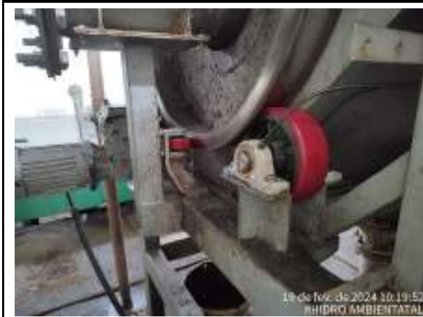
MONTAGEM DA RODA DA PONTE DO ADENSADOR DE LODO 2 DO TANQUE DECANTADOR SECUNDÁRIO LINHA B, E ALINHAMENTO DO MESMA
