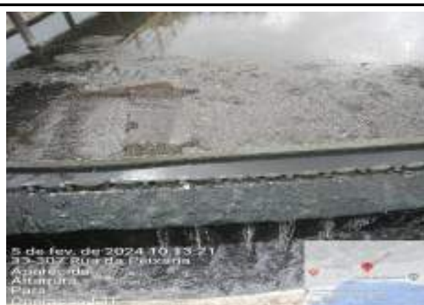
RETIRADA DE SOBRENADANTES DOS TANQUES DECANTADORES SECUNDÁRIOS
