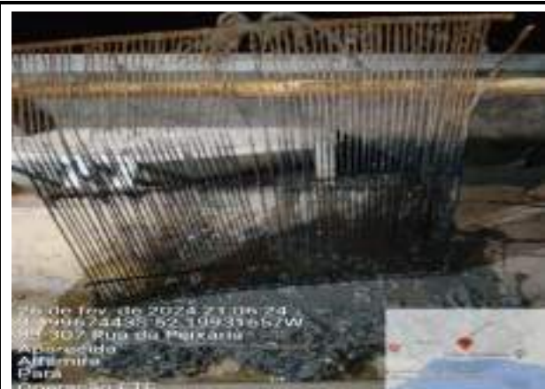
LIMPEZA DAS GRADES DE ENTRADA DO ESGOTO BRUTO
