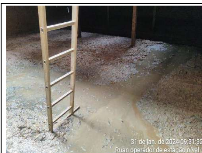
ATIVIDADE DE LIMPEZA E HIGIÊNIZAÇÃO DOS DECANTADORES ETA CONVENCIONAL (POÇO DA COLMÉIA)
