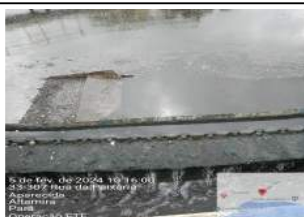
RETIRADA DE SOBRENADANTES DOS TANQUES DECANTADORES SECUNDÁRIOS
