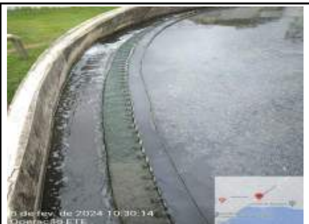
LIMPEZA DAS BORDAS DOS TANQUES DECANTADORES
