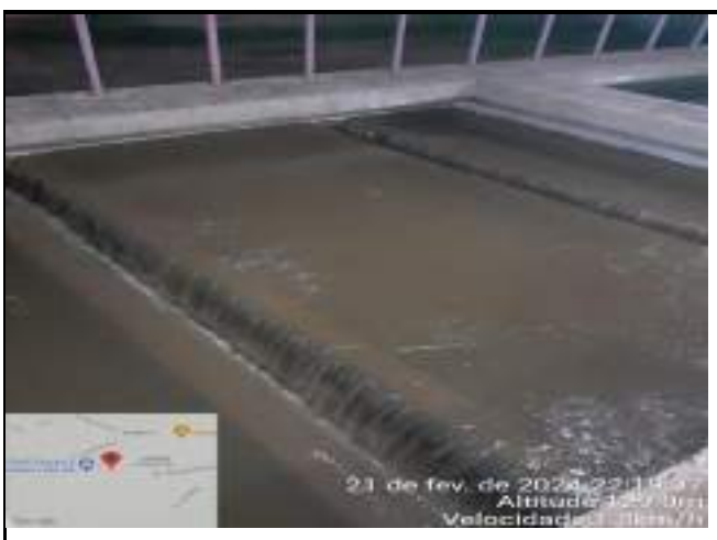
RETROLAVAGEM DOS FILTROS DE CONCRETO ETA CONVENCIONAL
