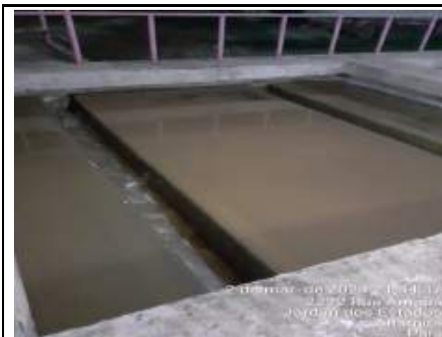
RETROLAVAGEM DOS FILTROS DE CONCRETO ETA CONVENCIONAL
