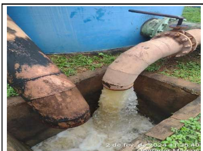
DESCARGA DE FUNDO NOS FILTROS DE METAL 02 e 03 DA VETA
