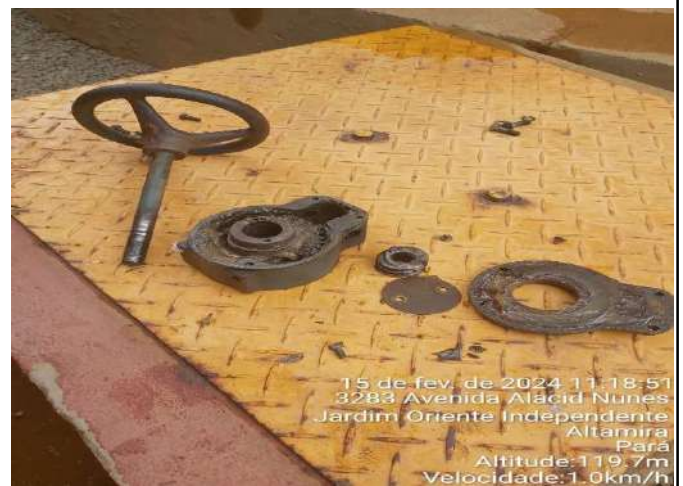
REMOÇÃO DO REGISTRO DE DESCARGA DO DECANTADOR 02 PARA MANUTENÇÃO
