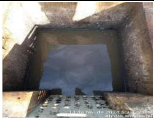
LIMPEZA DA CAIXA E DAS GRADES DE ENTRADA DO ESGOTO BRUTO
