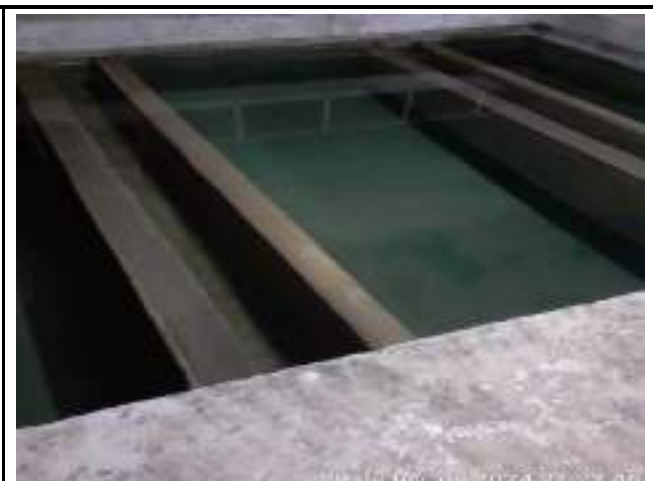
RETROLAVAGEM DOS FILTROS DE CONCRETO ETA CONVENCIONAL
