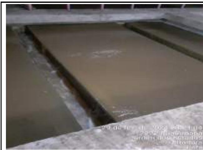
RETROLAVAGEM DOS FILTROS DE CONCRETO ETA CONVENCIONAL
