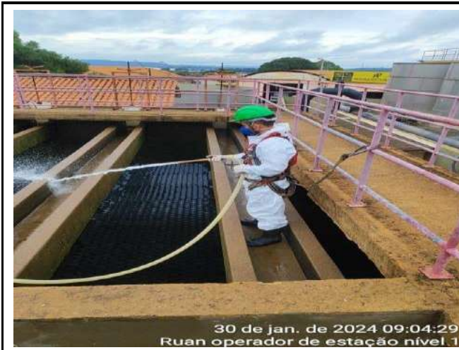
ATIVIDADE DE LIMPEZA E HIGIÊNIZAÇÃO DOS DECANTADORES 02 e 01 ETA CONVENCIONAL
