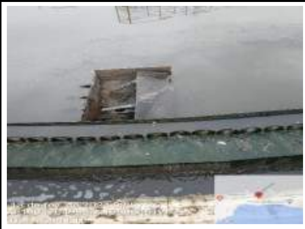
RETIRADA DE SOBRENADANTES DOS TANQUES DECANTADORES SECUNDÁRIOS
