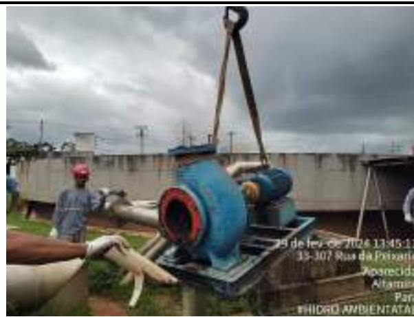
RETIRADA DA BOMBA DE RECIRCULAÇÃO DA LINHA B PARA MANUTENÇÃO E LIMPEZA
