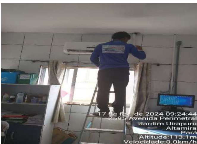
LIMPEZA E MANUTENÇÃO DA CENTRAL DE AR DA SALA DE GERADORES DA ETA MODULAR
