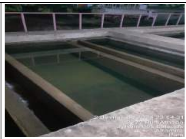
RETROLAVAGEM DOS FILTROS DE CONCRETO ETA CONVENCIONAL
