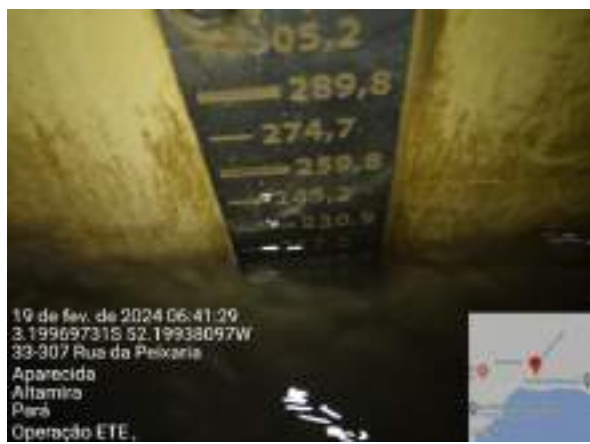
MONITORAMENTO DA VASÃO
