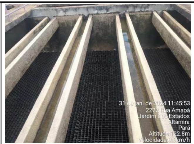
ATIVIDADE DE LIMPEZA E HIGIÊNIZAÇÃO DOS DECANTADORES ETA CONVENCIONAL (COLMÉIA)
