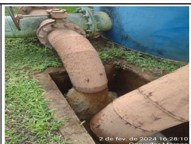
DESCARGA DE FUNDO NOS FILTROS DE METAL 02 e 03 DA VETA
