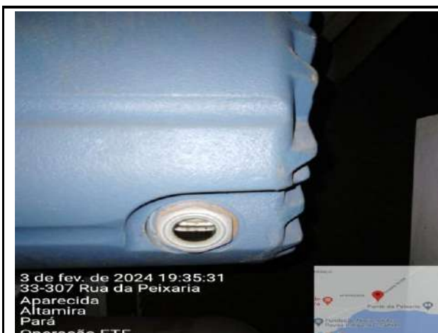
VERIFICAÇÃO DO ÓLEO DO SOPRADOR
