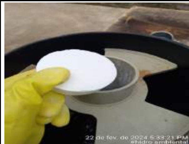
ADIÇÃO DE PASTILHA DE CLORO EMISSÁRIO FINAL
