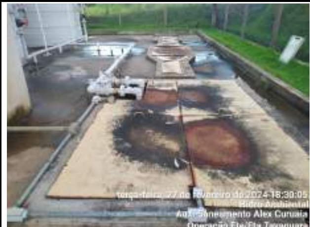
LIMPEZA INTERNA DA ESTAÇÃO
