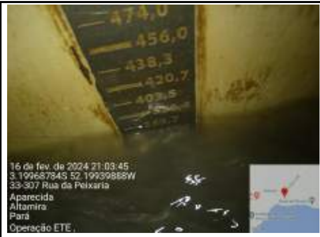
MONITORAMENTO DA VASÃO LINHA A
