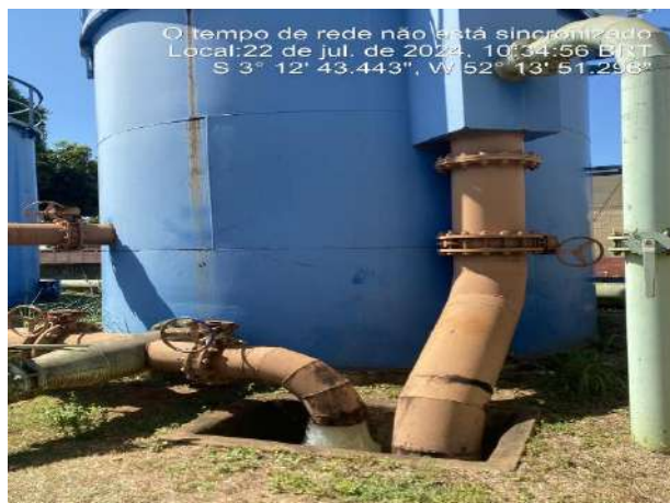
DESCARGA DE FUNDO DOS FOLTROS DE METAL – ETA CONVENCIONAL – 22/07/24
