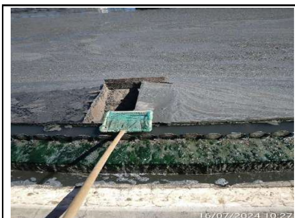
RETIRADA DE SOBRENADANTES DOS TANQUES DECANTADORES SECUNDÁRIOS
