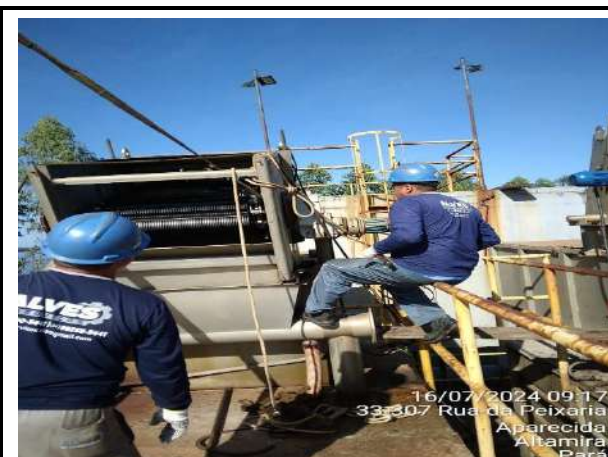
RETIRADA DO MOTO REDUTOR DA GRADE DO KOMBI DA LINHA B PARA MANUTENÇÃO
