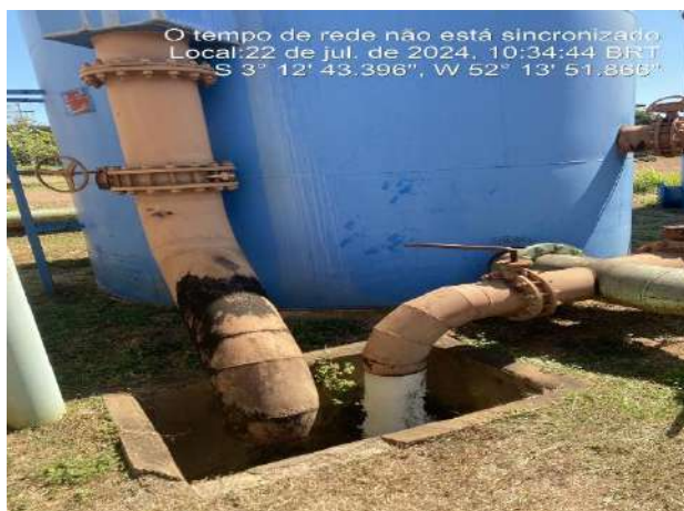
DESCARGA DE FUNDO DOS FOLTROS DE METAL – ETA CONVENCIONAL – 22/07/24
