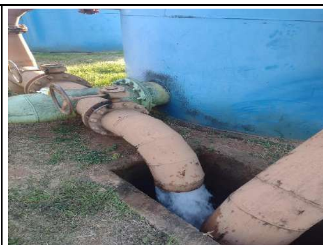
DESCARGA DE FUNDO DOS FOLTROS DE METAL – ETA CONVENCIONAL
