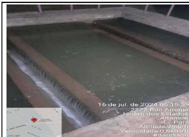
RETROLAVAGEM DOS FILTROS DE CONCRETO – ETA CONVENCIONAL
