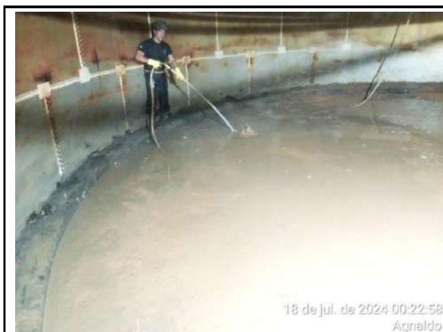
LIMPEZA DO POÇO DO DECANADOR 1 ETA MODULAR
