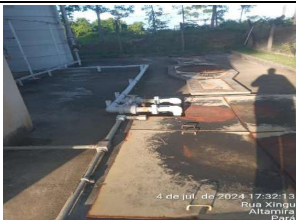
LIMPEZA DA ÁREA INTERNA DA ESTAÇÃO
