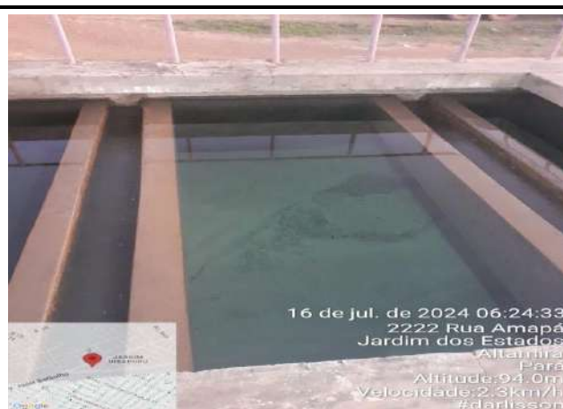
RETROLAVAGEM DOS FILTROS DE CONCRETO – ETA CONVENCIONAL
