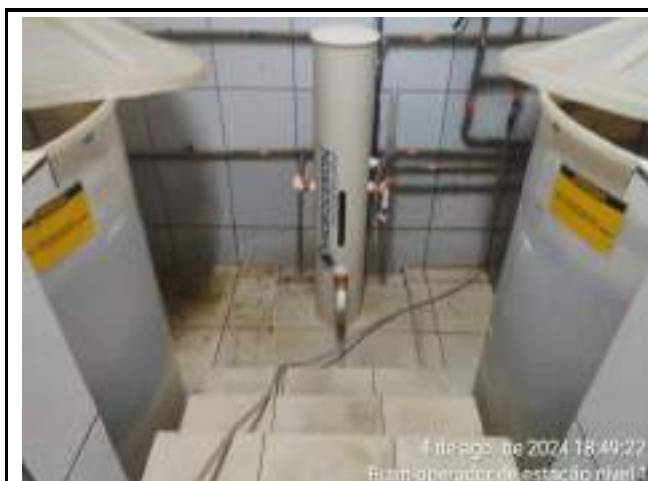
ABASTECIMENTO DAS TINAS DE SAL
