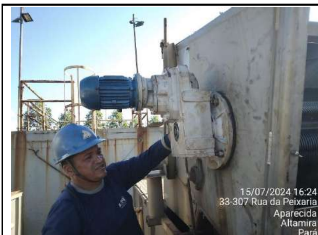
TROCA DO MODO REDUTOR DA GRADE LINHA A
