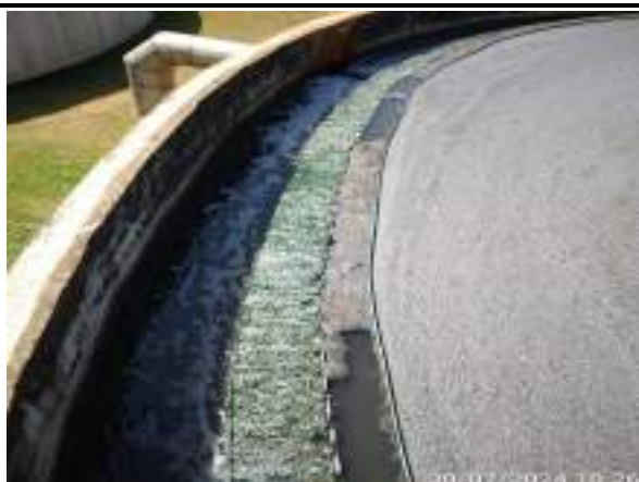
LIMPEZA DAS BORDAS DOS TANQUES DECANTADORES
