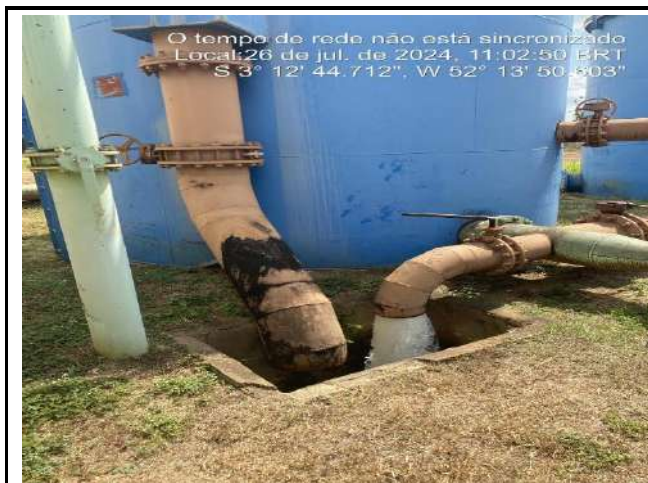
DESCARGA DE FUNDO DOS FILTROS DE METAL – ETA CONVENCIONAL – 25/07/24
