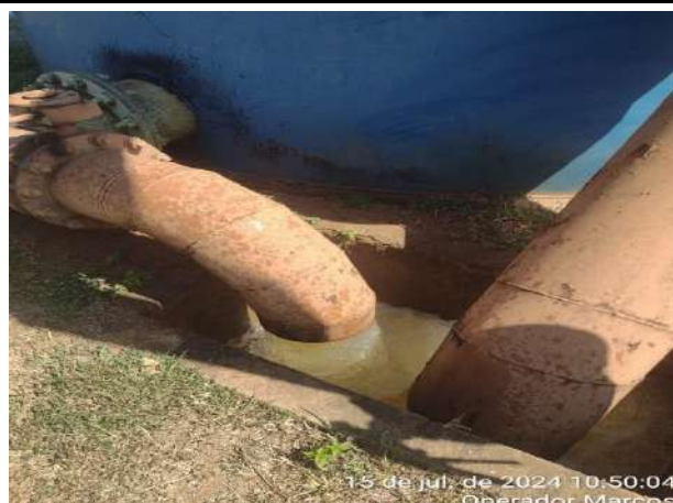
DESCARGA DE FUNDO DOS FOLTROS DE METAL – ETA CONVENCIONAL
