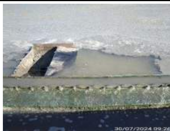
RETIRADA DE SOBRENADANTES DOS TANQUES DECANTADORES SECUNDÁRIOS
