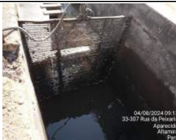
LIMPEZA DAS GRADES DE ENTRADA DO ESGOTO BRUTO
