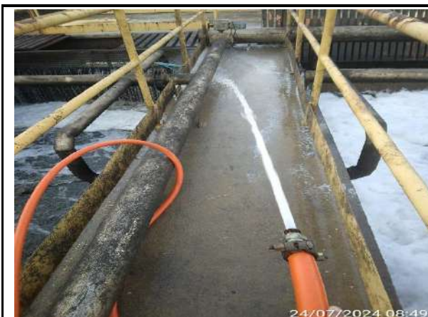
LAVAGEM E LIMPEZA NA ESTRUTURA E NOS TANQUES AERADOS
