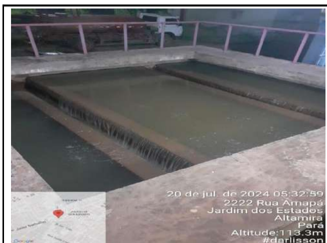
RETROLAVAGEM DOS FILTROS DE CONCRETO – ETA CONVENCIONAL
