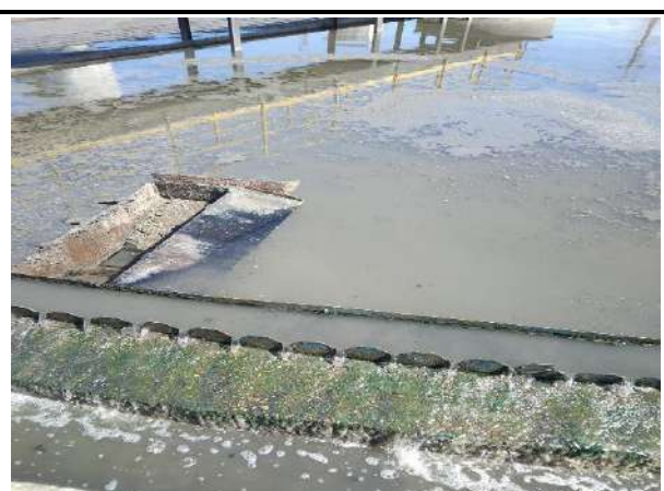
RETIRADA DE SOBRENADANTES DOS TANQUES DECANTADORES SECUNDÁRIOS
