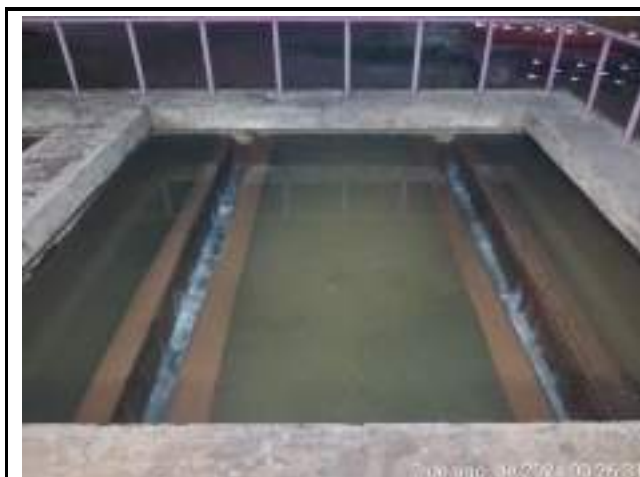
RETROLAVAGEM DOS FILTROS DE CONCRETO – ETA CONVENCIONAL
