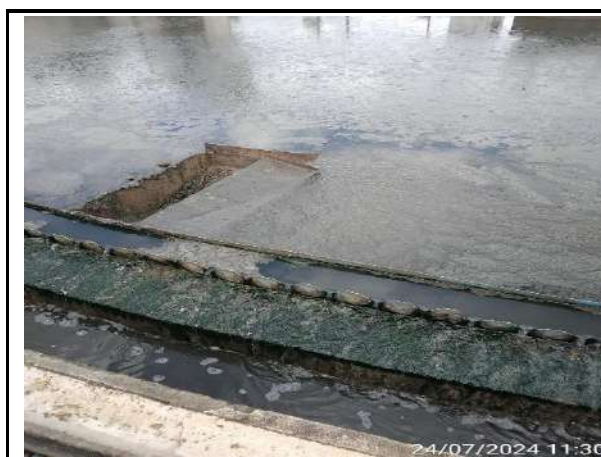
RETIRADA DE SOBRENADANTES DOS TANQUES DECANTADORES SECUNDÁRIOS
