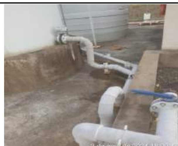
TROCA DA ABRACEDEIRA Q SEGURA A TUBULAÇÃO
