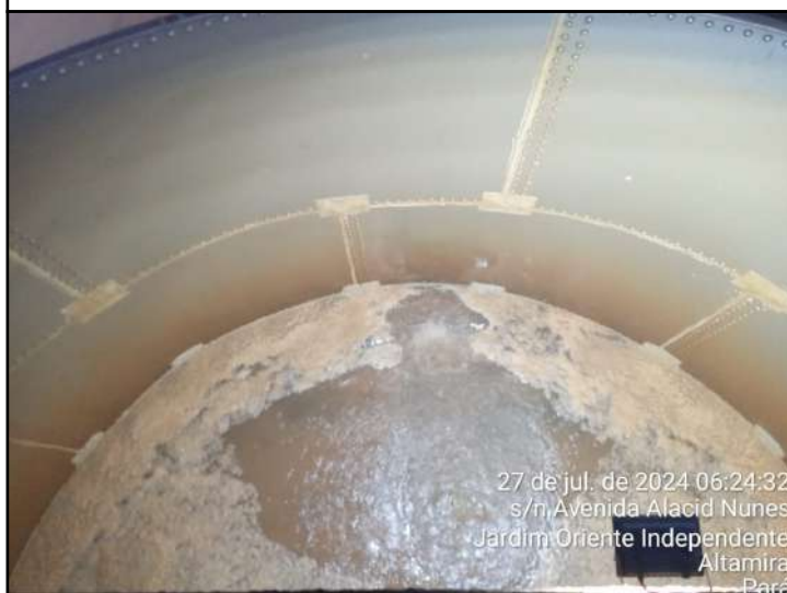
3: LAVAGEM DOS FILTROS
