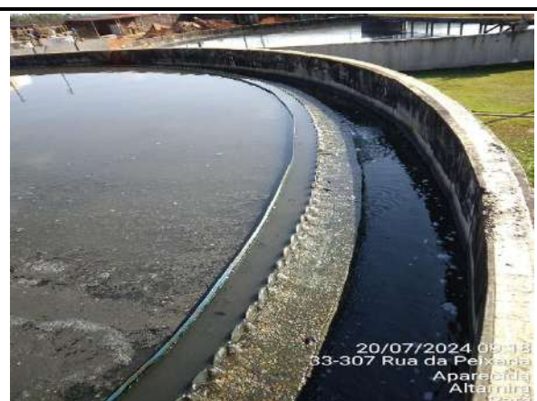
LIMPEZA DAS BORDAS DOS TANQUES DECANTADORES SECUNDÁRIOS
