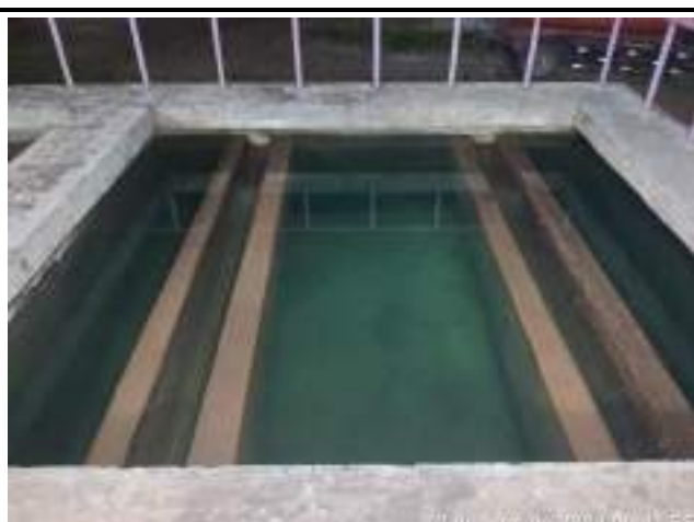
RETROLAVAGEM DOS FILTROS DE CONCRETO – ETA CONVENCIONAL
