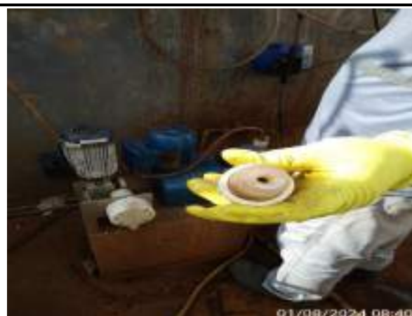
MANUTENÇÃO E CONERTO DA CONEXÃO DA DOSADORA DE BARRILHA QUE ESTAVA QUEBRADO
