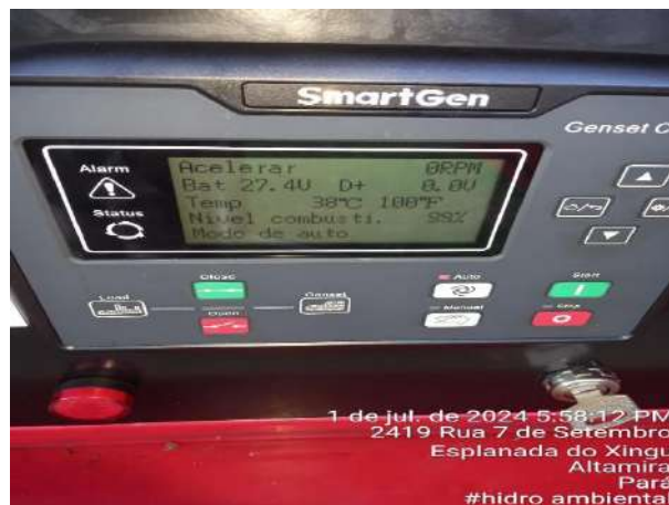
NÍVEL DO ÓLEO DO GERADOR
