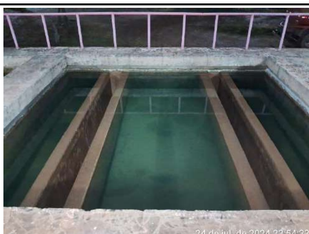
RETROLAVAGEM DOS FILTROS DE CONCRETO – ETA CONVENCIONAL
