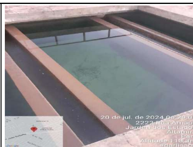
RETROLAVAGEM DOS FILTROS DE CONCRETO – ETA CONVENCIONAL
