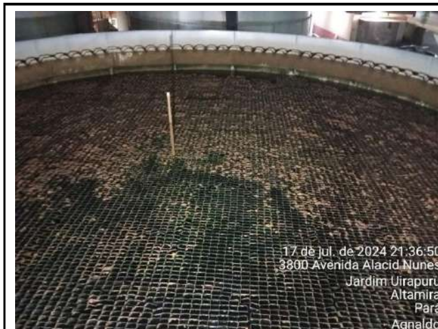
LIMPEZA DO DECANTADOR 1 ETA MODULAR - COLMÉIA
