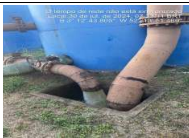
DESCARGA DE FUNDO DOS FILTROS DE METAL – ETA CONVENCIONAL
