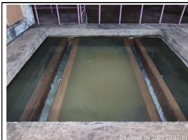
RETROLAVAGEM DOS FILTROS DE CONCRETO – ETA CONVENCIONAL
