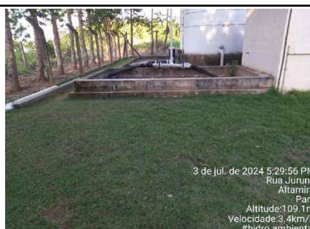
LIMPEZA DO PÁTIO DA ESTAÇÃO
