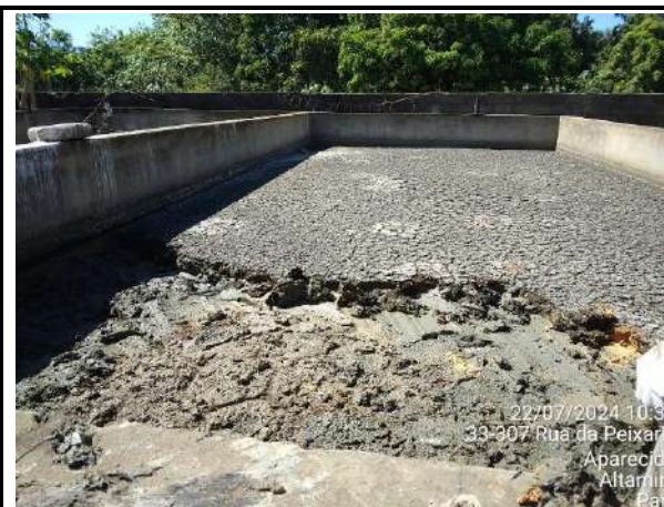
LIMPEZA DO TANQUE DO LEITO DE SECAGEM
