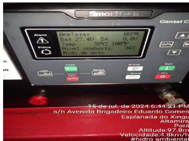
NÍVEL DO ÓLEO DO GERADOR
