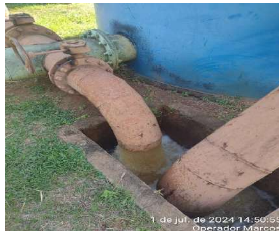
DESCARGA DE FUNDO DOS FOLTROS DE METAL – ETA CONVENCIONAL
