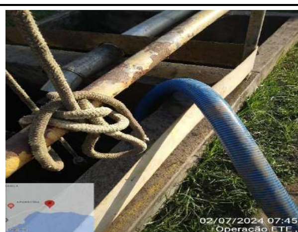
SUCÇÃO DA CAIXA DE ESPUMA DOS TANQUES DECANTADORES
