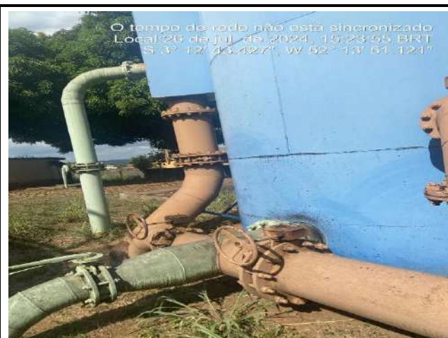
DESCARGA DE FUNDO DOS FILTROS DE METAL – ETA CONVENCIONAL – 25/07/24
