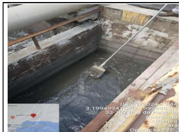
LIMPEZA DAS ENTRADAS DOS TANQUES AERADOS
