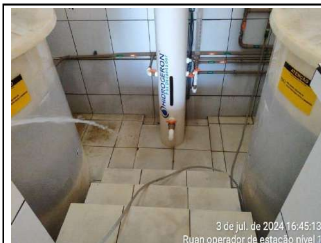
ABASTECIMENTO DAS TINAS DE SAL
