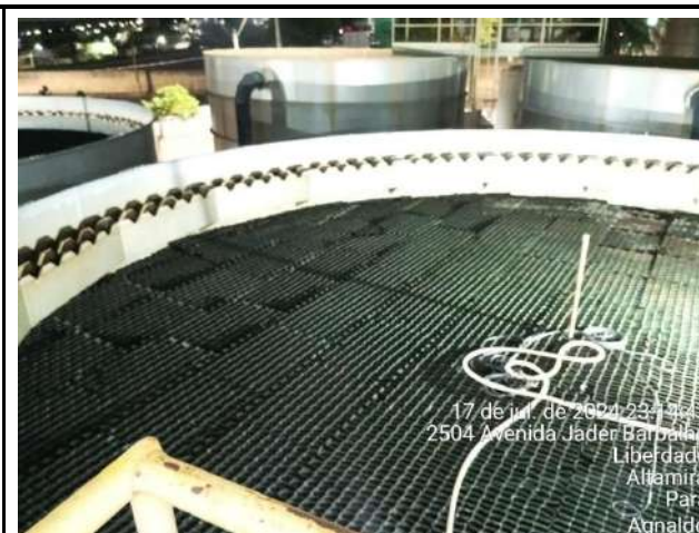
LIMPEZA DO DECANTADOR 1 ETA MODULAR - COLMÉIA
