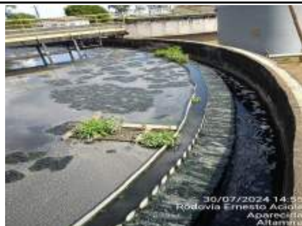
LIMPEZA DAS BORDAS DOS TANQUES DECANTADORES
