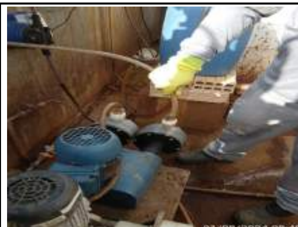
MANUTENÇÃO E CONERTO DA CONEXÃO DA DOSADORA DE BARRILHA QUE ESTAVA QUEBRADO
