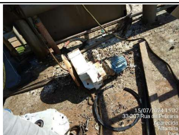
TROCA DO MODO REDUTOR DA GRADE LINHA A
