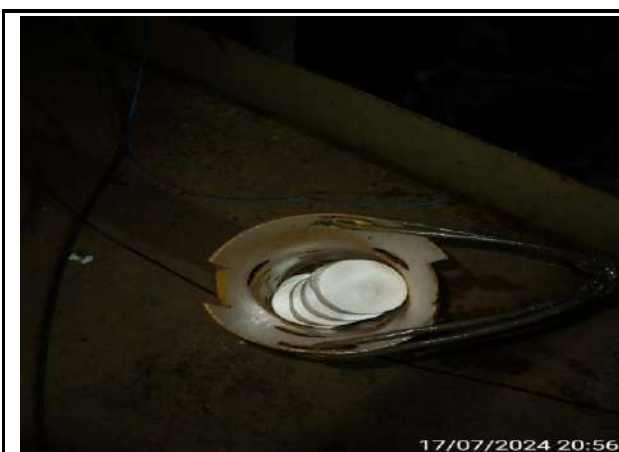
ADIÇÃO DE PASTILHA DE CLORO EMISSÁRIO FINAL
