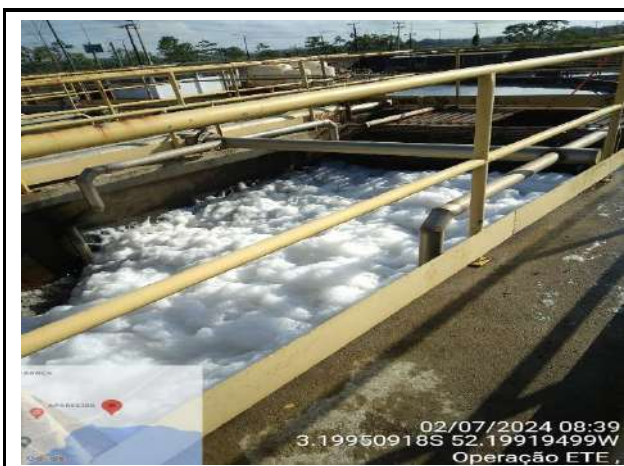
SUCÇÃO DA CAIXA DE ESPUMA DOS TANQUES DECANTADORES
