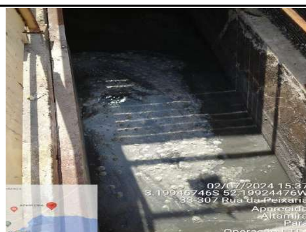
LIMPEZA DA ENTRADA DOS TANQUES AERADOS
