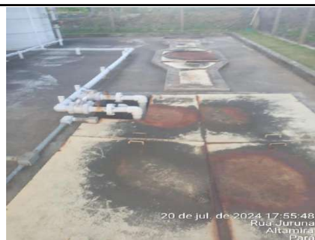
LIMPEZA DA ÁREA INTERNA DA ESTAÇÃO
