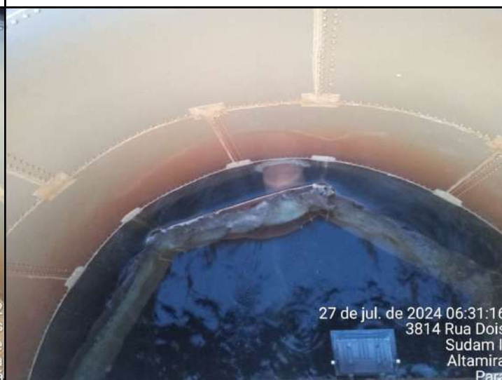
4: LAVAGEM DOS FILTROS
