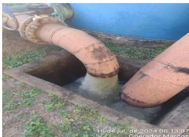
DESCARGA DE FUNDO DOS FOLTROS DE METAL – ETA CONVENCIONAL
