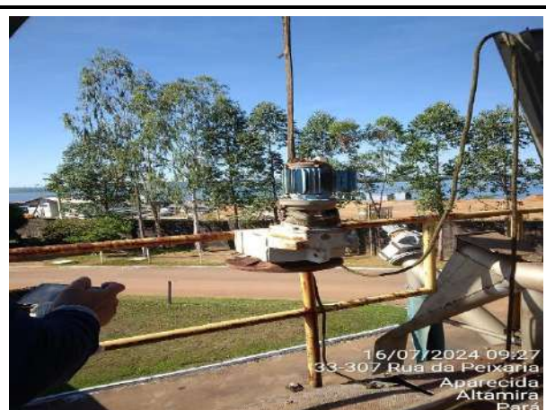
RETIRADA DO MOTO REDUTOR DA GRADE DO KOMBI DA LINHA B PARA MANUTENÇÃO
