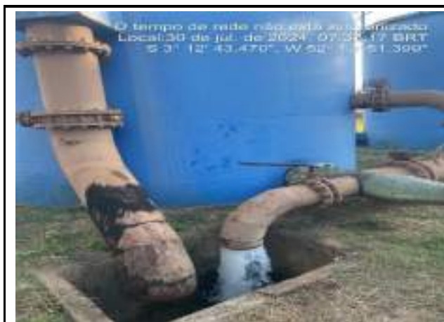
DESCARGA DE FUNDO DOS FILTROS DE METAL – ETA CONVENCIONAL
