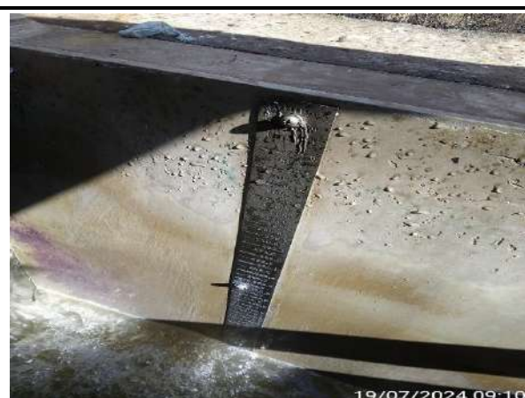
MONITORAMENTO DA VASÃO LINHA A
