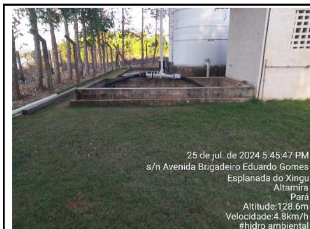
LIMPEZA DO PÁTIO ESTAÇÃO
